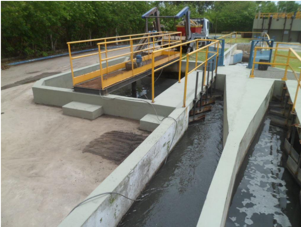
Foto 06 – Entrada do Esgoto para os Desarenadores Divididos por Comportas
