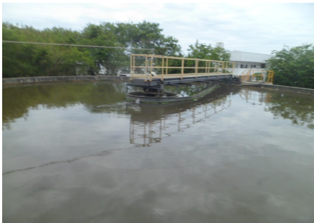
Foto 15 – Decantador (vista superior)
