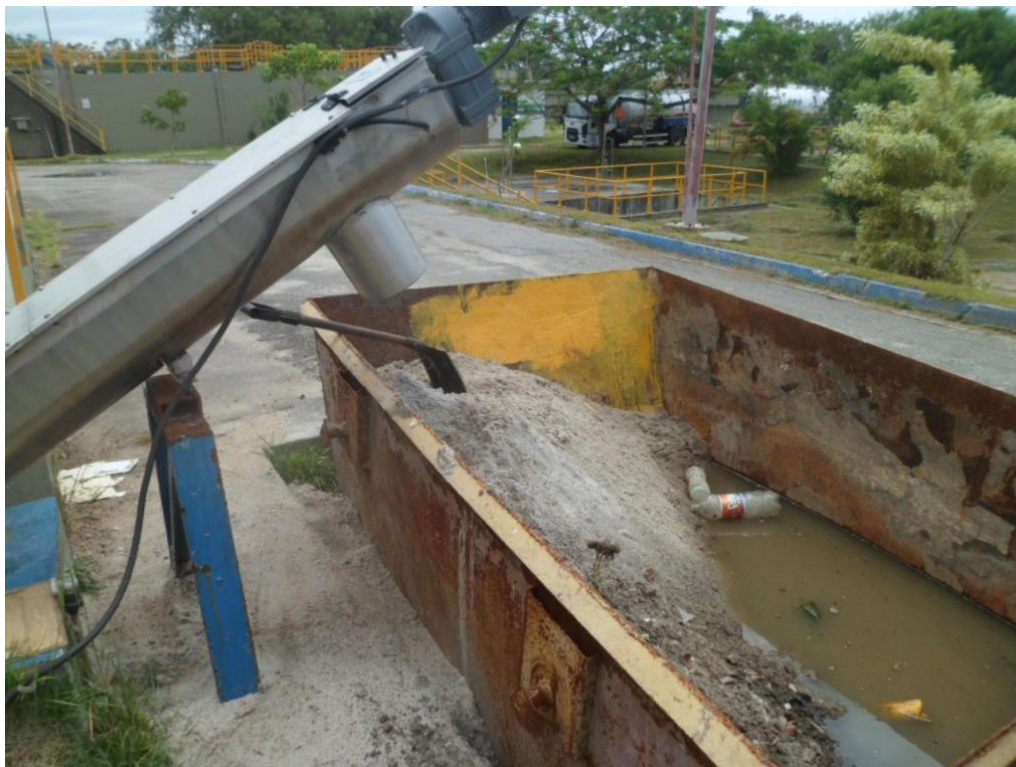
Foto 09 – Rosca Transportadora Direciona Areia para a Caçamba.
