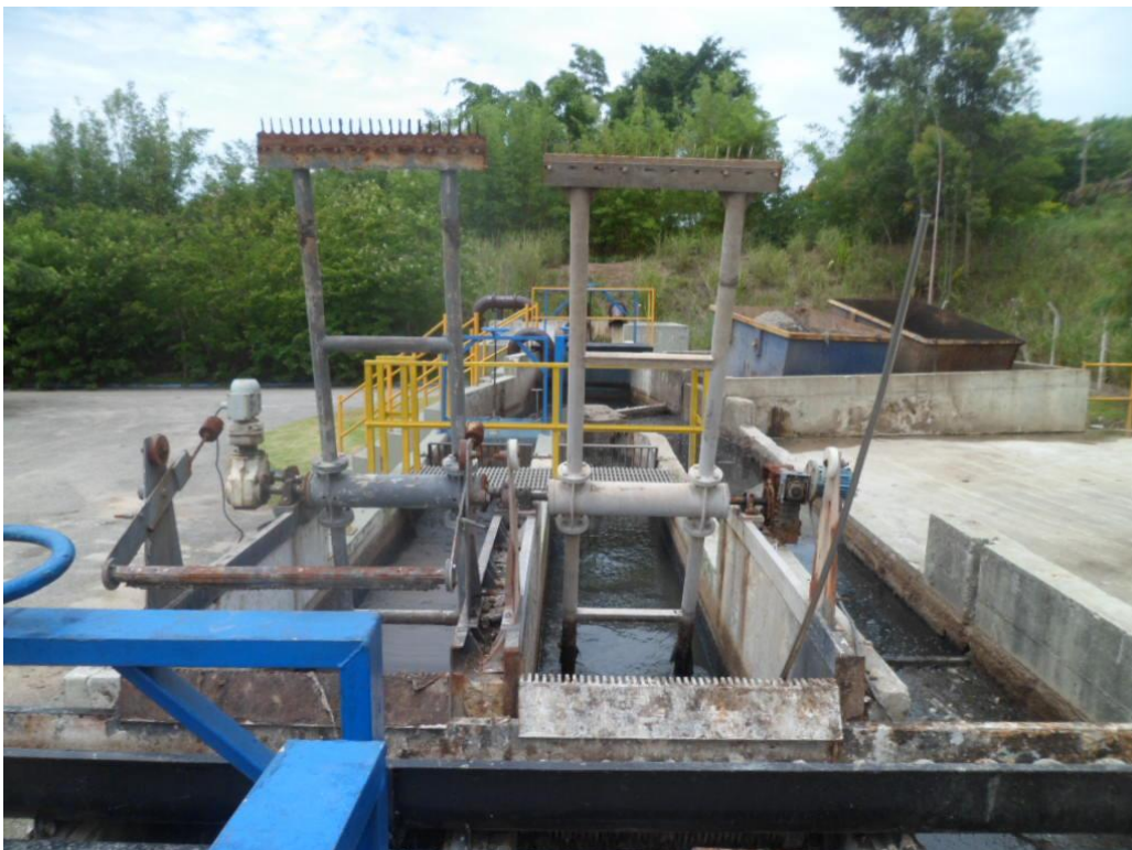
Foto 05 – Gradeamento Mecanizado Lançando Resíduos Sólidos na Caçamba
