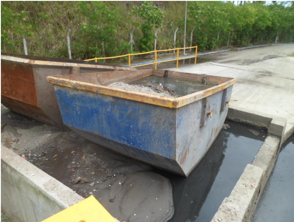
Foto 08 – Caçamba de Recebimento de Caminhão Limpa Fossa
