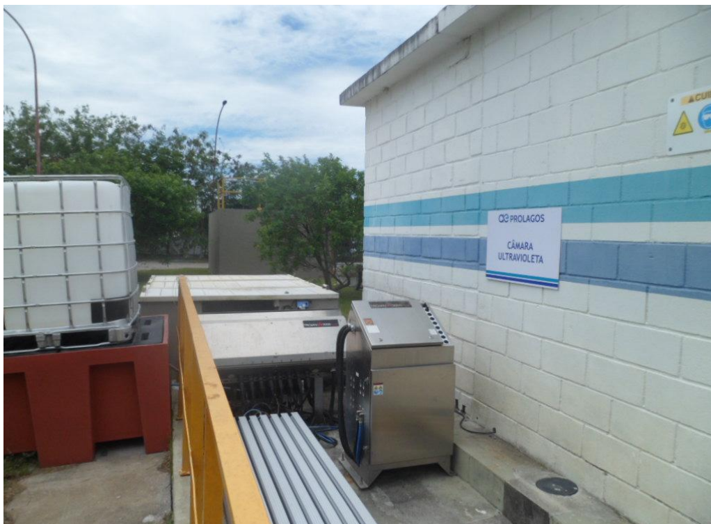
Foto 20 – Câmara Ultravioleta
