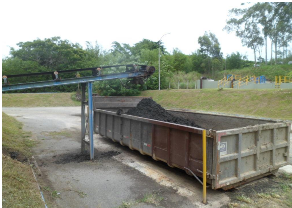
Foto 17 – Esteira de Retirada do Lodo e Lançamento na Caçamba
