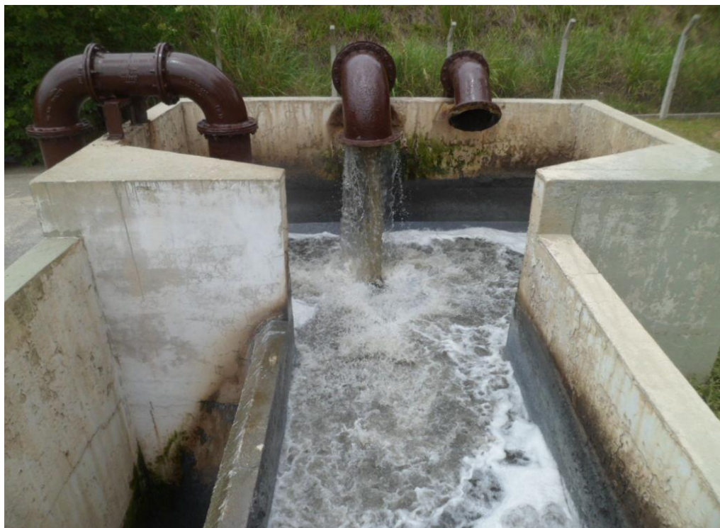
Foto 03 – Entrada do Esgoto Bruto In Natura 120 l/s
