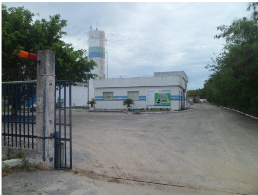
Foto 01 – Entrada da ETE São Pedro da Aldeia
