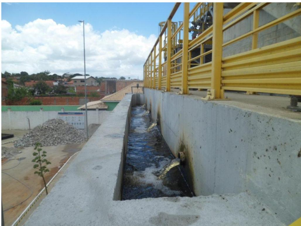
Foto 09 – Saída do Tanque de Decantação Primária
