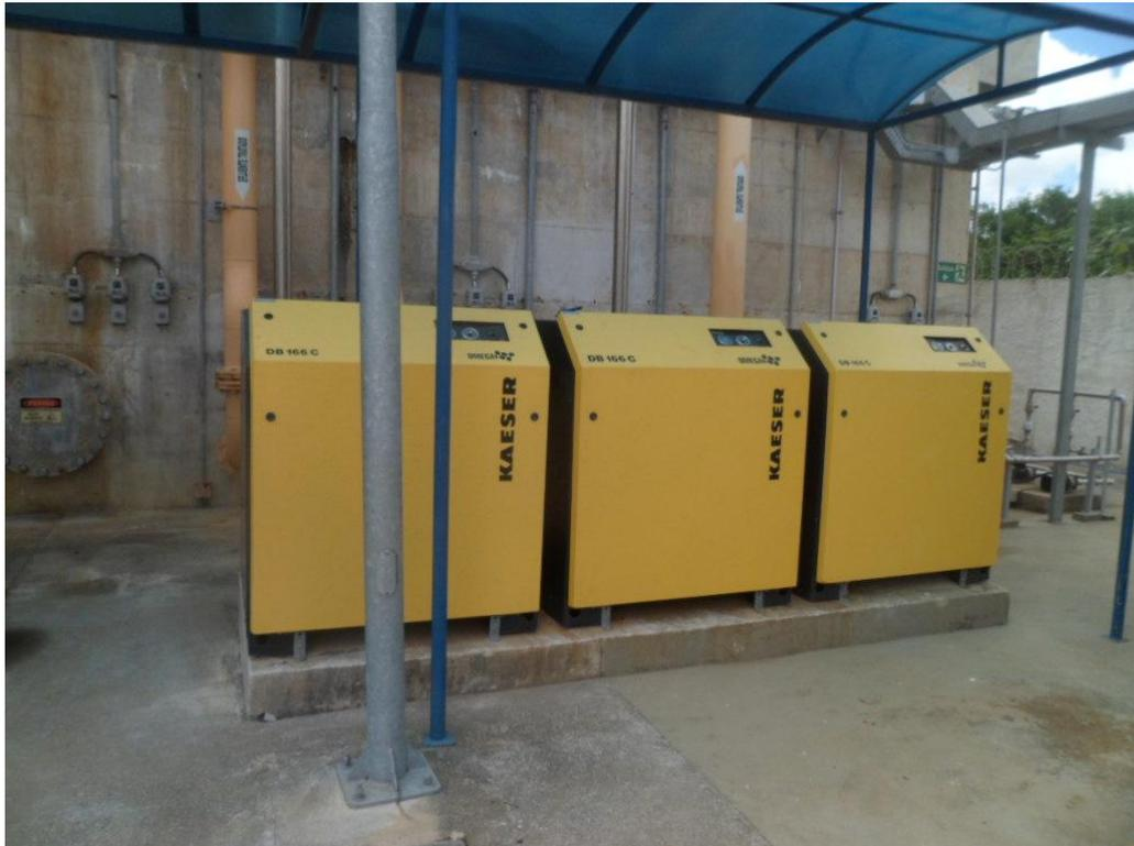
Foto 14 – Sopradores que Lançam Carga de Ar nos Aeradores
