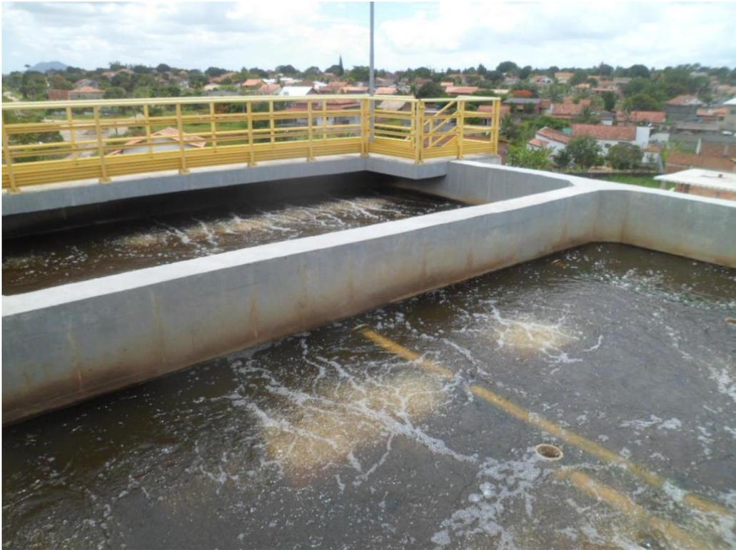
Foto 12 – Tanques de Aeração
