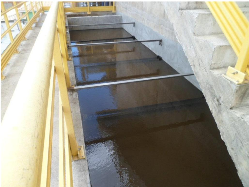
Foto 08 – Tanque de Decantação Primária
