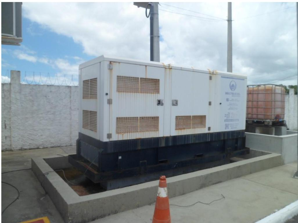
Foto 21 – Gerador e Reservatório de Diesel
