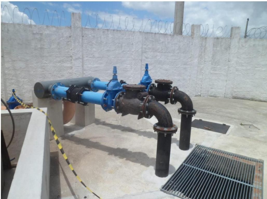
Foto 23 – Elevatória do Tanque de efluente despejado por Caminhão Vacoll
