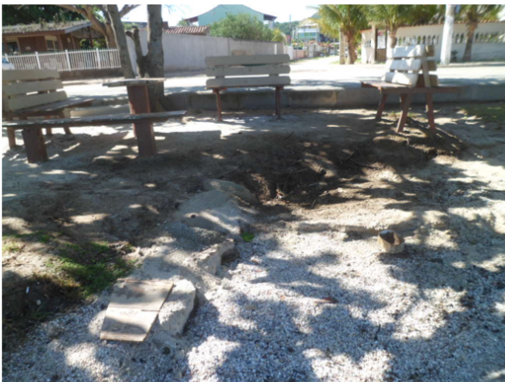
Foto 04 – Vista da manilha em frente a Rua Dr. Tocantins
