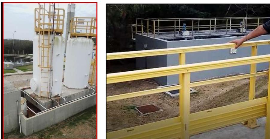
Figura 10 – Tratamento físico-químico: tanques de produtos químicos com PAC para remoção de fósforo (imagem da esquerda); e Dois Floculadores **fora de uso** (imagem da direita)
