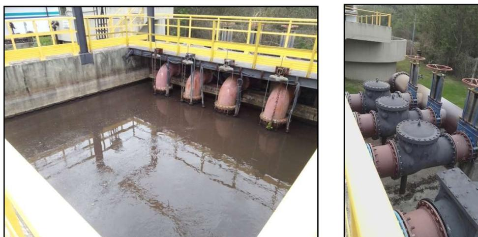
Figura 15 – Tanque anóxico: saída do esgoto para o tratamento secundário
