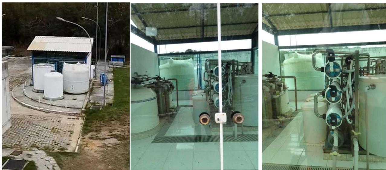
Figura 24 – Estação de Tratamento de Água de Reuso - ETAR (fora de uso)
