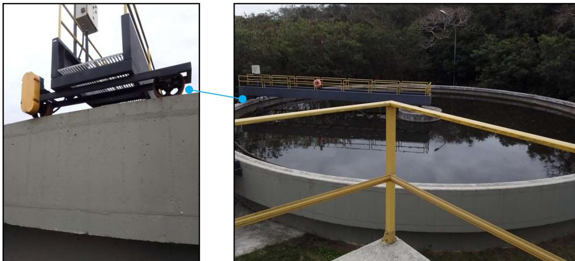
Figura 17 – Decantador secundário 2, com destaque para a plataforma giratória (à esquerda)
