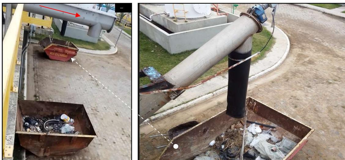
Figura 6 – Roscas transportadoras para resíduos sólidos e areia e as caçambas coletoras
