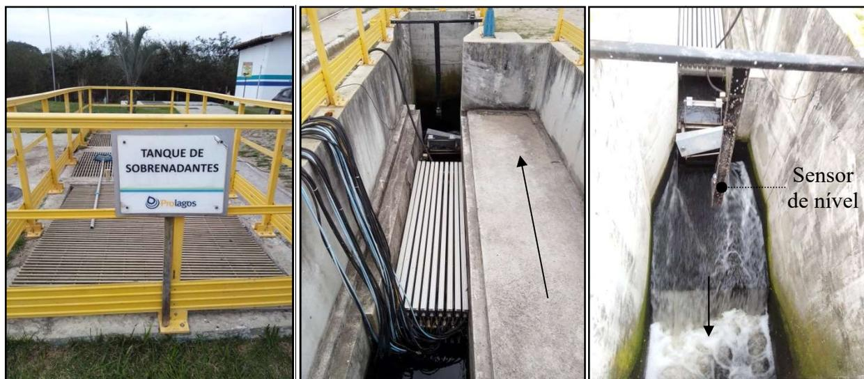
Figura 25 – Tratamento terciário: desinfecção com lâmpadas ultravioleta, com destaque para a comporta de controle de nível para manter o equipamento sempre em contato com o efluente final
