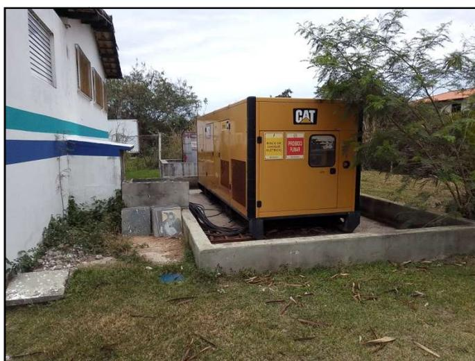
Figura 27 – Gerador a diesel, com tanque combustível em baia de contenção ao fundo
