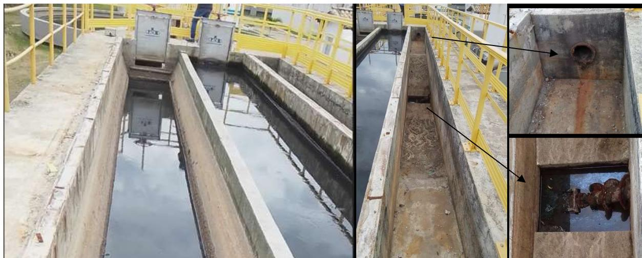
Figura 7 – Três desarenadores (caixas de areia), sendo um **fora de carga** (canal mais a direita)
