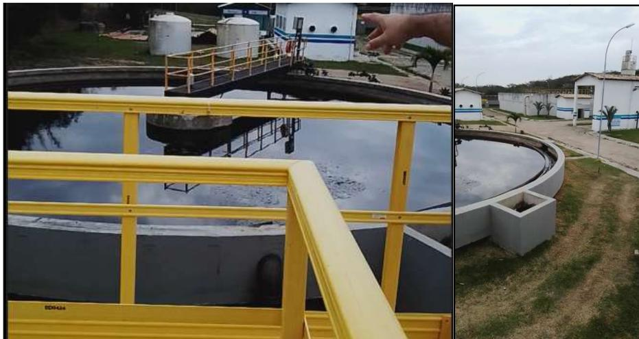
Figura 9 – Decantador Primário (fora de carga, ou seja, by-passado)
