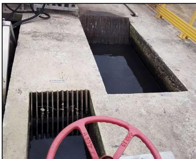
Figura 4 – Grades de limpeza manual para retenção de resíduos sólidos grosseiros e finos
