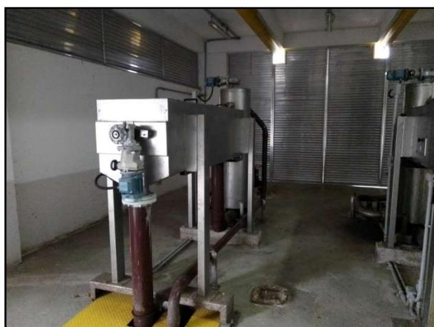
Figura 20 – Tratamento do lodo: adensador gravimétrico **desativado** e elevatória de lodo adensado (imagem da esquerda) e dois adensadores mecânicos em funcionamento (imagem da direita)
