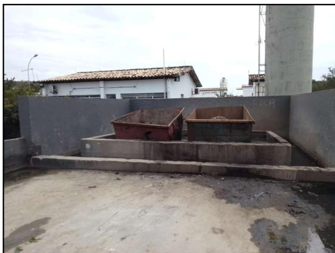
Figura 2 – Caçambas de recebimento de caminhões limpa-fossa. Mesmo com duas baias internas de contenção, ainda ocorre o despejo de **lodo no solo**
