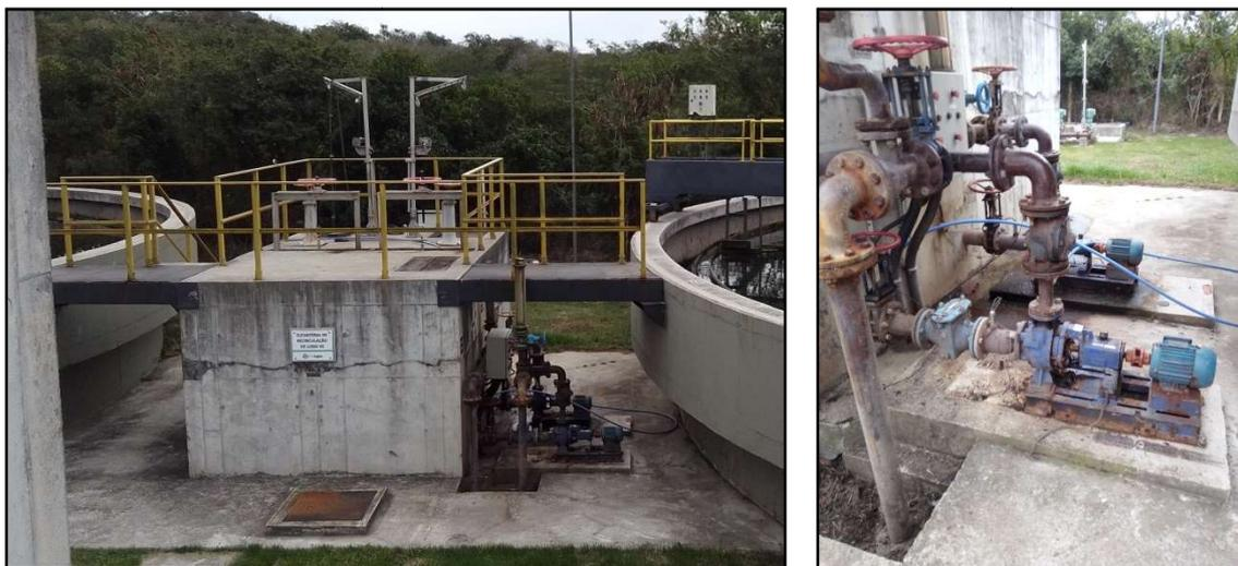
Figura 18 – Elevatória de recirculação de lodo dos decantadores 1 e 2. Destaque para **corrosão**
