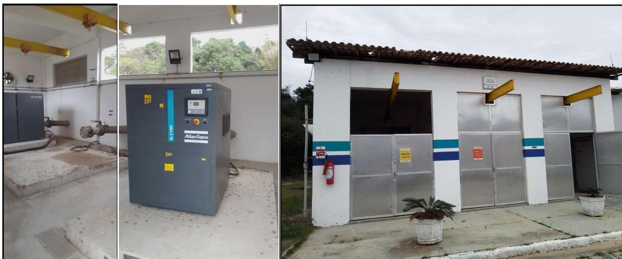
Figura 13 – Sala dos sopradores de ar para os tanques de aeração (vistas interna e externa)
