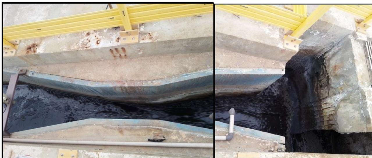
Figura 8 – Calha parshall com medidor de vazão ultrassônico e régua **ilegível**. Destaque para o ponto de aplicação do PAC (tratamento químico) e para a parede com **armadura exposta**
