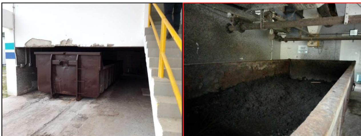
Figura 22 – Armazenamento de Lodo na Caçamba (vistas frontal e interna)
