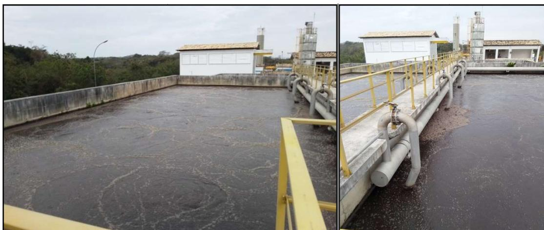
Figura 11 – Dois tanques de aeração com difusores de bolha fina
