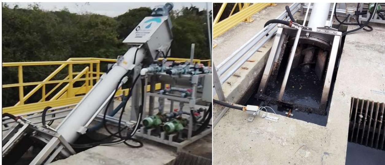
Figura 5 – Peneira rotativa (**fora de carga**) para lançar os resíduos sólidos para caçamba
