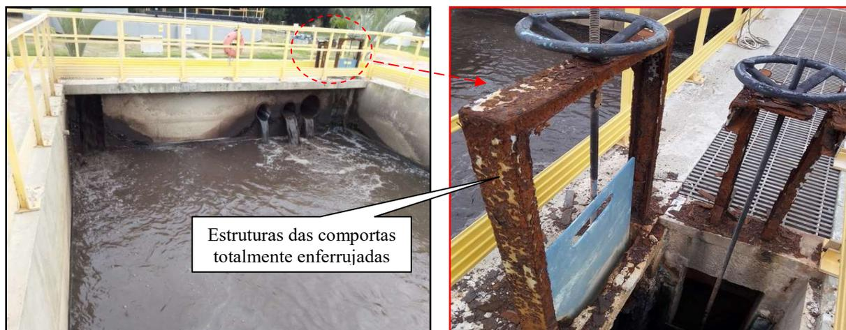
Figura 14 – Tanque anóxico: entrada do esgoto bruto e do lodo recirculado (imagem da esquerda).
