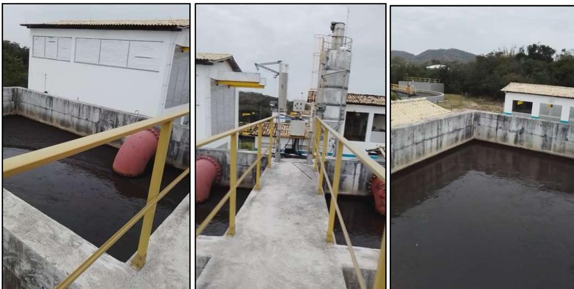
Figura 12 – Câmaras anóxicas anexas aos tanques de aeração
