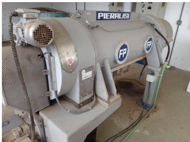
Figura 21 - Tratamento do lodo: desidratação com duas centrífugas
