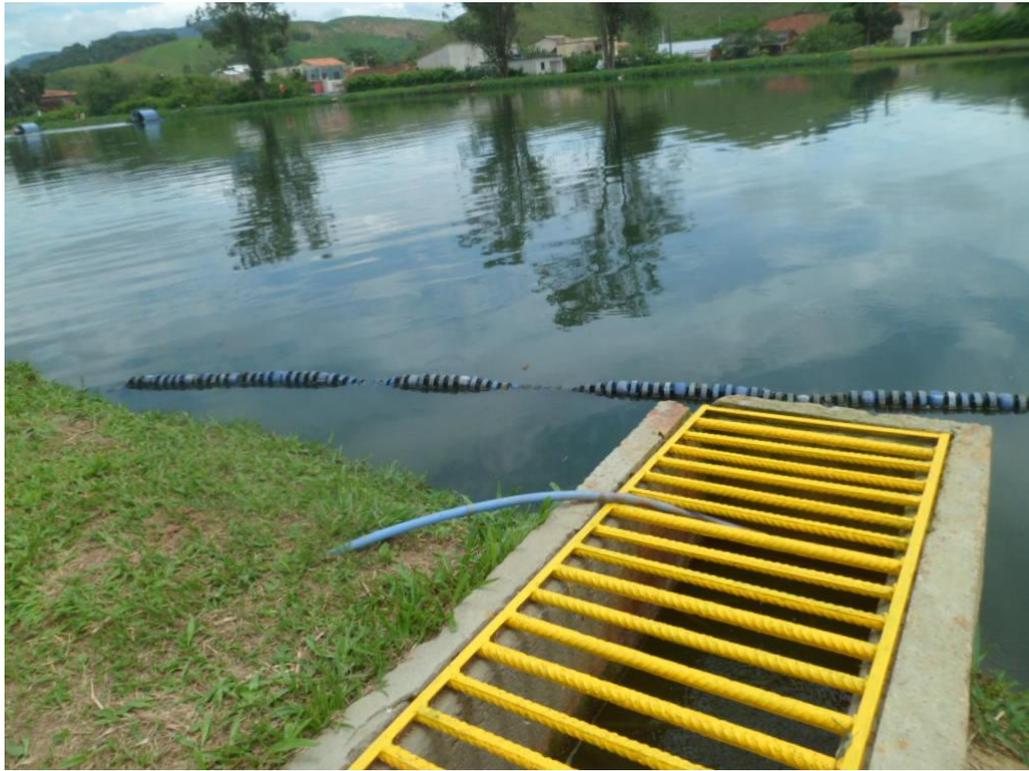
Foto 13 – Passagem da Lagoa de Aeração para a Lagoa de Sedimentação
