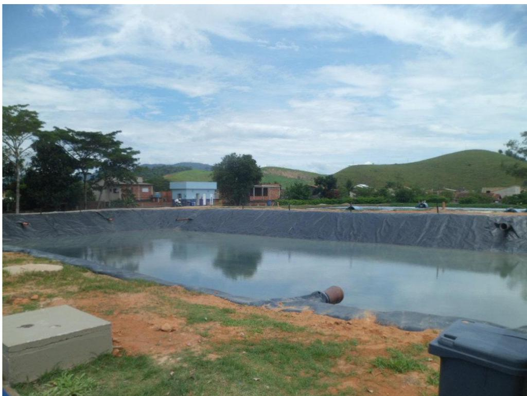
Foto 18 – Remoção de Lodo, Manutenção e Impermeabilização de uma das Lagoas de Aeração
