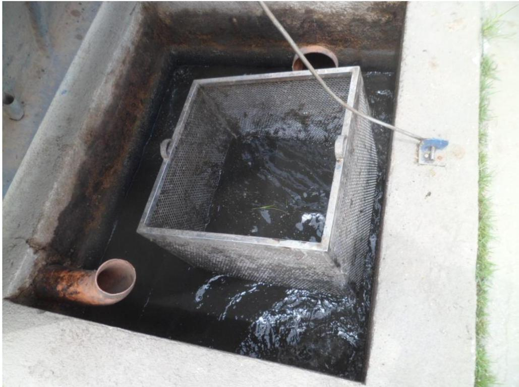
Foto 03 – Entrada do Esgoto In Natura nas Caixa Gradeada
