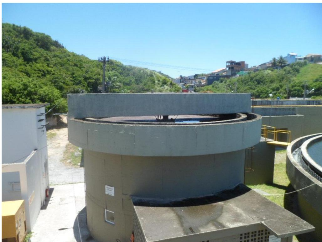
Foto 15 – Tanque Adensador de Lodo
