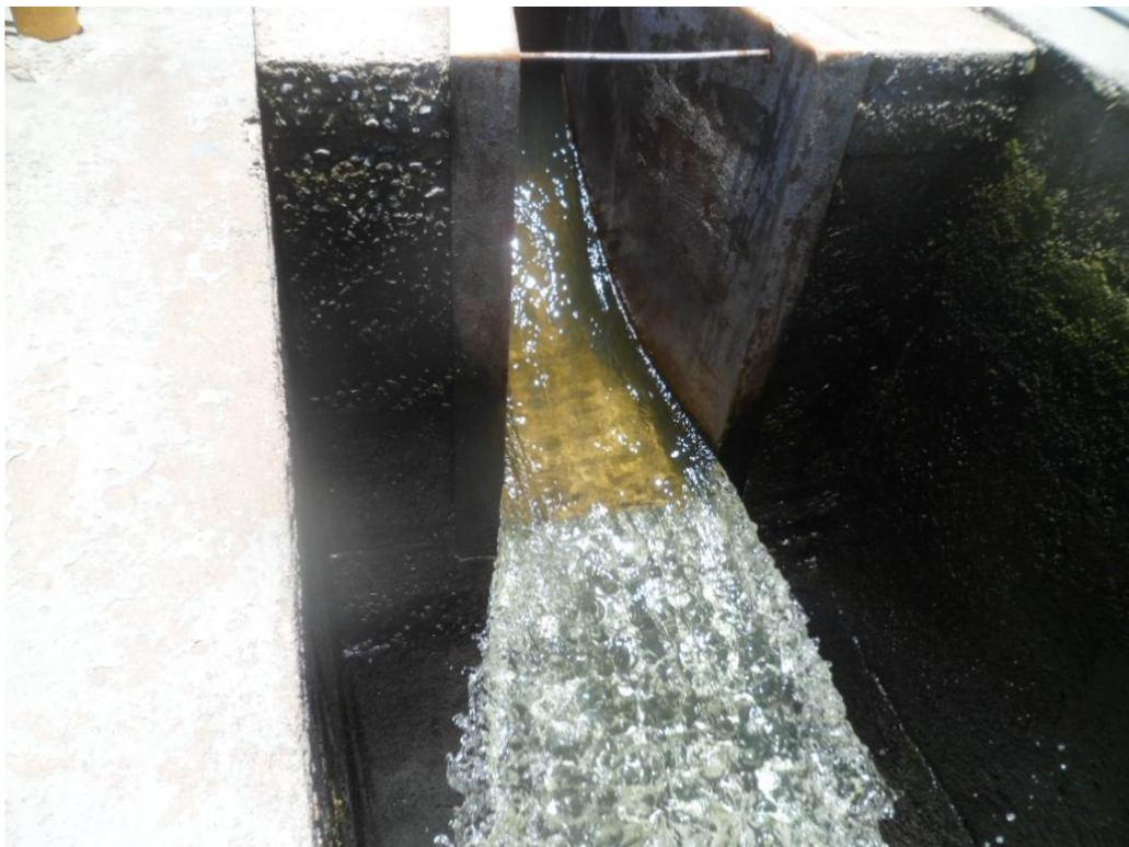
Foto 19 – Calha Parshall, Saída do Esgoto Tratado
