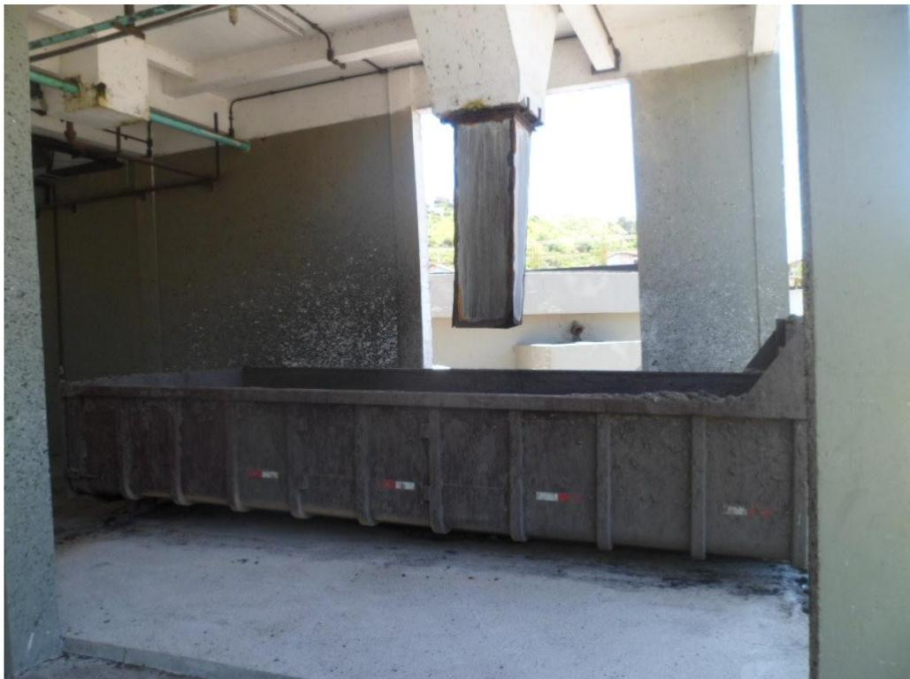
Foto 17 – Retirada do lodo e lançamento na caçamba (7m<sup>3</sup> dia)
