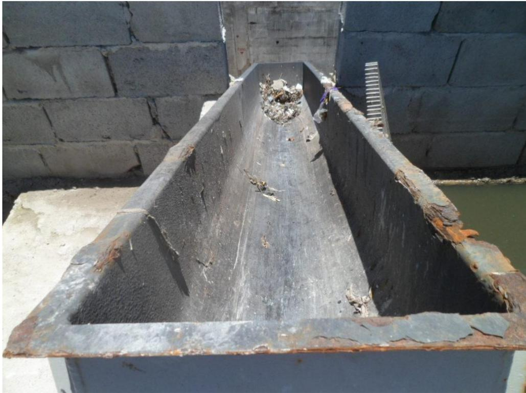
Foto 08 – Gradeamento e Retenção de Resíduos Sólidos para Caçamba
