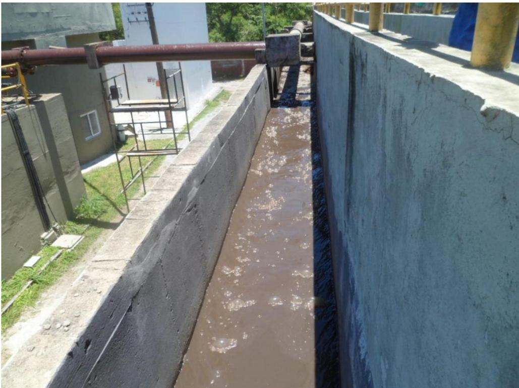
Foto 13 – Saída do Tanque de Aeração para o Decantador
