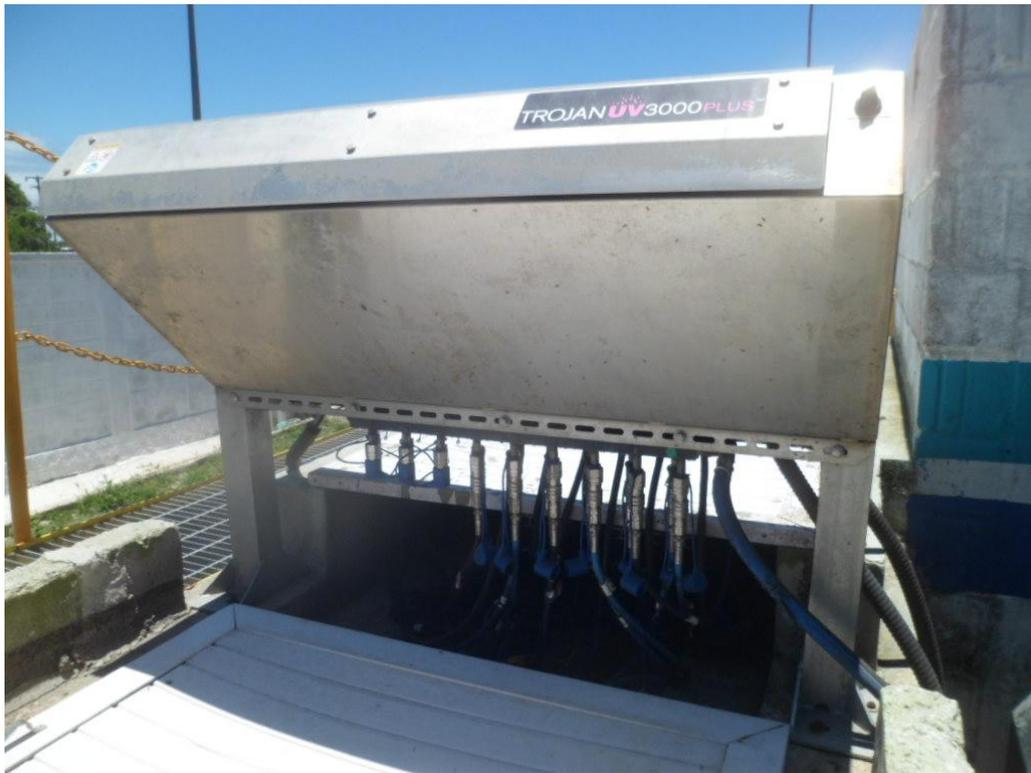
Foto 18 – Sistema Ultravioletas para Desinfecção
