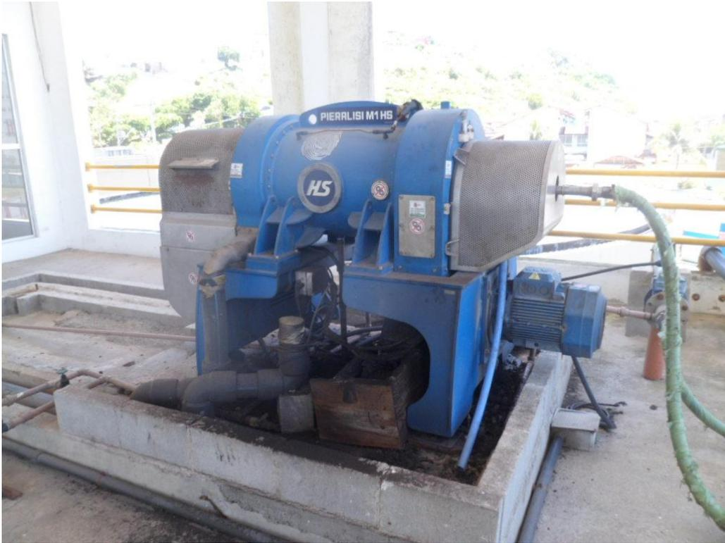
Foto 16 – Adensador Mecânico (Centrifuga)
