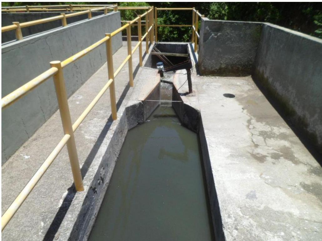
Foto 09 – Calha Parshall com Medidor de Vazão Ultrassônico
