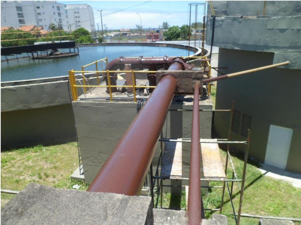
Foto 12 – Tubulação de Recirculação de Lodo Ativado
