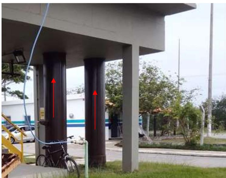
Figura 1 – Tubulações de entrada do esgoto bruto
