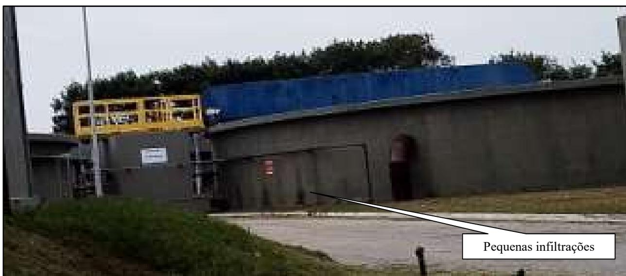
Figura 8 – Dois decantadores circulares com raspadores de escuma na parte superior e de lodo na parte inferior (vistas superiores e lateral). Destaque para **pequenas infiltrações** nas paredes
