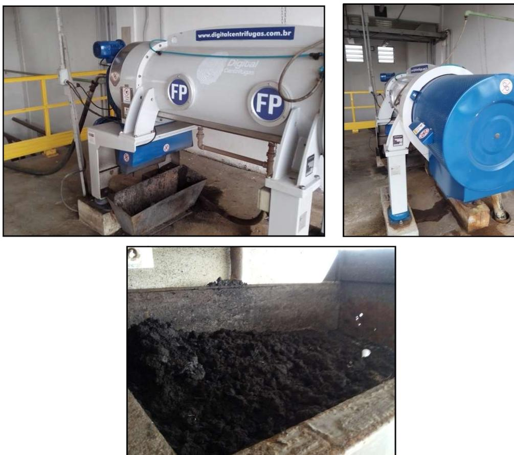
Figura 14 – Centrífuga para desidratação de lodo (imagens superiores) e caçamba com o lodo desidratado (imagem inferior)
