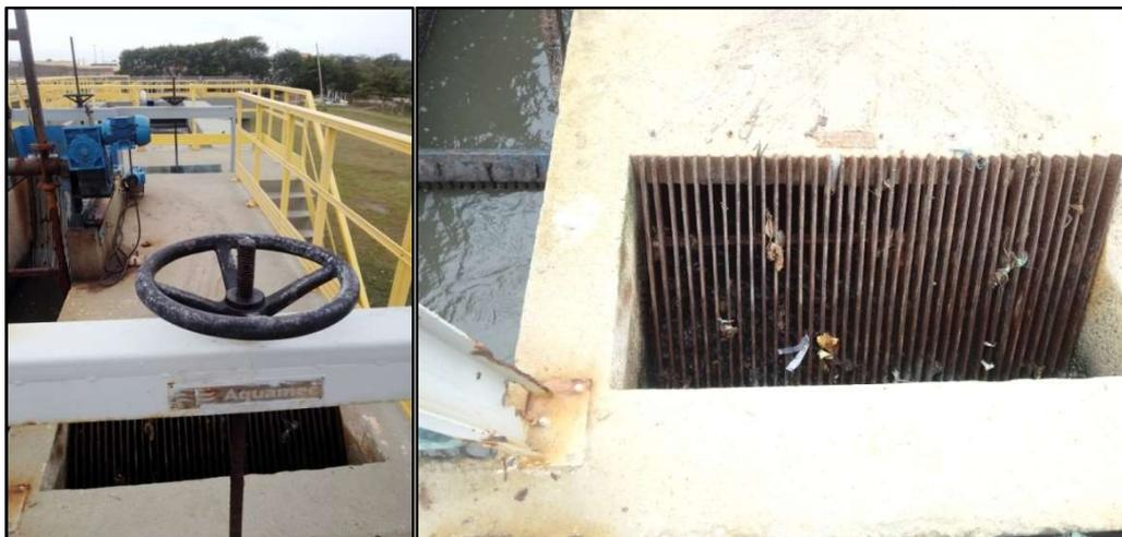
Figura 2 – Gradeamento de limpeza manual para retenção e retirada de resíduos sólidos
