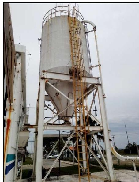
Figura 12 – Baias de contenção e armazenamento dos produtos químicos utilizados na ETE (imagem da esquerda) e silo **desativado** de hidróxido de cálcio ou cal (imagem da direita)
