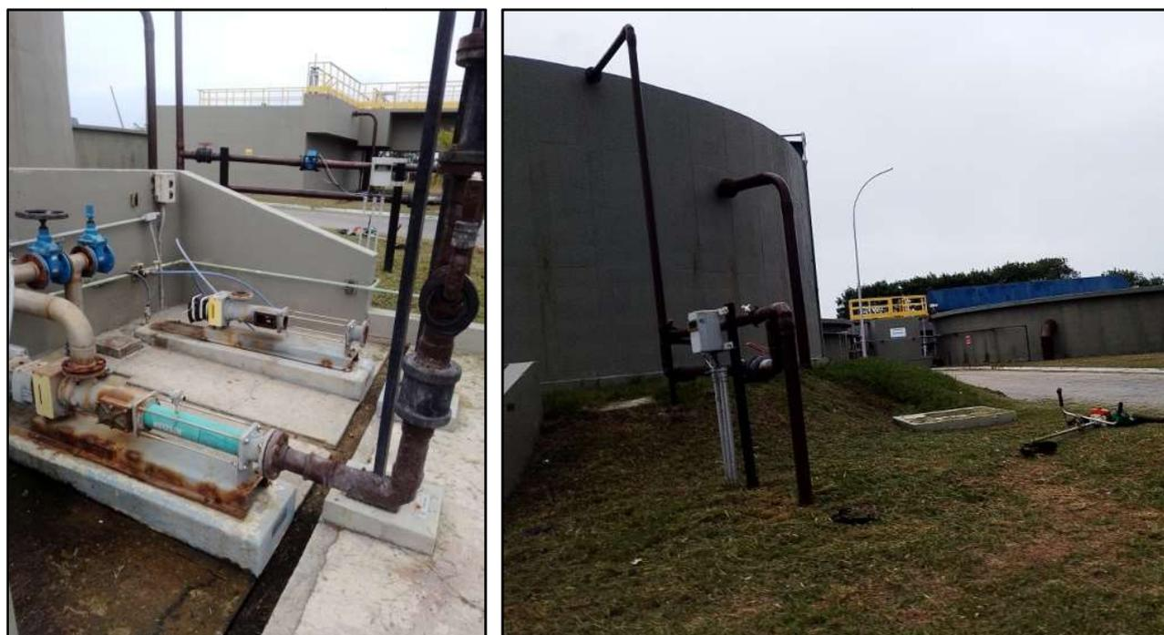
Figura 10 – Elevatória de lodo adensado e adensador (vista lateral). Observa-se a **falta de uma bomba** de lodo e que as bases, carcaças, tubos, conexões e válvulas estão **enferrujados**
