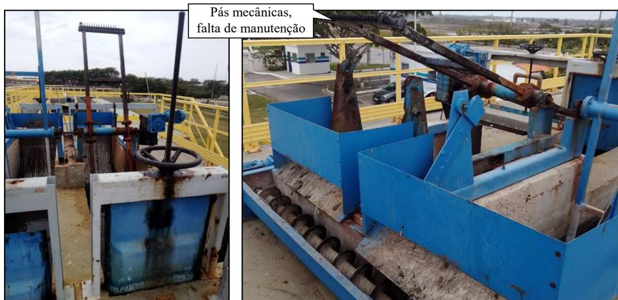
Figura 3 – Dois gradeamentos para retenção e retirada de resíduos, limpeza por pás mecânicas
