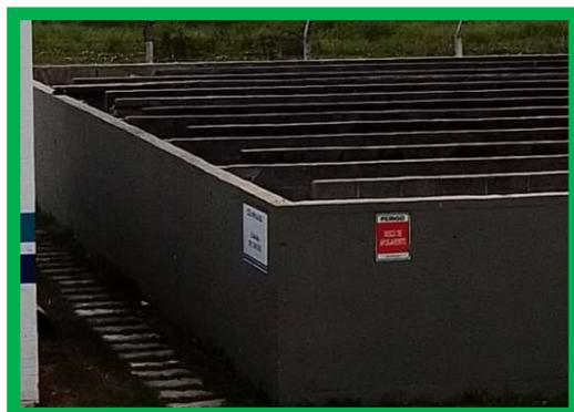
Chicanas = Paredes internas para aumentar o tempo de contato do cloro com o esgoto tratado
