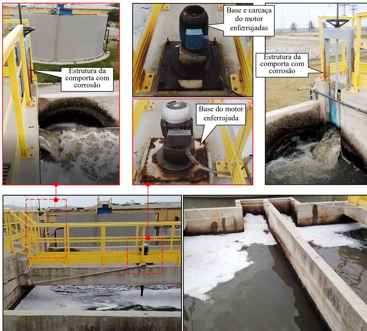
Figura 7 – Dois tanques de floculação (Floculadores) com um agitador mecânico cada. Destaque para as estruturas e peças com corrosão (**enferrujadas**)
