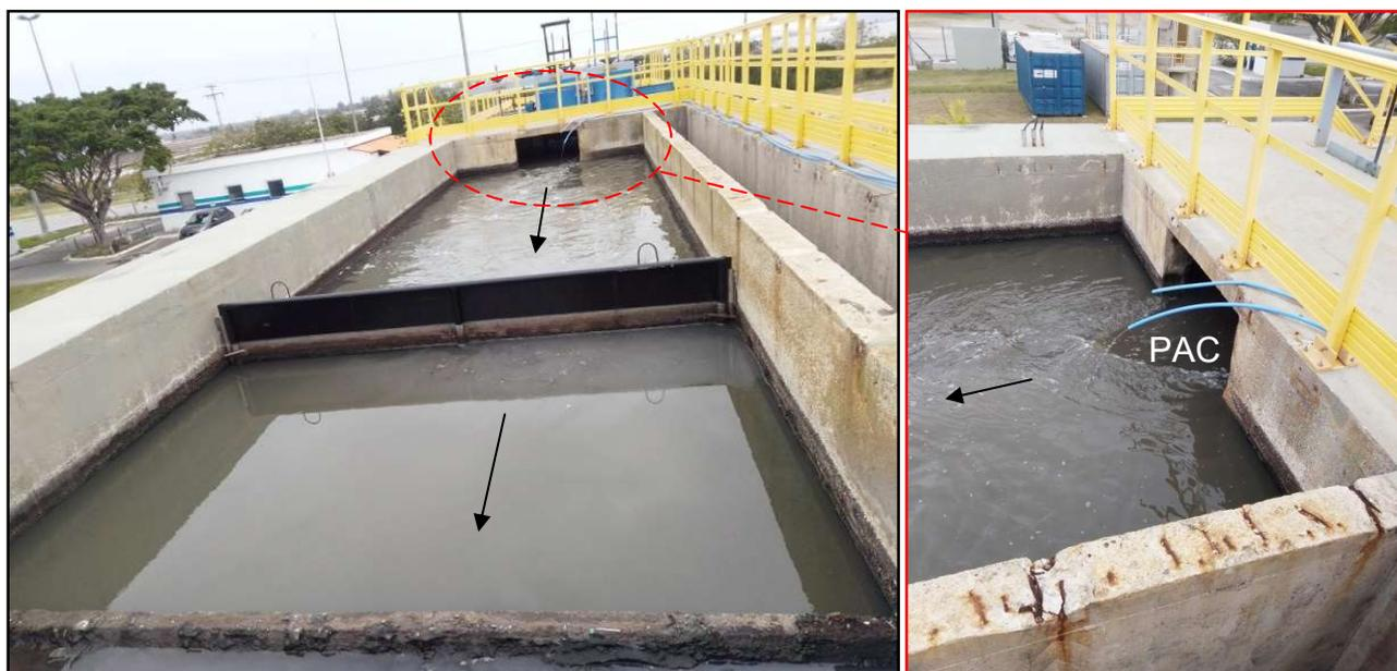
Figura 5 – Desarenador (Caixa de Areia) com aplicação de coagulante (PAC) no início
