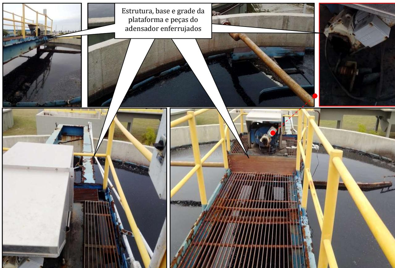
Figura 9 – Tanque adensador de lodo (vistas superiores). Destaque para **corrosão estrutural**
