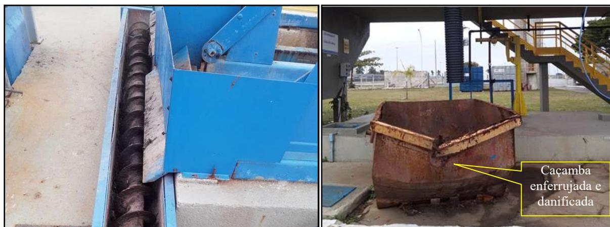
Figura 4 – Rosca transportadora dos resíduos das grades para a caçamba de armazenamento
