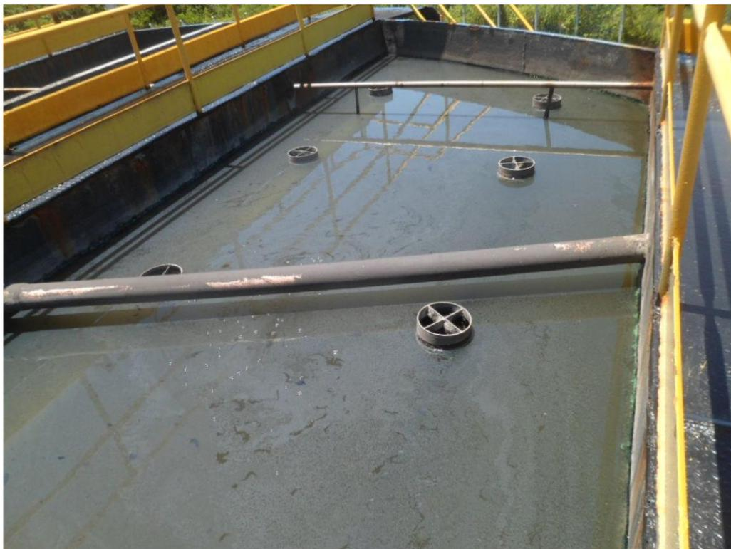
Foto 10 – Tanque Reatores UASB
