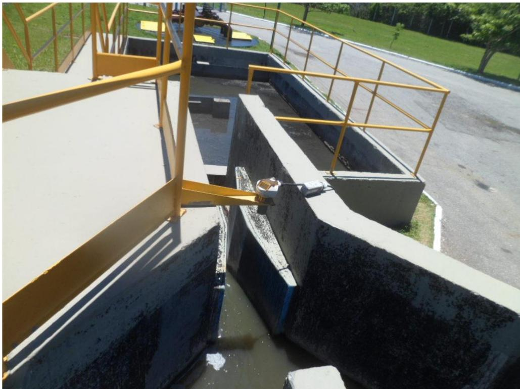
Foto 05 – Calha Parshall com Medidor de Vazão Ultrassônico
