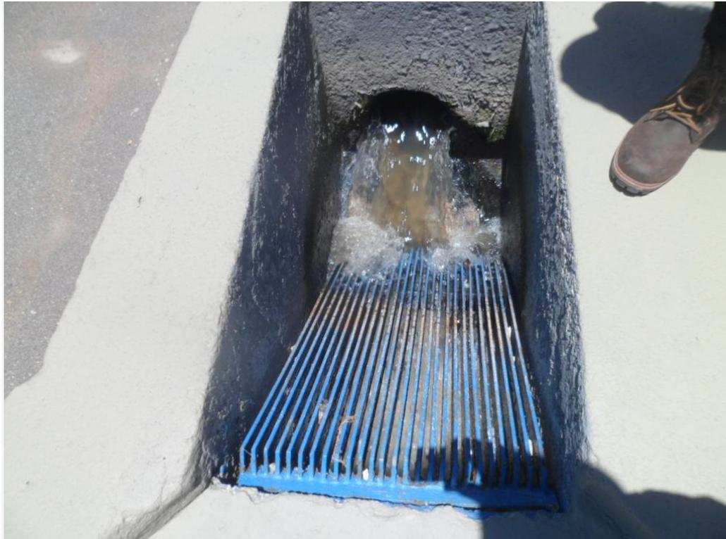
Foto 03 – Entrada do Esgoto Bruto e Gradeamento Grosso
