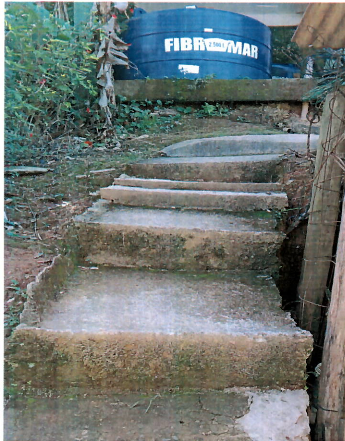
Local de entrada para o reservatório.
