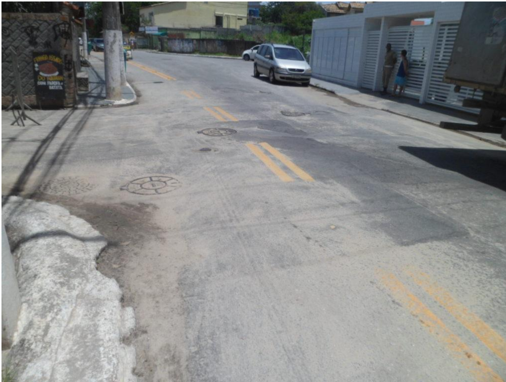
Foto 16 – Elevatória Avenida Oceânica
