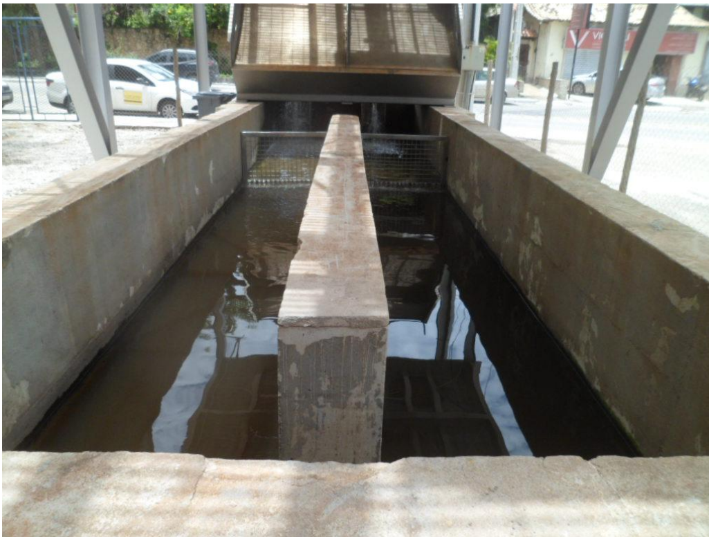
Foto 05 – Caixas de Areia
