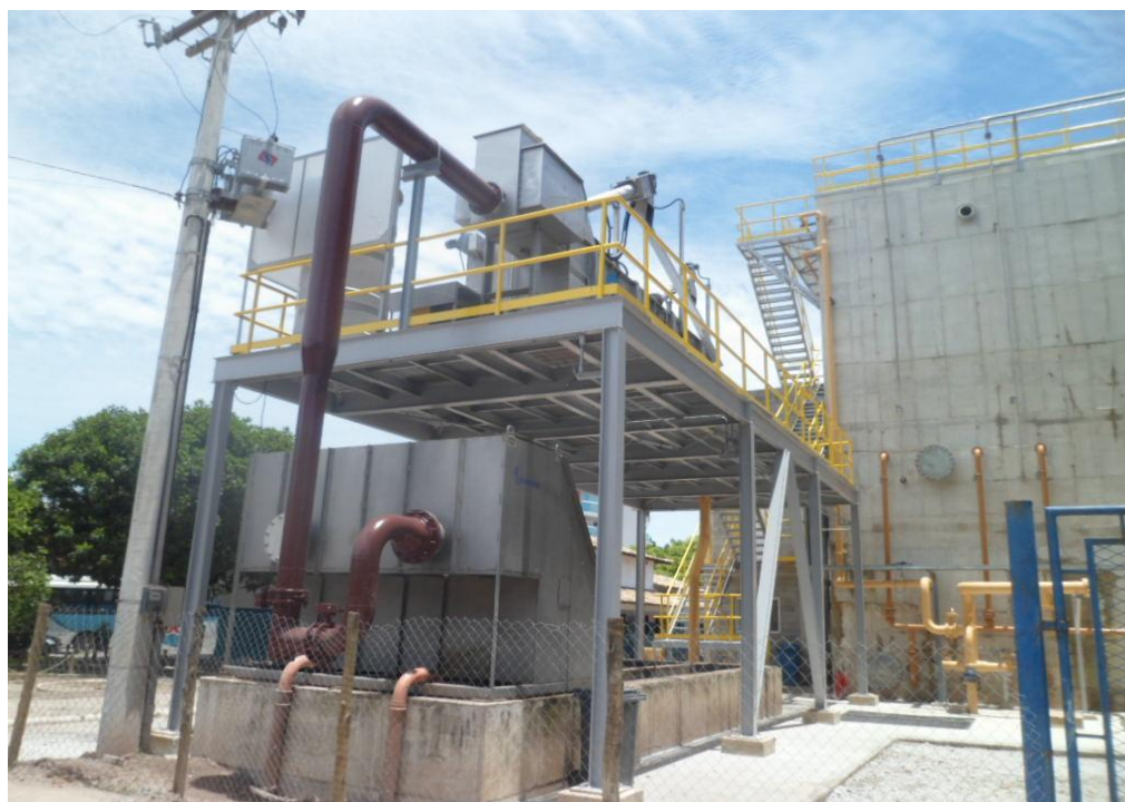
Foto 01 – Entrada da Estação de Tratamento de Esgoto (ETE) Itauna
