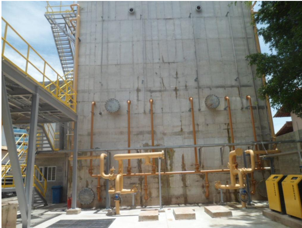
Foto 02 – Entrada da Estação de Tratamento de Esgoto (ETE) Itauna
