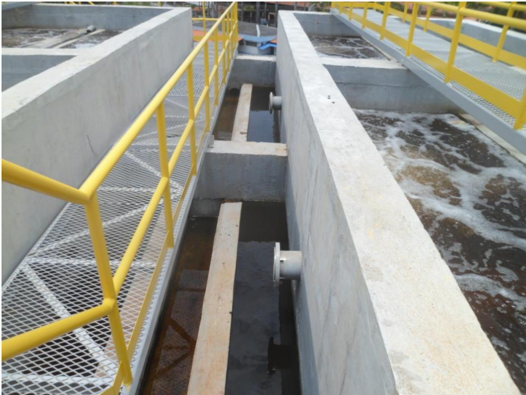
Foto 10 – Tanque de Decantação
