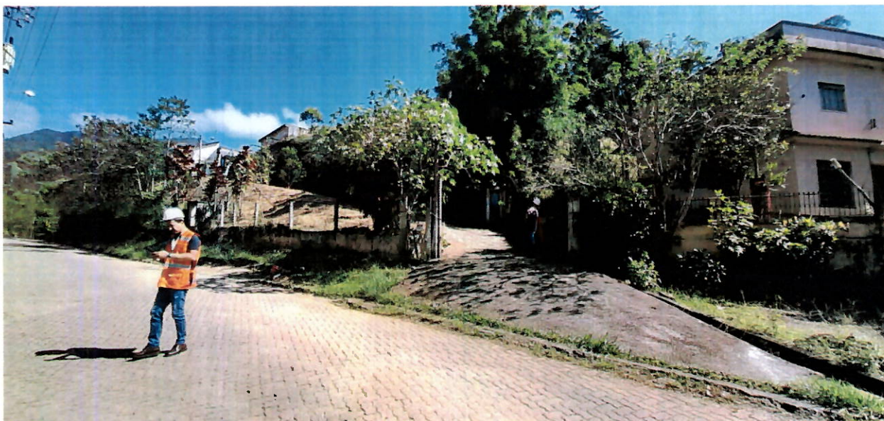
Estrada de acesso ao Reservatório UT, pavimentada com bloquetes de concreto;
