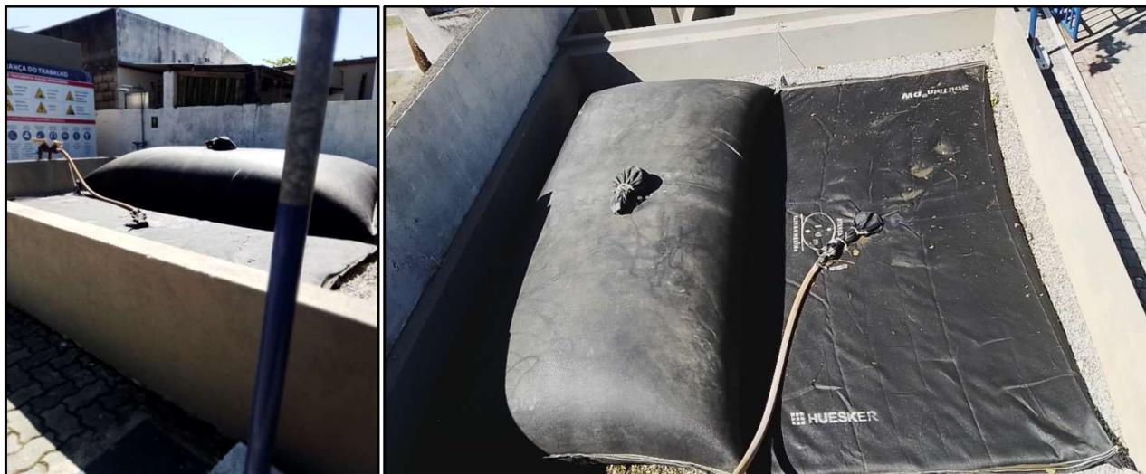
Figura 12 – Tratamento do lodo: tubos geotéxtis (um cheio e outro enchendo), para realizar desidratação (secagem), auxiliada pela aplicação de polímeros oriundos do tanque de mistura
