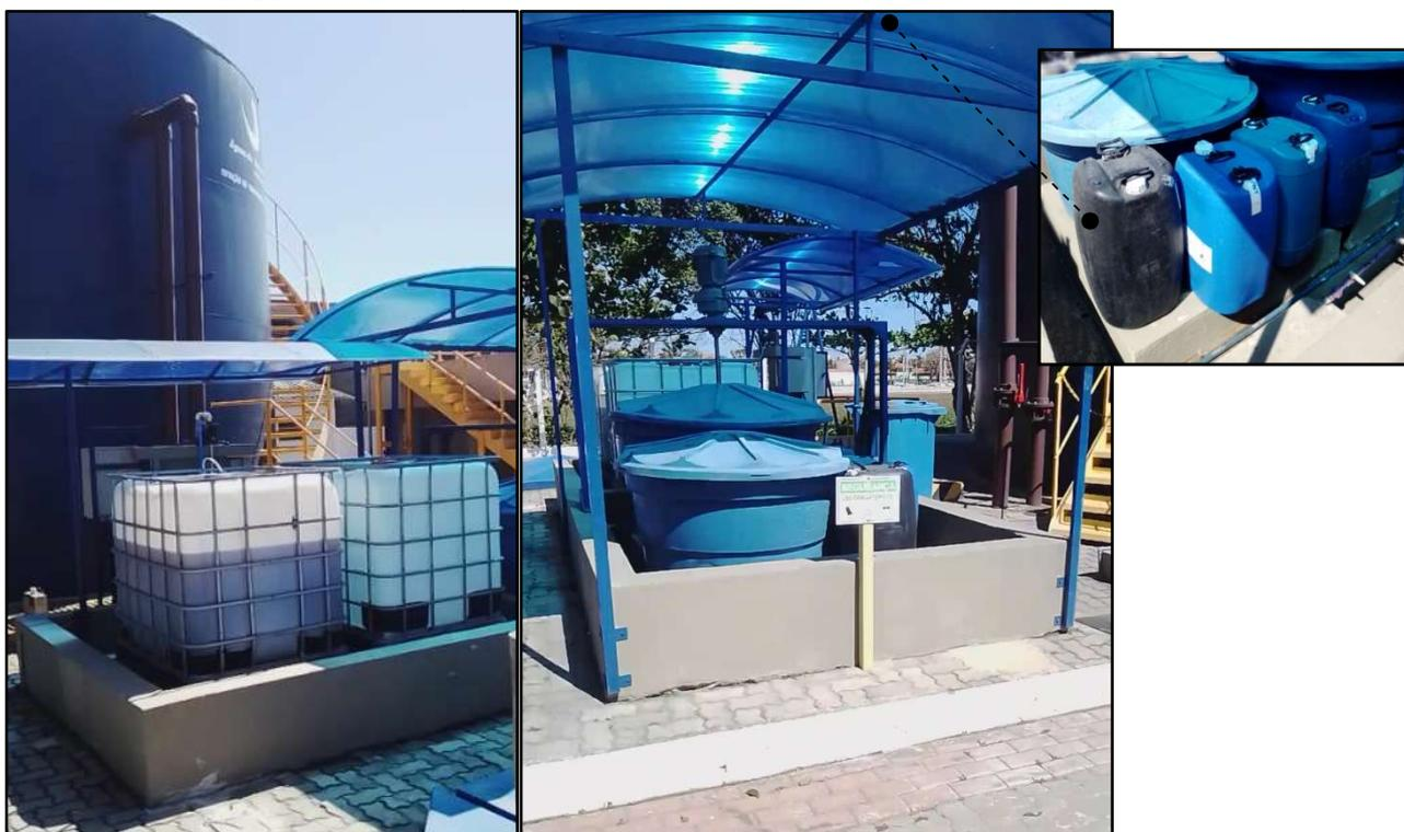
Figura 13 – Dosagem de produtos químicos: tanques de mistura de PAC para remoção de fósforo no decantador terciário e tanques de mistura de polímeros para desidratação do lodo, dentro de baias de contenção em concreto e sob coberturas em policarbonato
