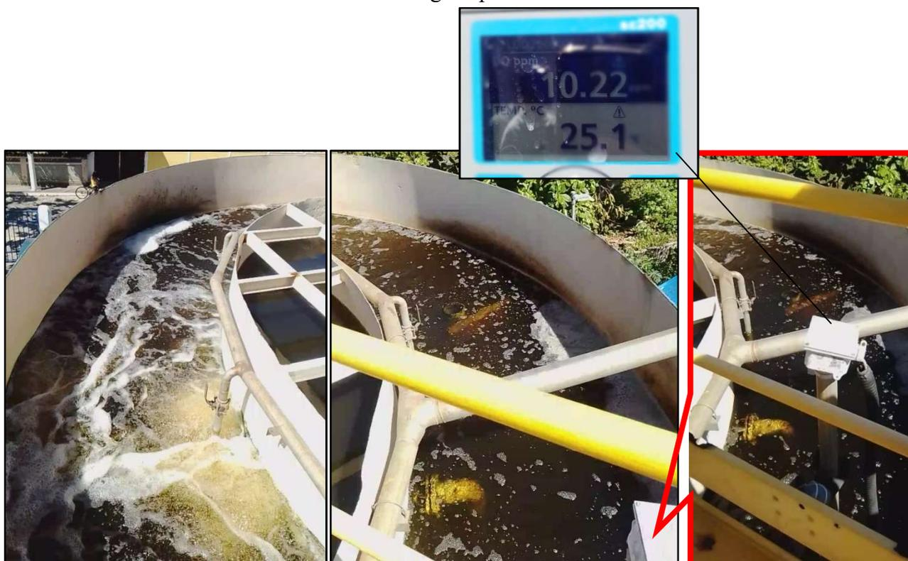
Figura 10 - Tratamento secundário no Tanque RANOX: reator aeróbio (vistas superiores), com mídias (“biobobs”) confinadas em telas (tipo MBBR). Aplicação de oxigênio dissolvido (DO) de 10,22ppm a 25,1°C. Destaque para plataforma com guarda-corpo com **corrosão** em alguns pontos
