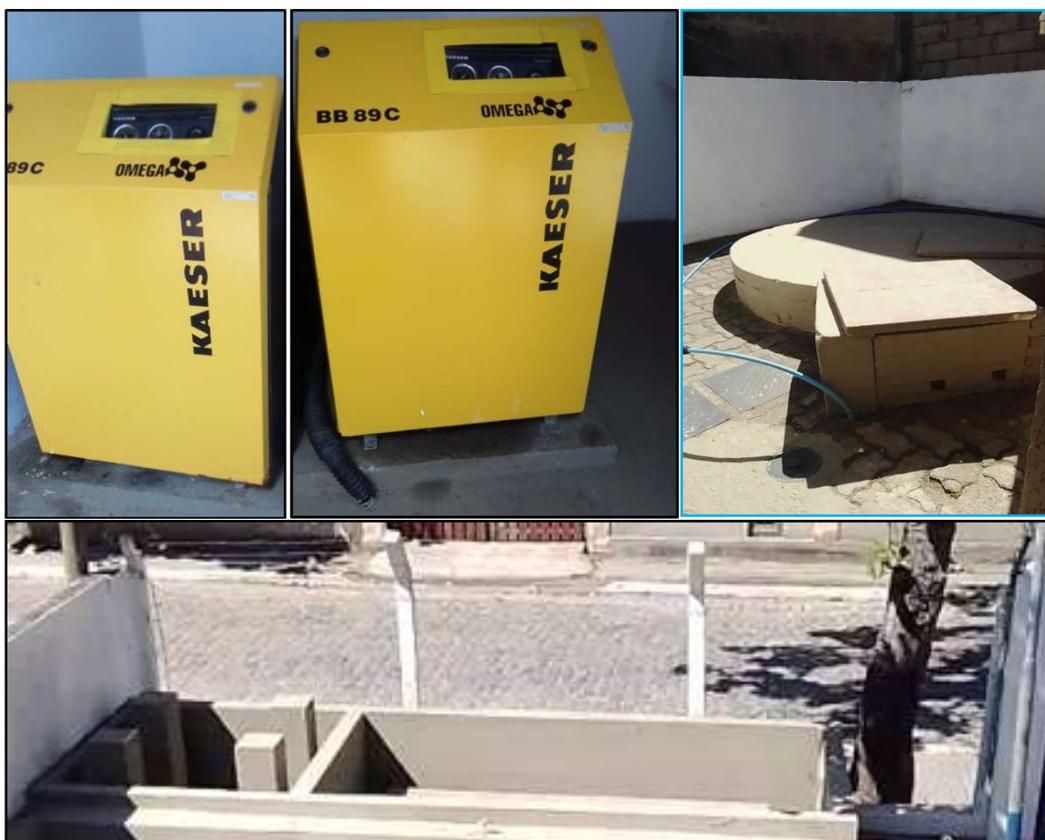
Figura 17 – Instalações de apoio: sopradores enclausurados com abafador de ruído para aeração do RANOX (imagem superior); cisterna de água para uso na ETE; e previsão para gerador com base em concreto e baía de contenção para combustível diesel (imagem inferior)
