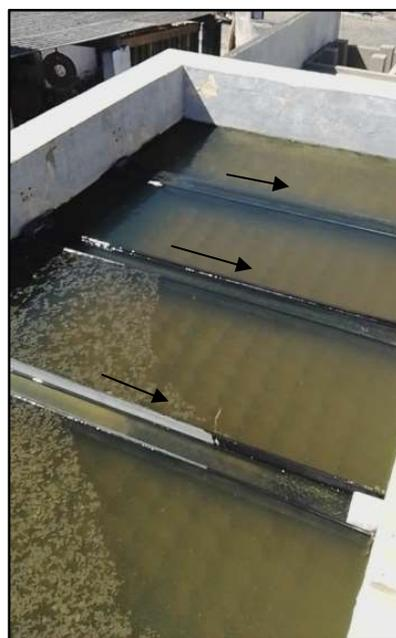
Figura 14 – Tratamento secundário e terciário: decantador terciário tipo lamelar com fluxo ascendente e com aplicação do PAC para remoção de fósforo (nutriente)
