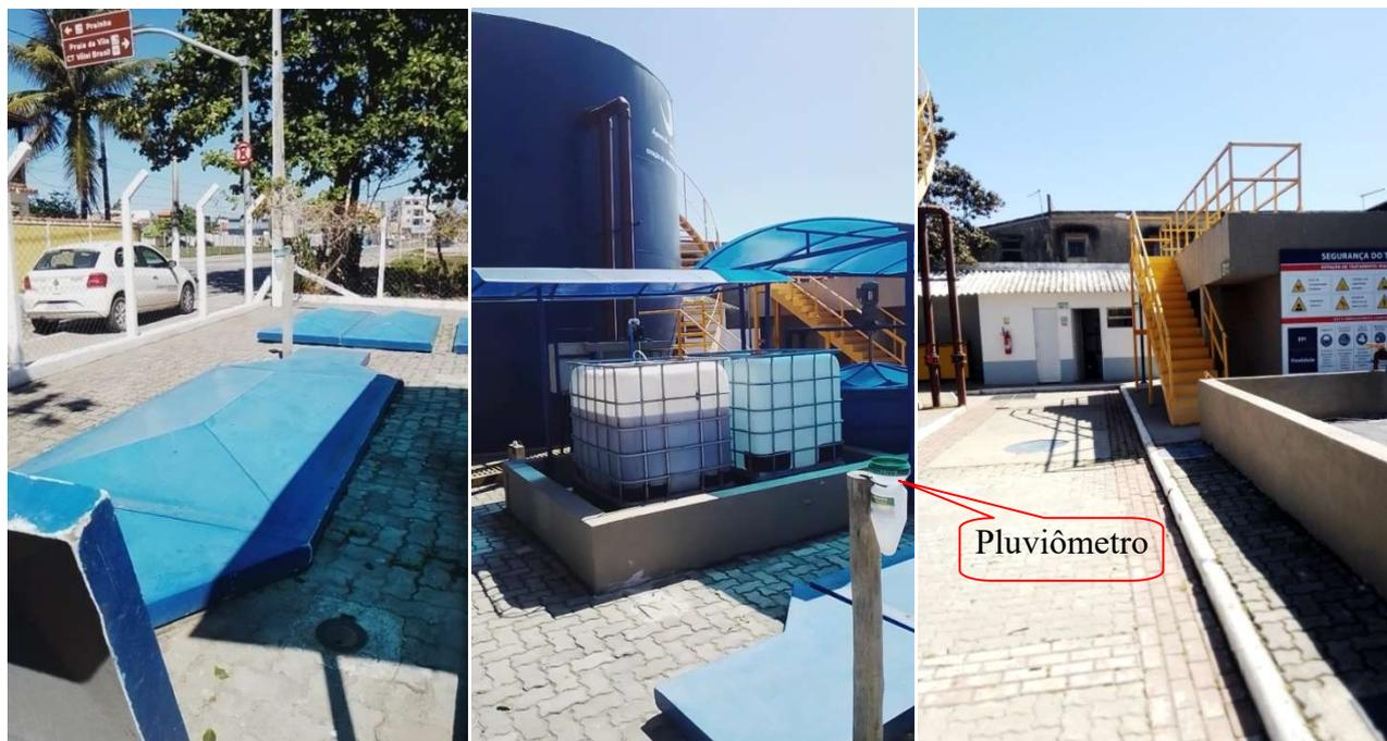
Figura 2 – Vistas gerais do sistema de tratamento dentro da ETE Saquarema: chegada do esgoto bruto e tratamento preliminar (com tampas em PRFV); tratamento secundário no tanque RANOX (reator anóxico na parte inferior e reator aeróbico na parte superior); e decantador terciário. Destaque para o pluviômetro de medição de chuva, já que o sistema é em tempo seco
