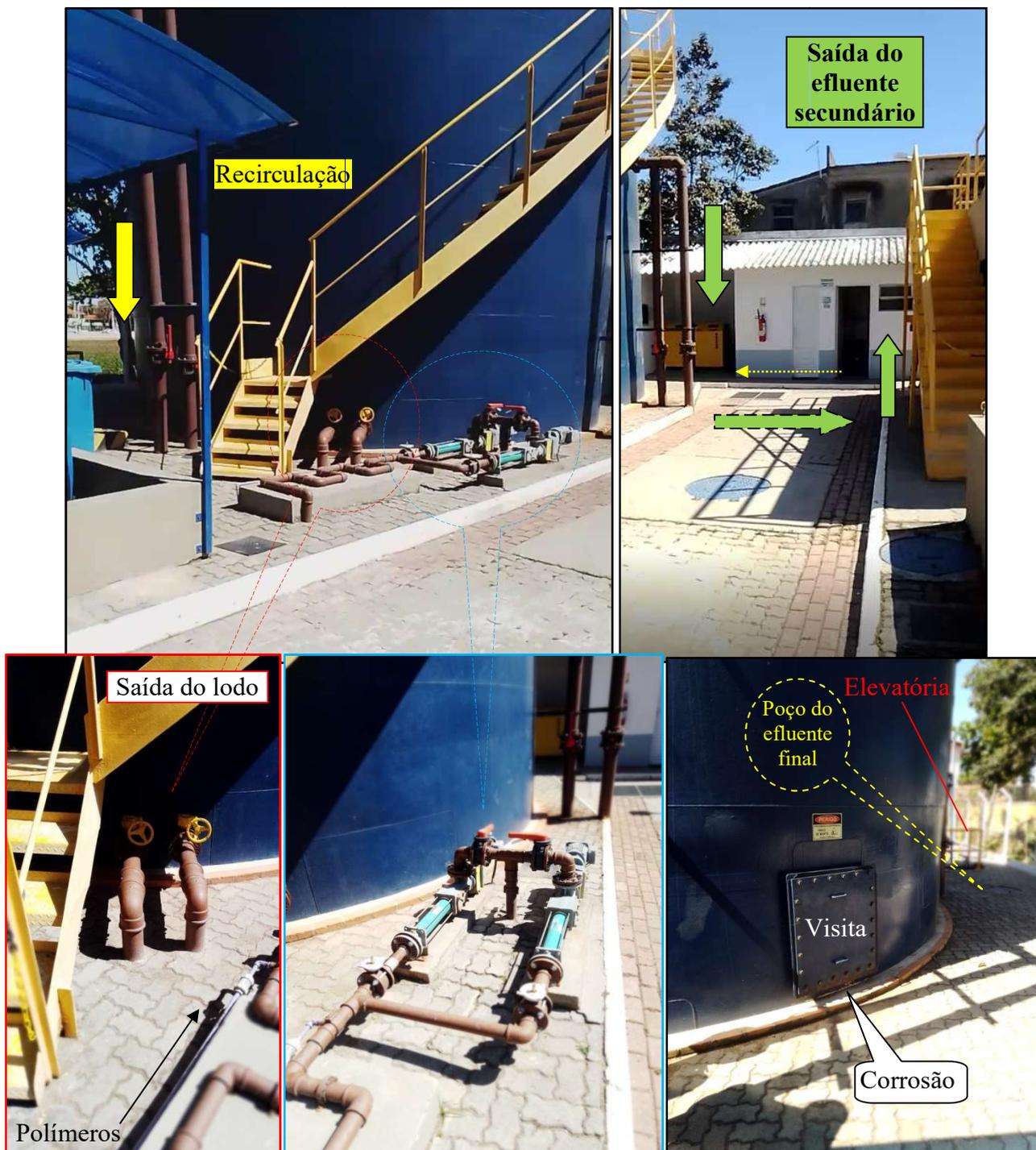
Figura 11 – Tratamento secundário no tanque RANOX: tubulações de recirculação; tubulações de saída do efluente secundário para o decantador terciário; saída do lodo; e elevatória de lodo com aplicação de polímeros para desidratação. Escada de acesso e visita para manutenção do tanque RANOX (visita com processo de corrosão)
