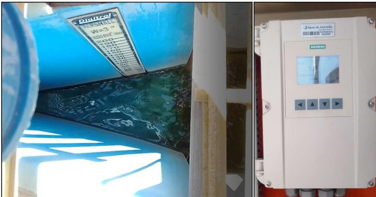
Figura 15 – Saída do efluente tratado: medidor de vazão tipo calha parshall com sensor ultrassônico (vazão instantânea = 5,27 L/s) e régua inox (vazão instantânea  $\approx 20\text{m}^3/\text{h} \approx 5,55\text{ L/s}$ , e vazão máxima histórica  $\approx 50\text{ m}^3/\text{h} \approx 14\text{ L/s}$ )
