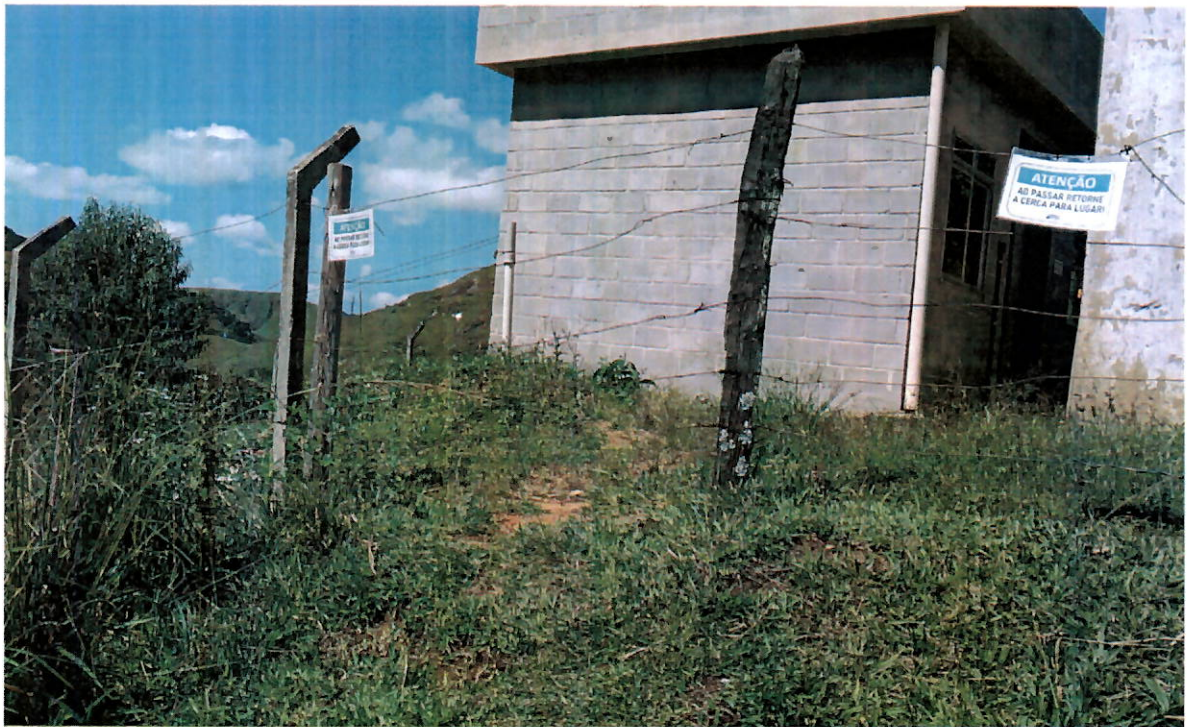
Local de entrada para o reservatório
