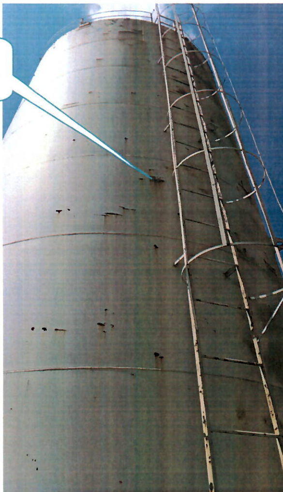
Escada de acesso
