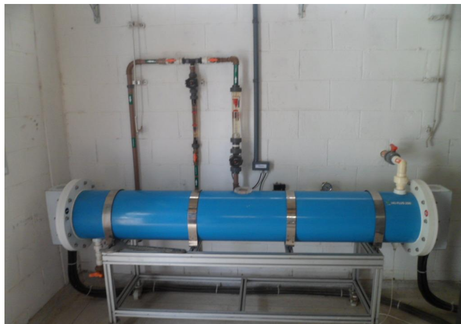
Foto 07 – Eletrodos para Produção de Hipoclorito
