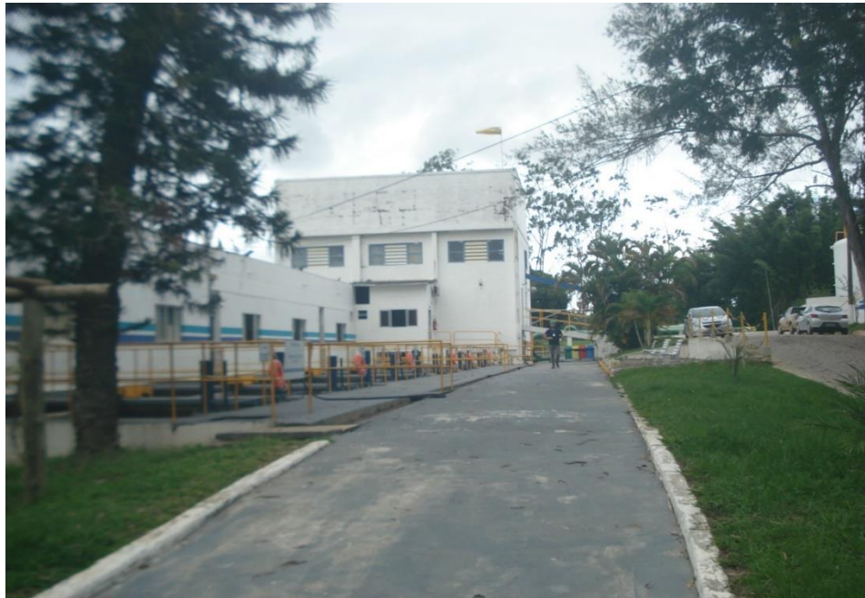
Foto 02 – Alameda Principal da ETA
