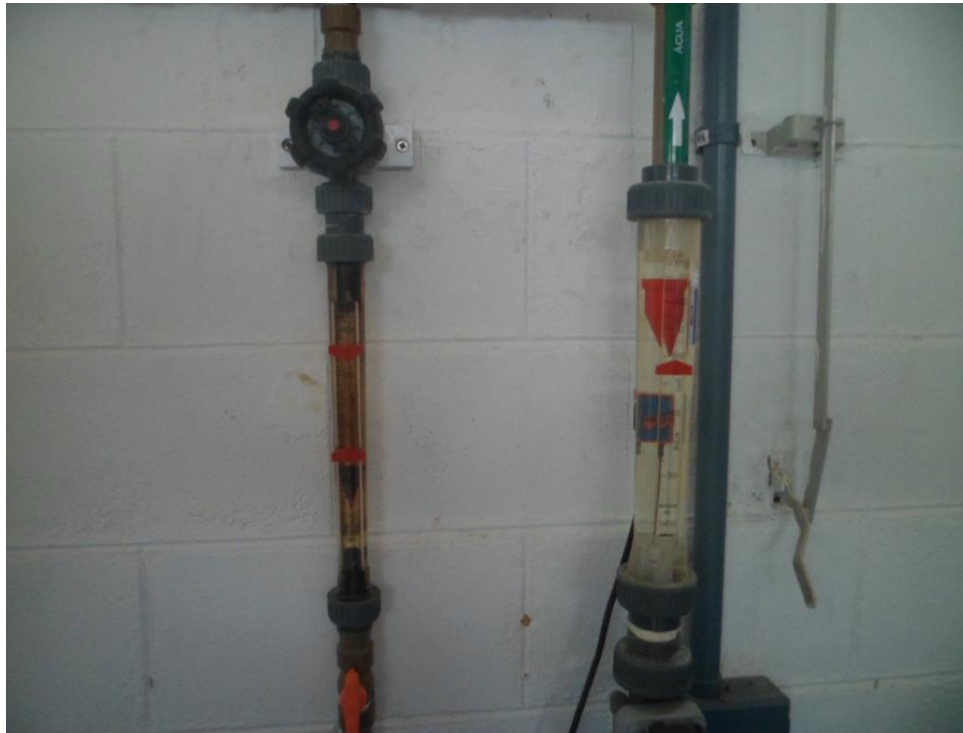
Foto 08 – Hidrojetor, Rotâmetro Fluxômetro Medidor de Vazão
