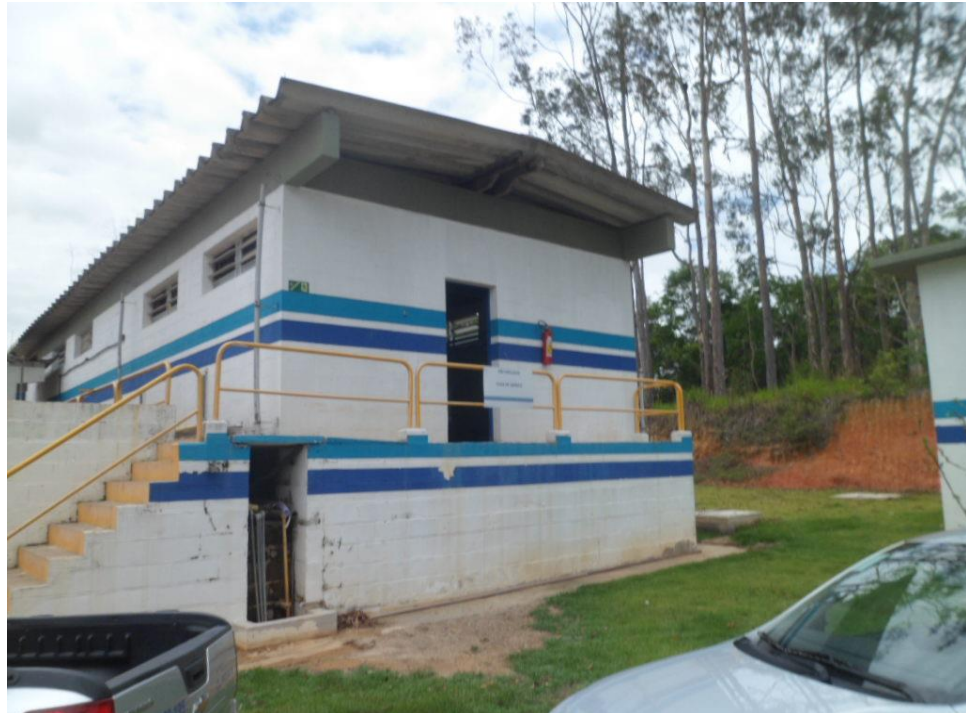
Foto 04 – Casa de Química
