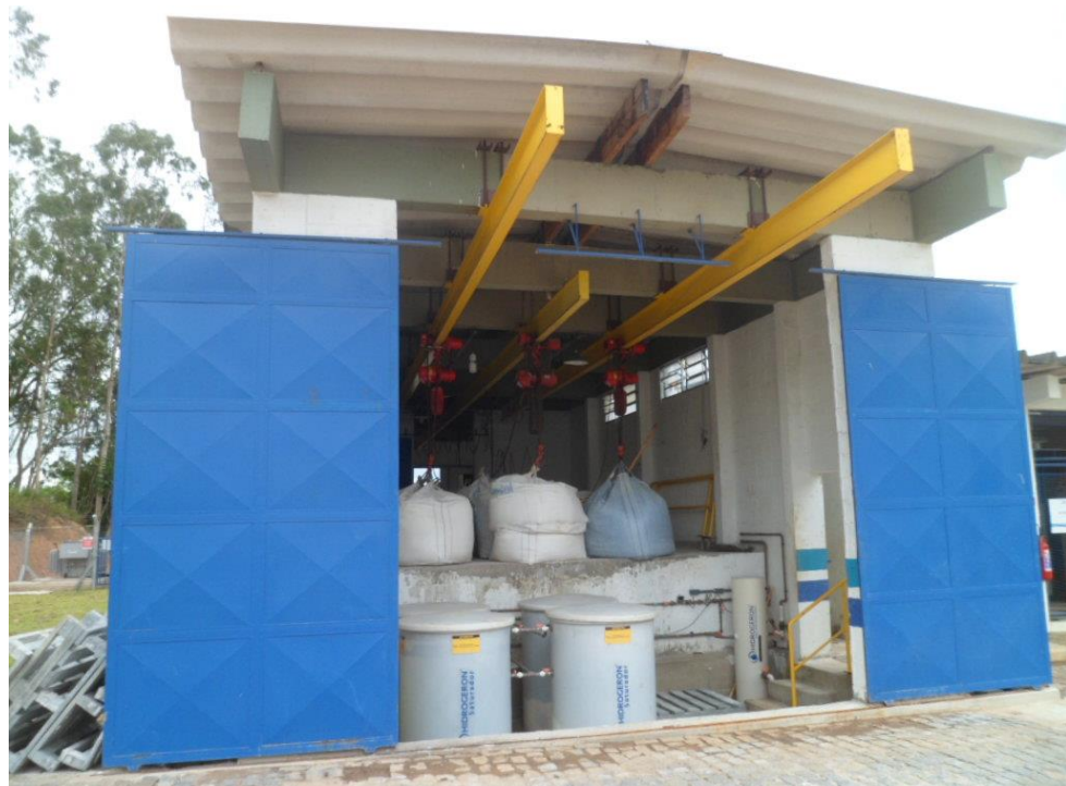
Foto 05 – Complemento de Construção do Galpão
