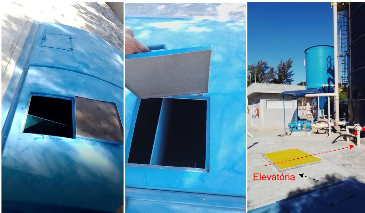
Figura 6 – Tanques com escotilha (**uma solta com dobradiça quebrada**) da caixa de gordura e poço da elevatória de esgoto pré-tratado
