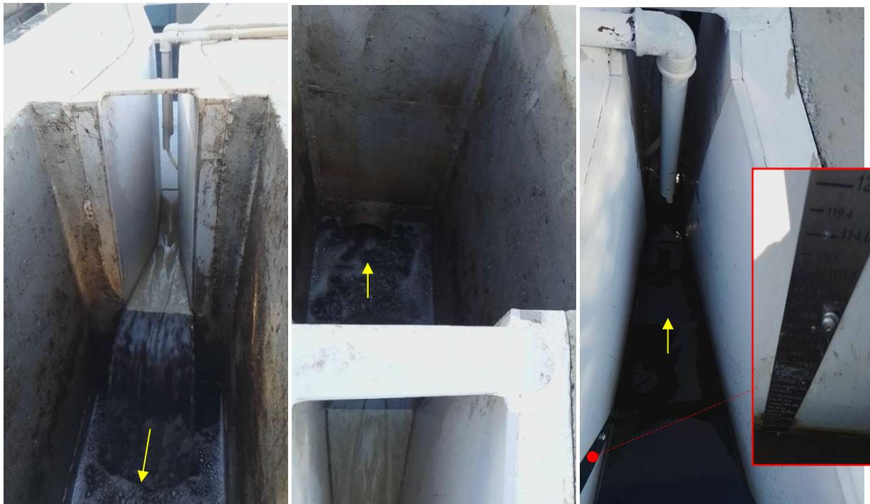
Figura 5 – Medidor de vazão da entrada tipo calha Parshall com régua em aço inox, **mas sem sensor ultrassônico**. Ponto de aplicação de antiespumante na garganta da calha
