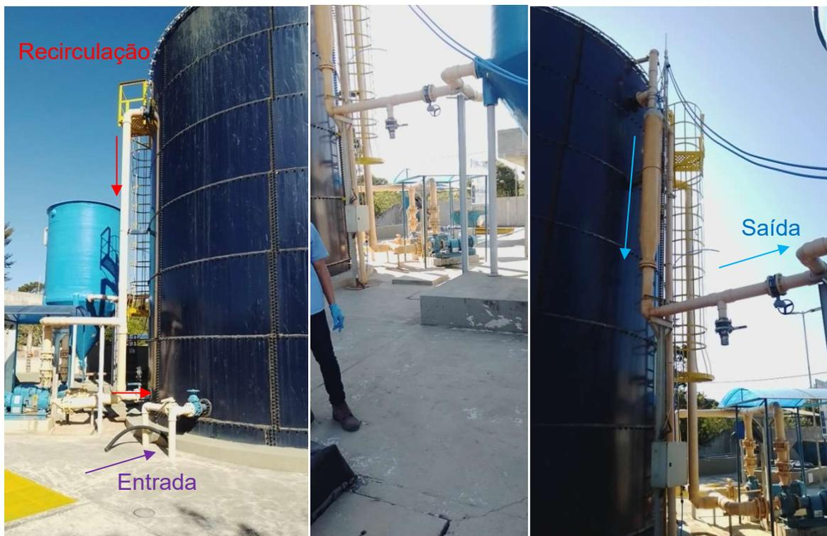
Figura 10 - Entrada no tanque RANOX, recirculação e a saída para o decantador
