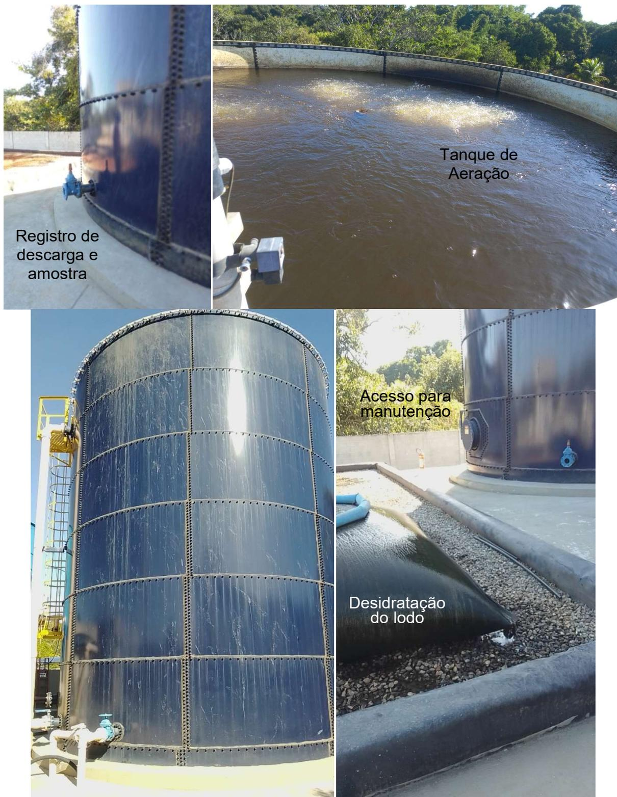
Figura 8 - Tratamento secundário: reator compacto anóxico (parte inferior) e aeróbico (parte superior) – RANOX (vistas laterais e superior, com detalhe para a visita)
