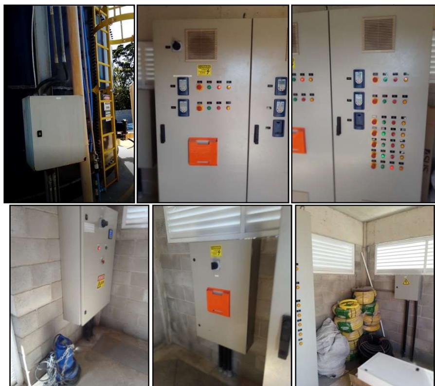
Figura 15 – Painéis de comando elétrico dos motores da ETE Jacarepiá
