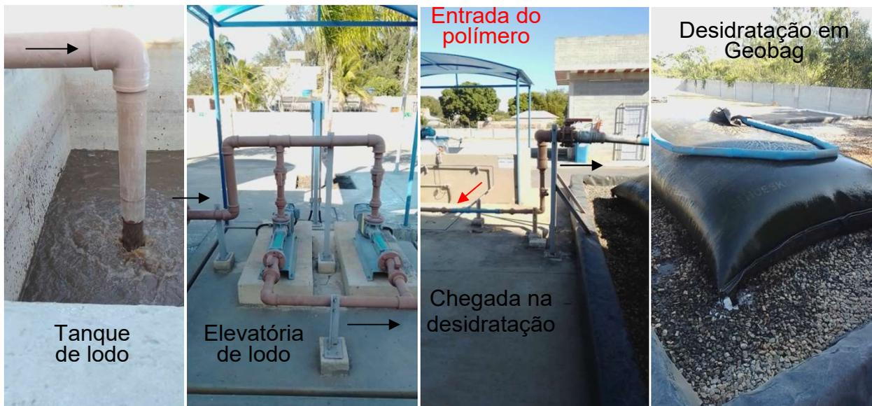
Figura 12 – Tratamento do lodo: do tanque de lodo (adensador) para a elevatória de lodo adensado, que o recalca para o tubo geotéxtil (geobag) para realizar sua desidratação (secagem), auxiliada pela aplicação de polímeros oriundos do tanque de mistura
