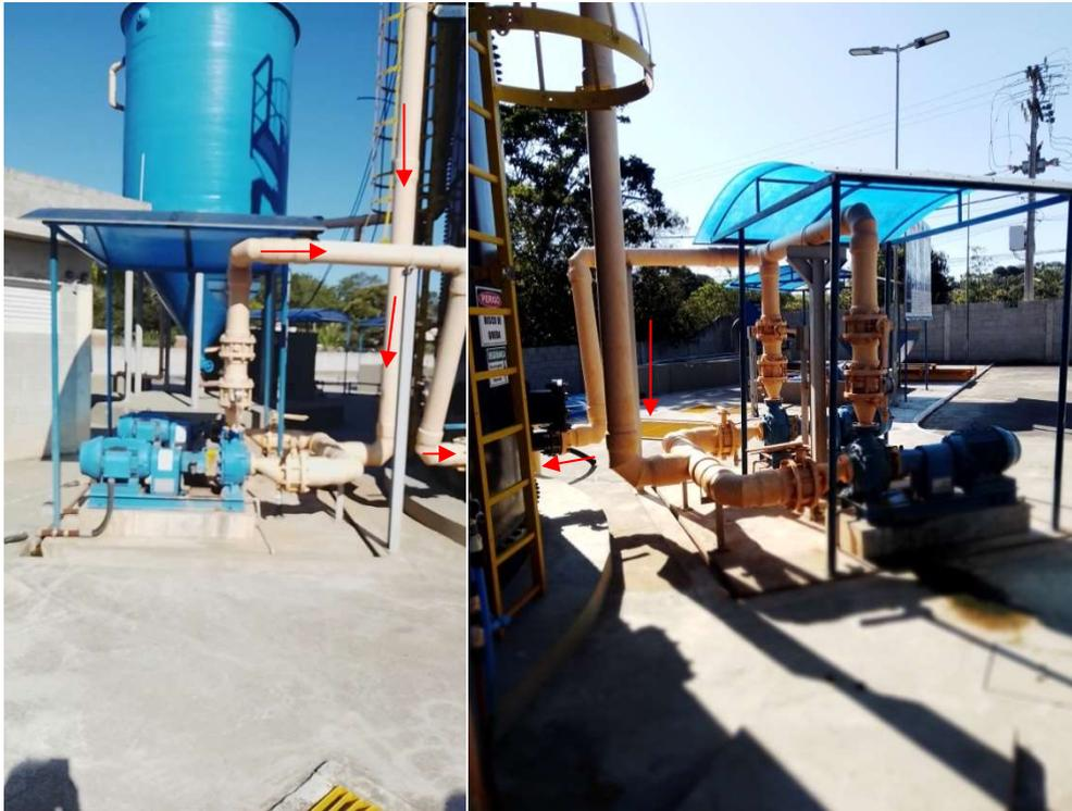
Figura 9 – Elevatória de recirculação de esgotos para o reator RANOX
