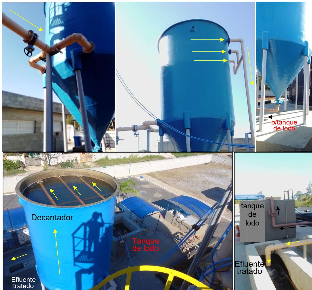
Figura 11 – Decantador secundário tipo lamelar (vistas laterais, inferiores e superior): entrada ascendente do efluente do RANOX no fundo; coleta em três tubos perfurados no topo e saída superior do efluente tratado para a caixa de efluente tratado; e descarte do lodo do cone de fundo para o tanque de lodo (adsensador de lodo)
