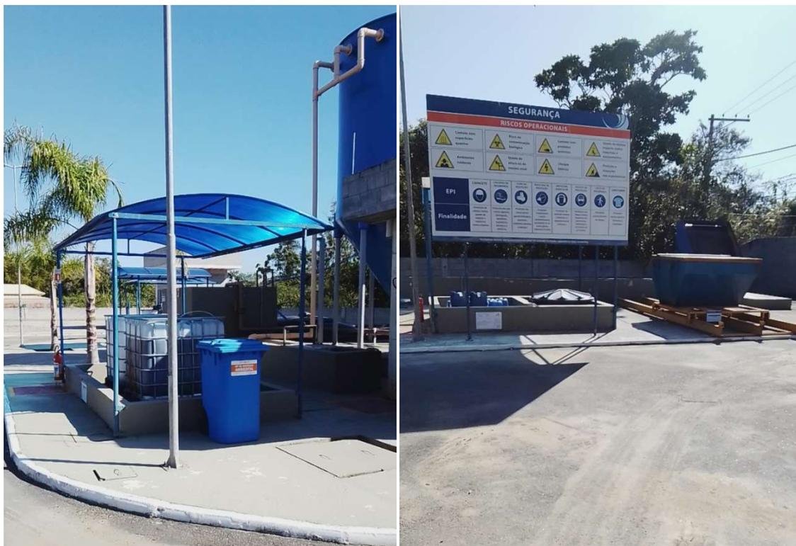
Figura 14 – Tanques de produtos químicos utilizados no tratamento: Policloreto de Alumínio – PAC (imagem da esquerda) e antiespumante (imagem da direita)
