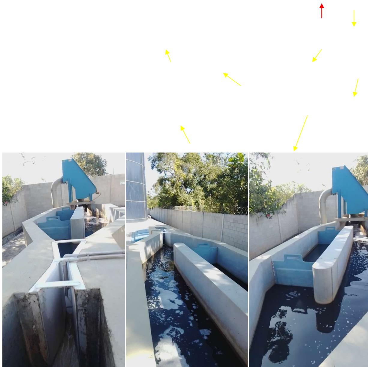
Figura 4 – Tratamento preliminar: desarenadores de limpeza manual (vistas de montante e jusante)
