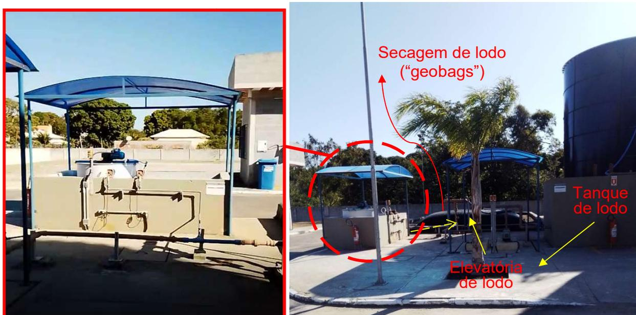
Figura 13 - Tratamento do lodo: tanque de mistura e dosagem de polímeros para secagem do lodo
