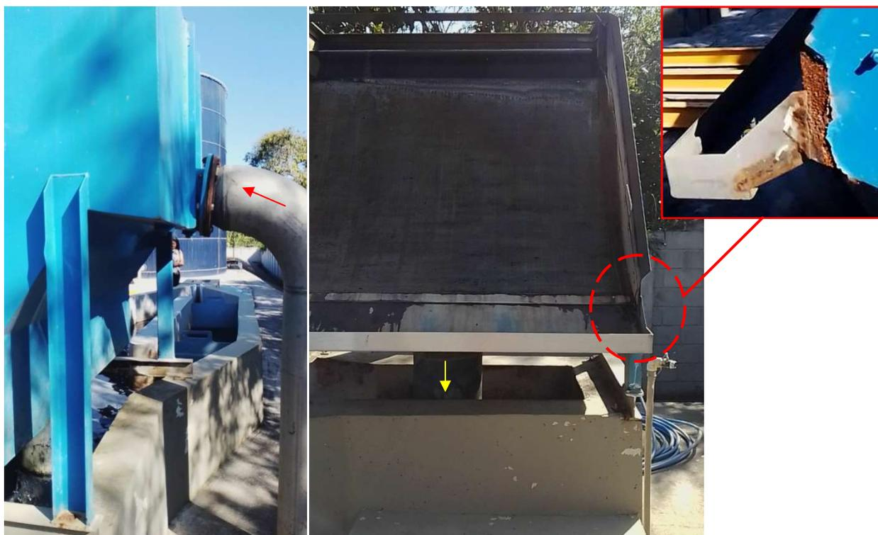
Figura 3 – Entrada do recalque de esgoto bruto no tratamento preliminar da ETE: gradeamento tipo peneira estática escalar com abertura em malha fina, com saída no tanque à jusante dos desarenadores. Destaque para a **corrosão** da estrutura do gradeamento.
