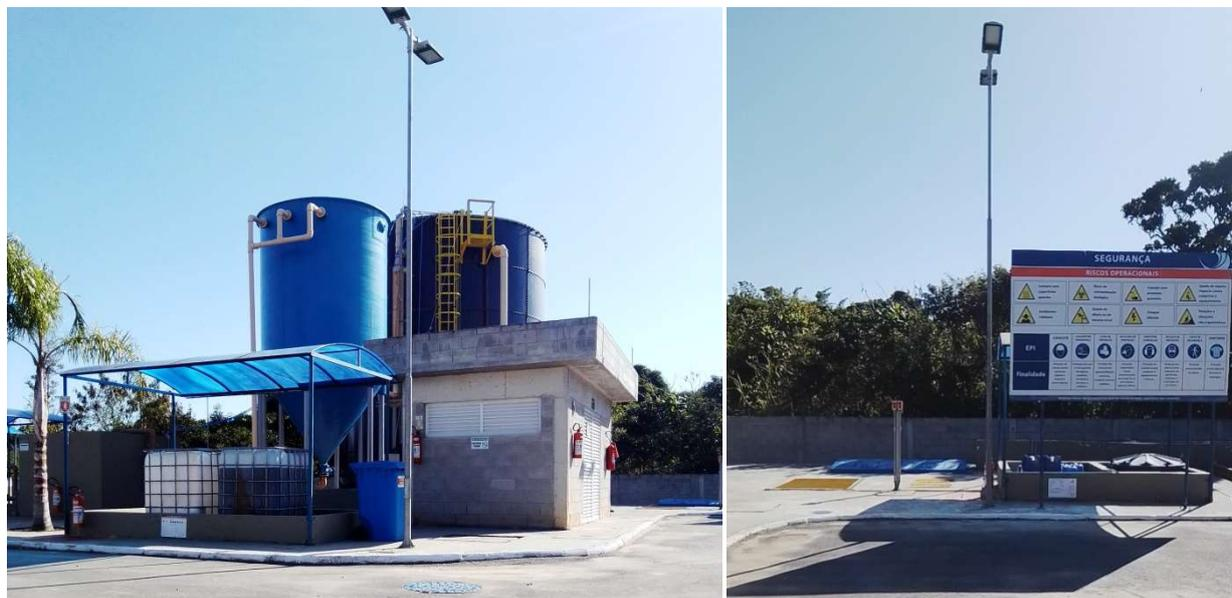
Figura 2 – Vistas gerais do sistema de tratamento dentro da ETE Jacarepiá (tratamento preliminar na imagem da direita e os tanques do tratamento primário, secundário e terciário na imagem da esquerda, incluindo a casa do soprador e o abrigo para os produtos químicos)
