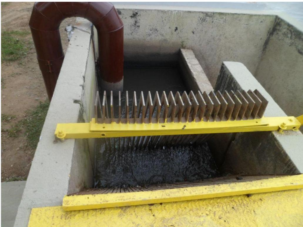
Foto 05 – Entrada do Esgoto Bruto e Gradeamento Grosso
