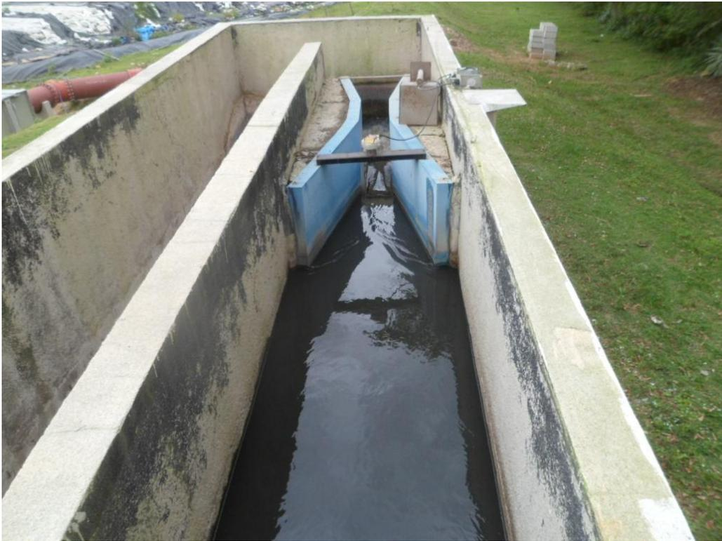
Foto 08– Calha Parshall com Medidor de Vazão Ultrassônico
