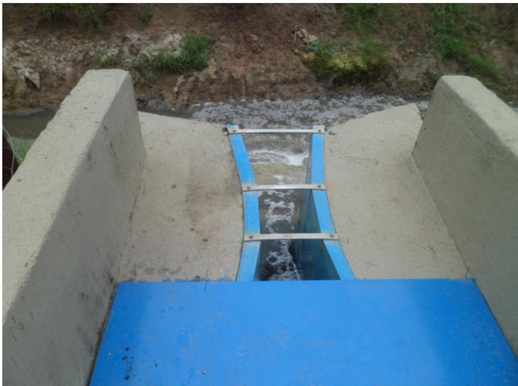
Foto 21 – Calha Parshall, Saída do Esgoto Tratado
