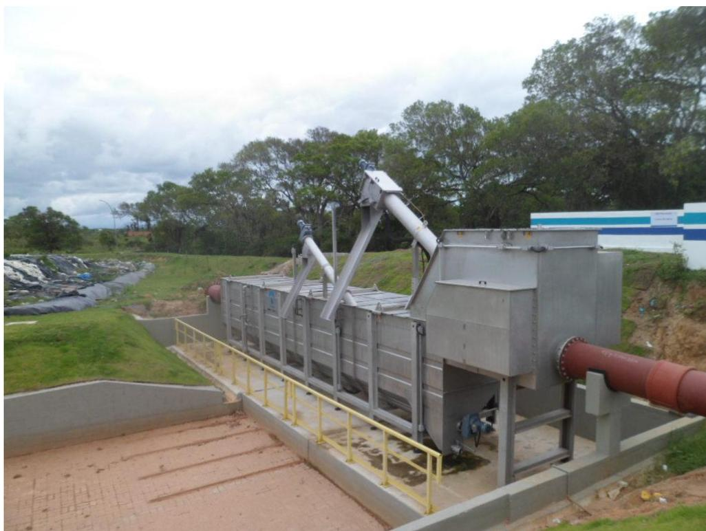
Foto 03 – Equipamento Preliminar Integrado
