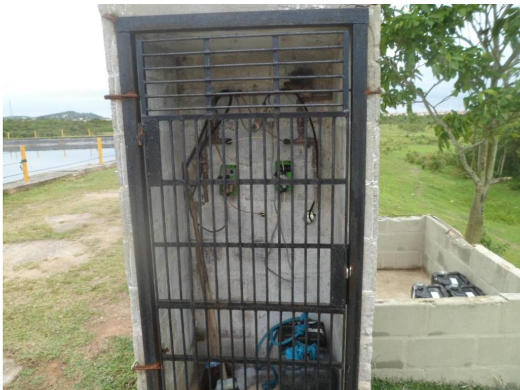
Foto 19 – Bomba Dosadora de Antiespumante
