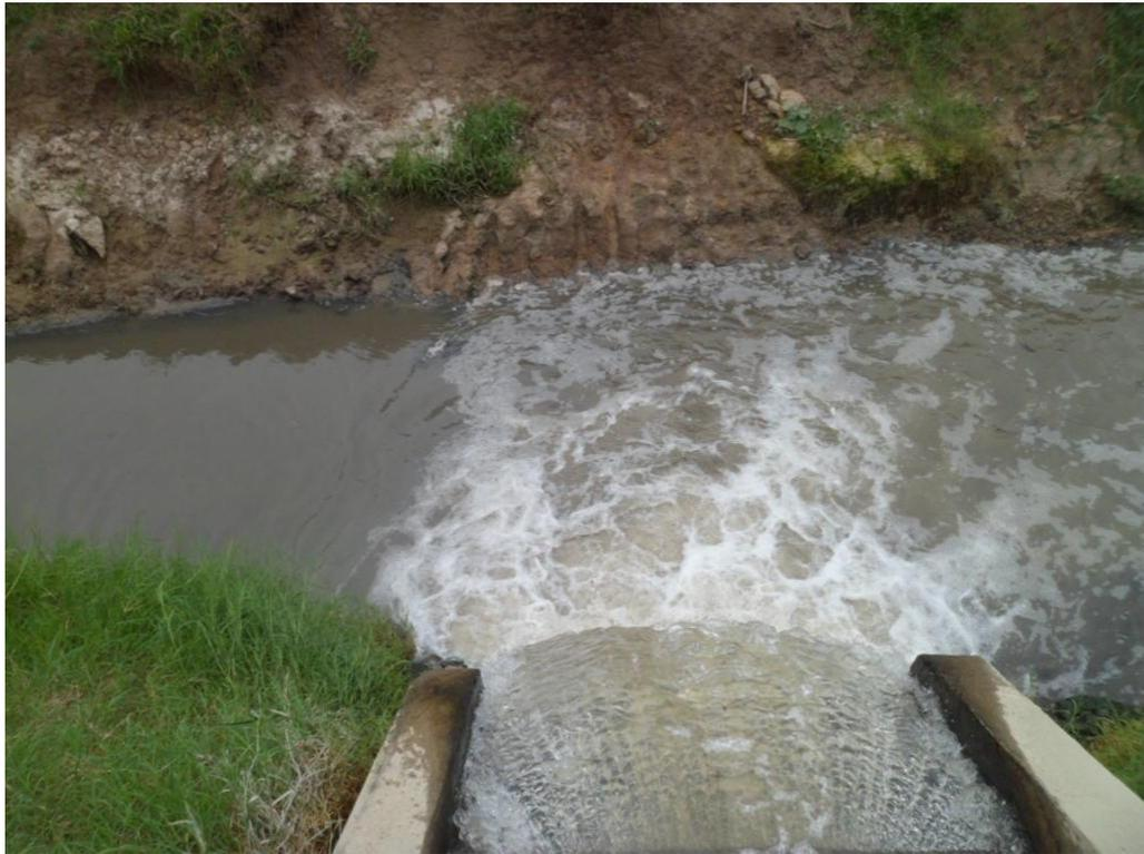
Foto 22 – Saída do Esgoto Tratado, Lançado no Canal da Malhada
