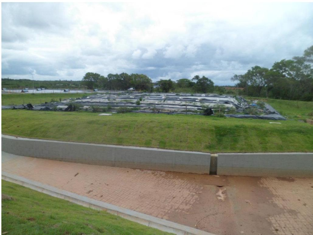
Foto 25 – Área Destinada para Desidratação e Secagem do Lodo
