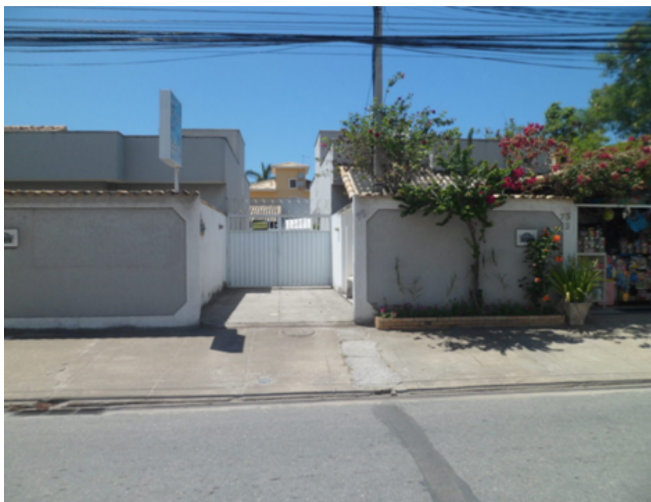
Foto 02 – Fachada da Casa – Rua Niterói, 75, casa 03 – Rio das Ostras
