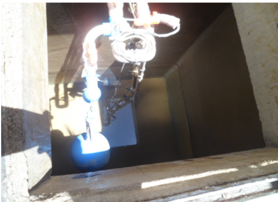
Foto 07 – Cisterna com aproximadamente 30 cm de água
