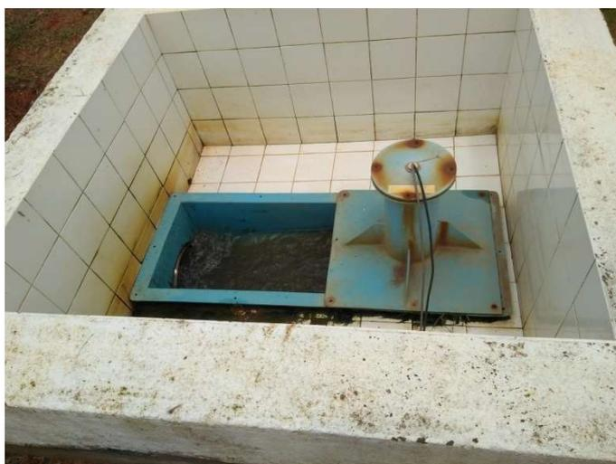
Foto 06 – Calha Parshall com Medidor de Vazão Ultrassônico
