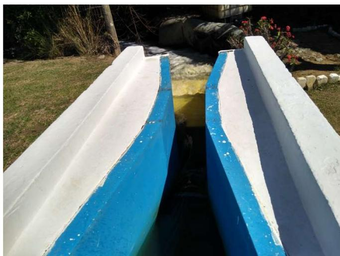
Foto 18 – Calha Parshall na Saída do Esgoto
