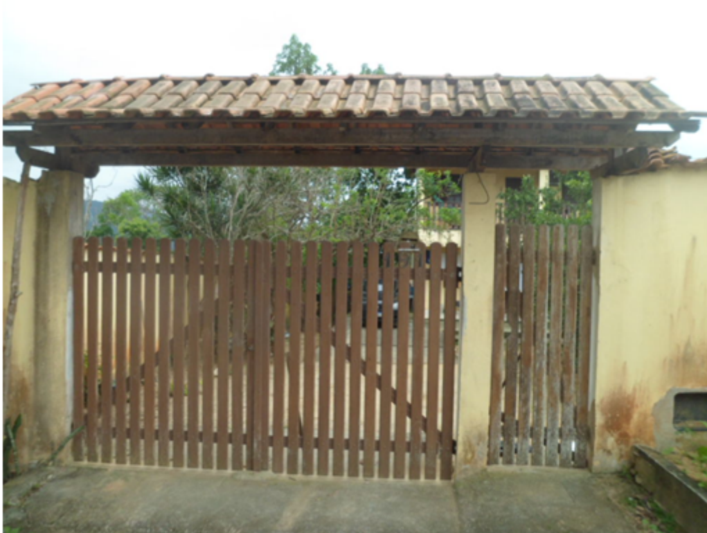
Foto 01 – Fachada da Residência, Rua A, Recanto do Luar 191 – Retiro - Bacaxá
