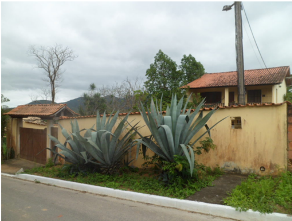
Foto 02 – Fachada da Residência, Rua A, Recanto do Luar 191 – Retiro - Bacaxá
