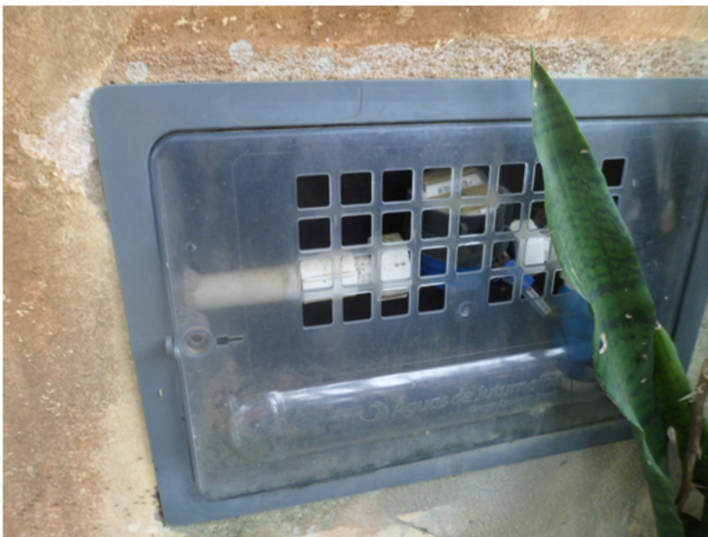
Foto 03 – Fachada do Prédio, Av. Braz de Pina, 2191 – Vista Alegre
