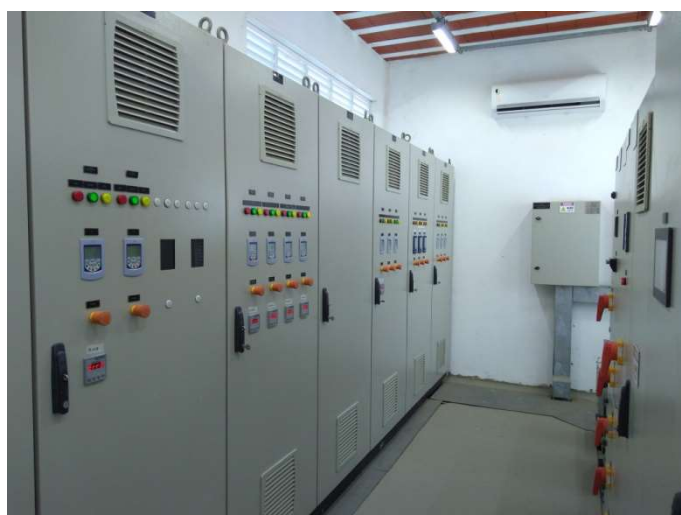
Foto 16 – Quadro de Comando de Toda Estação
