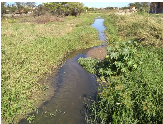
Foto 27 – Saída do Esgoto tratado e lançado no Rio Piripiri
