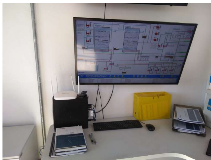
Foto 16 – Quadro de Comando de Toda Estação
