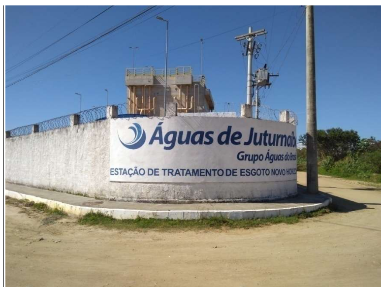
Estação de Tratamento de Esgoto (ETE) Novo Horizonte
