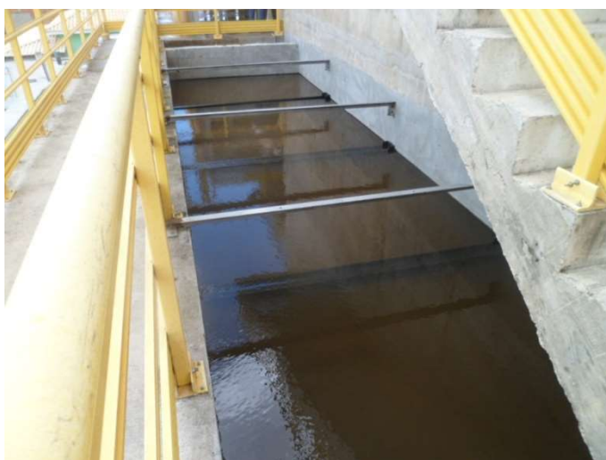
Foto 08 – Tanque de Decantação Primária
