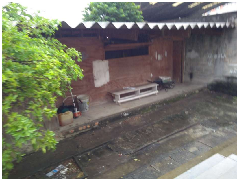
Fotografia 9 – Barraco de obra da empresa contratada para reforma dos painéis
