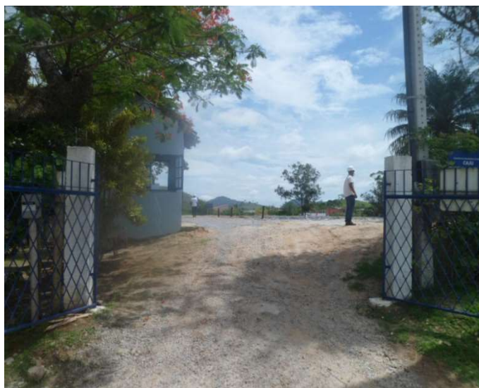
Foto 01 – Entrada da Estação de Tratamento de Esgoto
