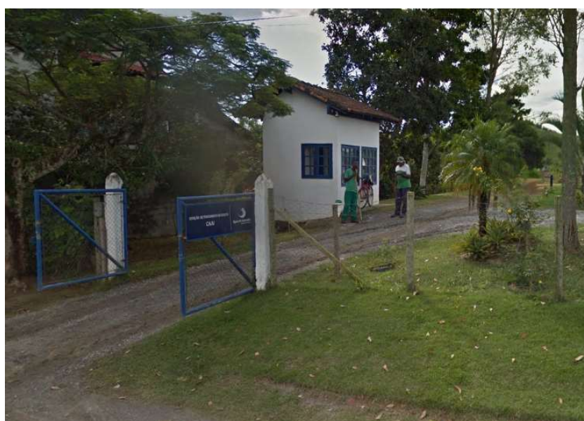
Entrada da Estação de Tratamento de Esgoto Caju
