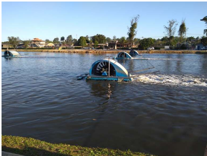
Foto 11 – Lagoa Aerada com 05 (cinco) Motores Cachoeira
