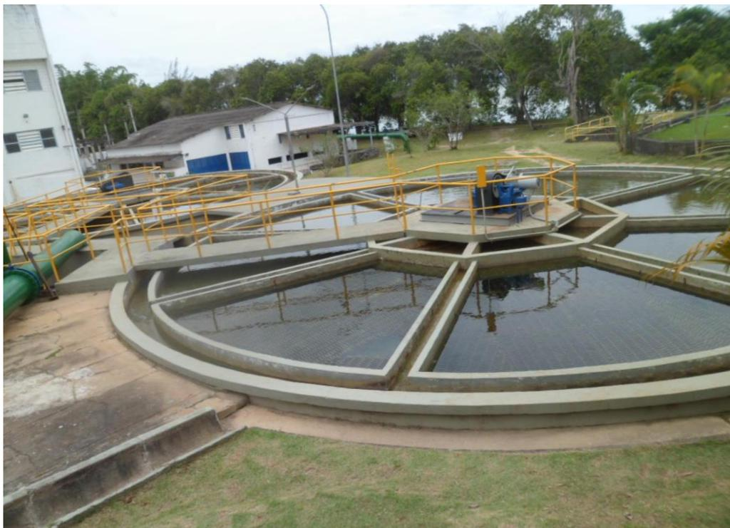
Foto 10 – Tanques de Decantação da ETA 1
