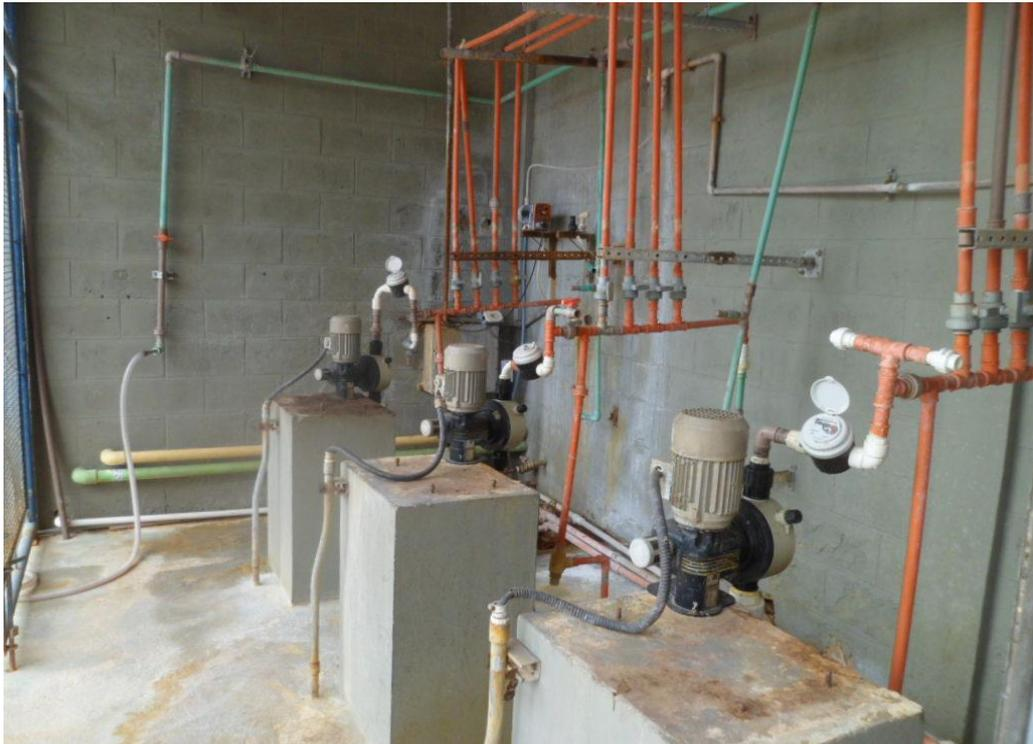
Foto 16 – Bombas Dosadoras Automatizadas de hipoclorito de sódio
