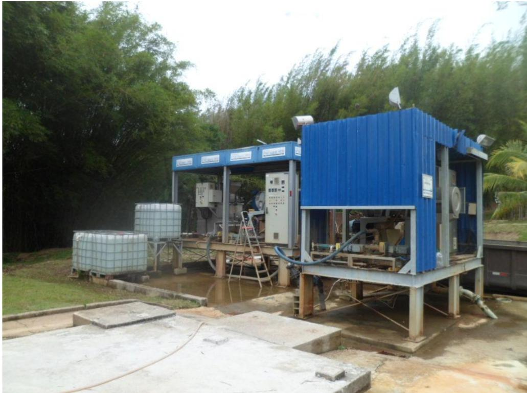
Foto 22 – Centrifugas para Desidratação do Lodo
