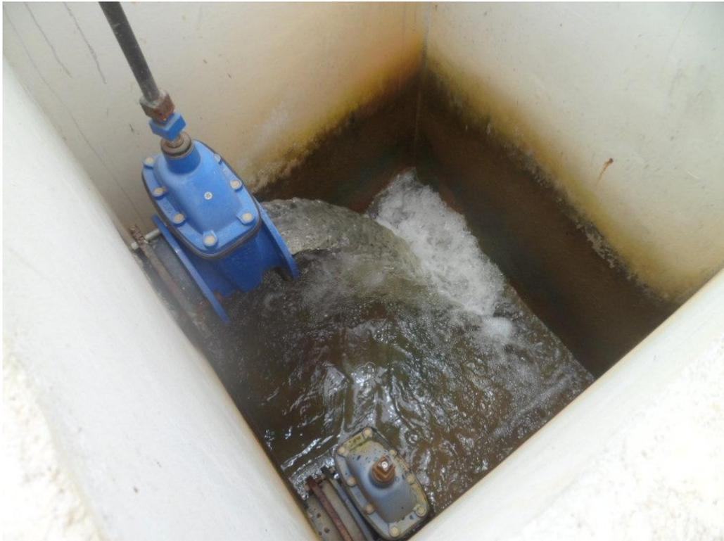
Foto 26 – Água da Lagoa de Lavagem dos Filtros para o Início do Processo de Tratamento
