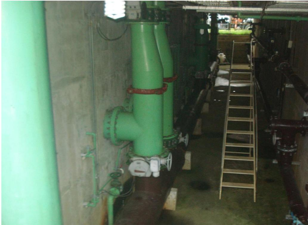
Foto 18 – Tubulações de Limpeza do Fundo dos Tanques dos Decantadores
