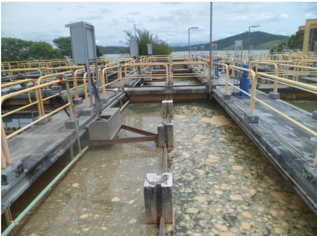
Foto 07 – Tanques de Flocculação
