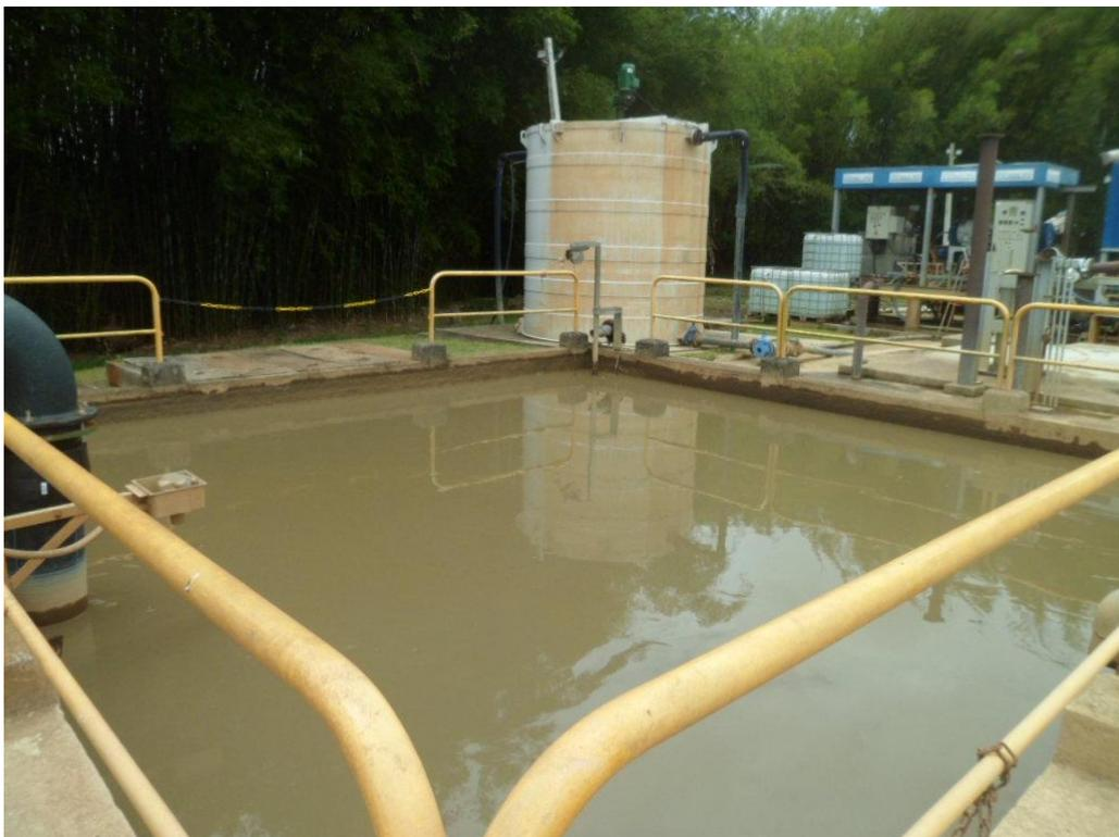
Foto 21 – Tanque de Homogeneizado de Lodo 9000 litros
