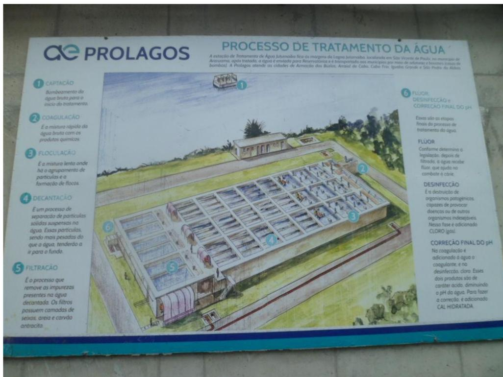
Foto 04 – Quadro esquemático dos Processos de Tratamento da ETA Prolagos
