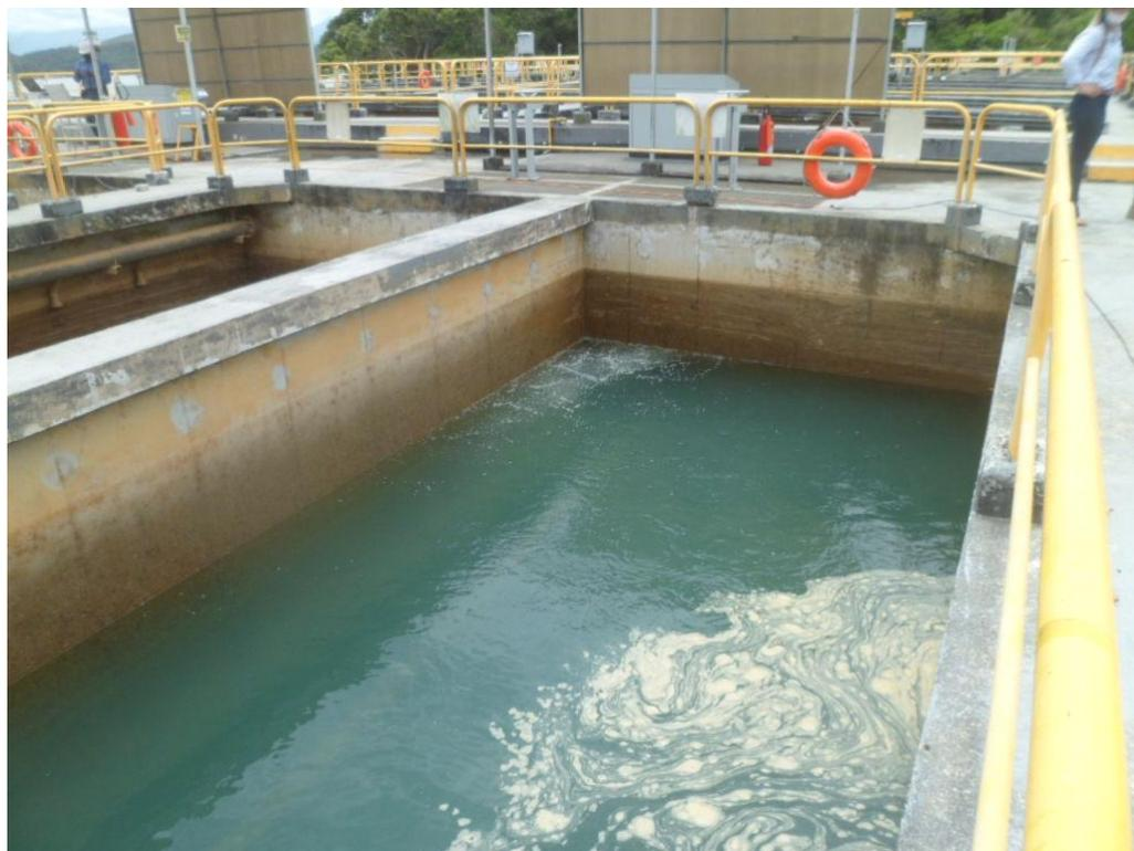
Foto 09 – Tanques de filtros – Sistema de Filtração da ETA2
