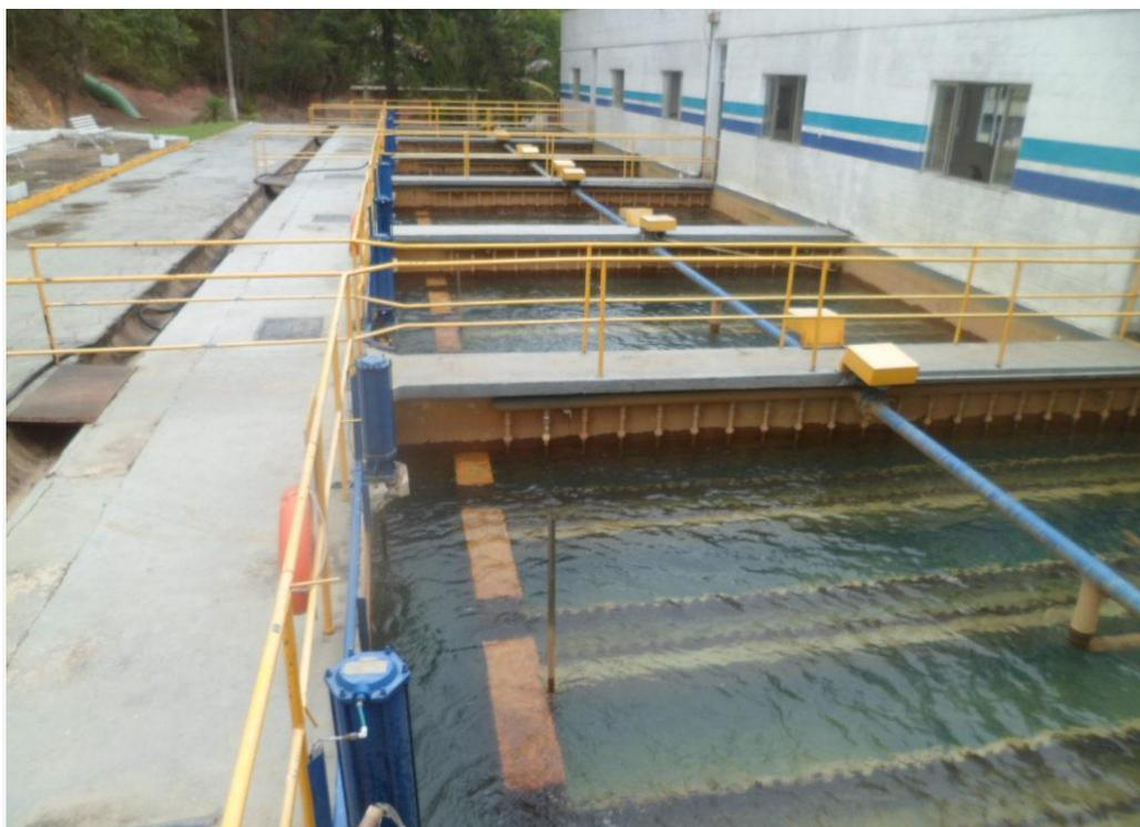
Foto 11 – Tanques de filtros – Sistema de Filtração da ETA1
