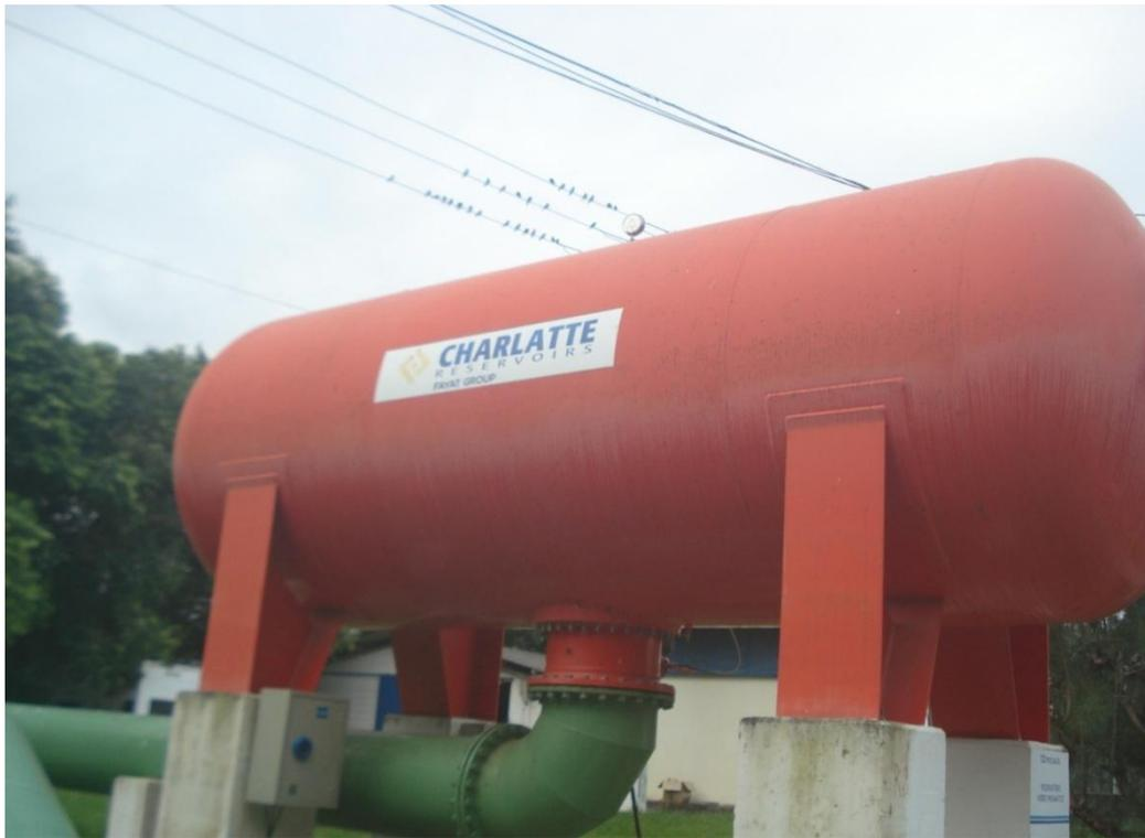
Foto 28 – Tanque Hidropneumático – Atua como Amortecedor
