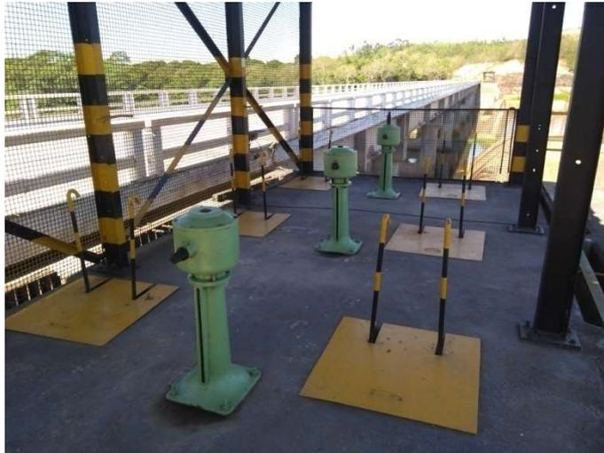
Foto 18 – Acionamento das Comportas, Pedestal de Manobra tipo Volante com Rosca Sem-Fim
