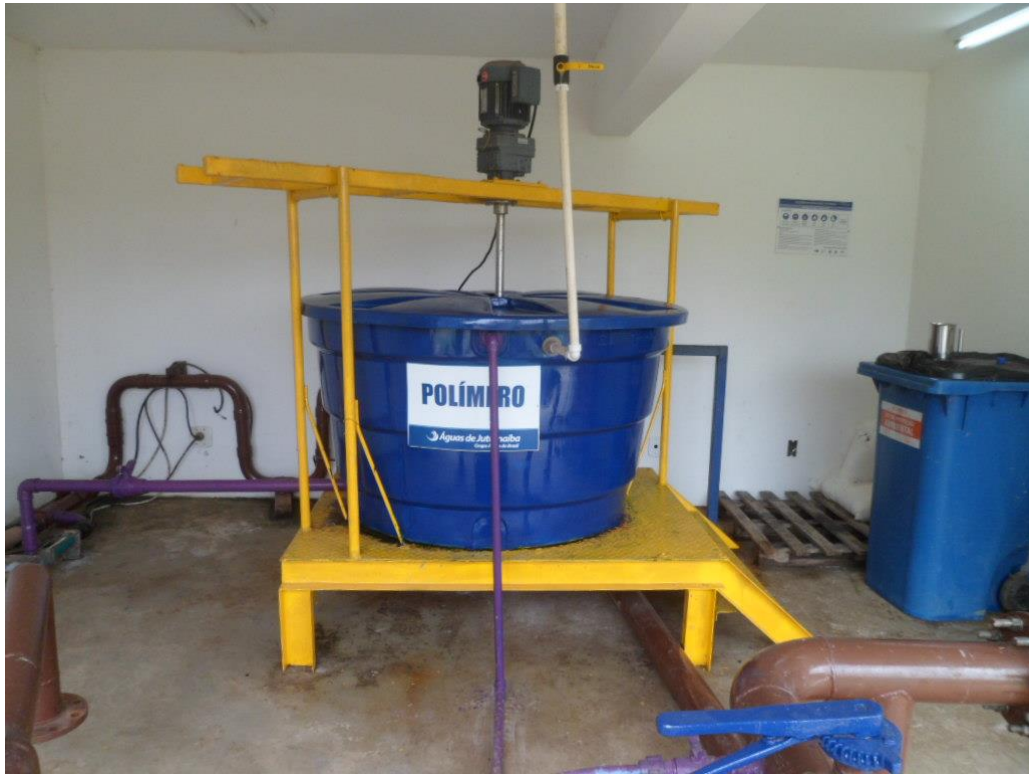
Foto 13 – Reservatório para mistura de Polímeros
