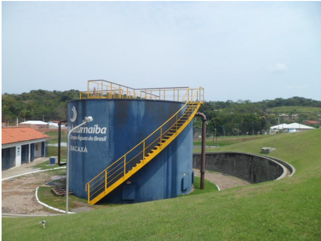
Foto 16 – Tanque de Aeração e Decantação vista lateral
