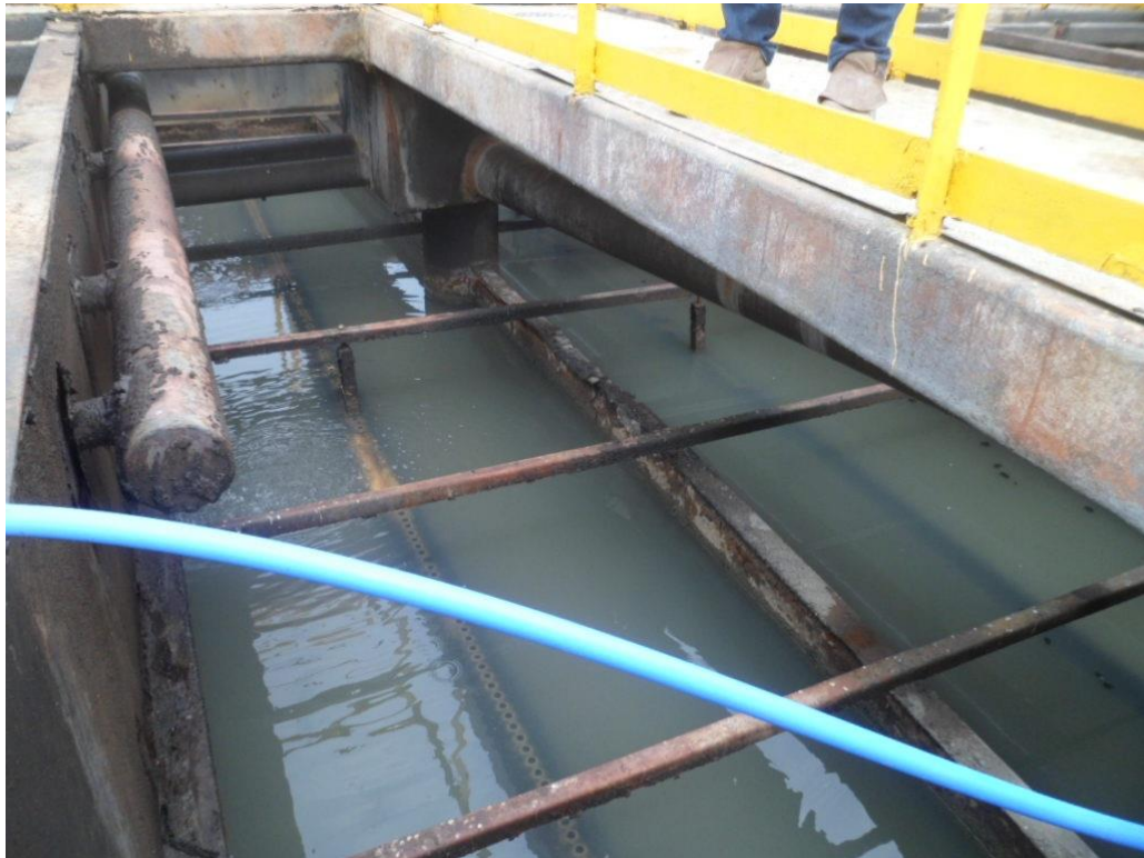
Foto 19 – Tanque de Decantação
