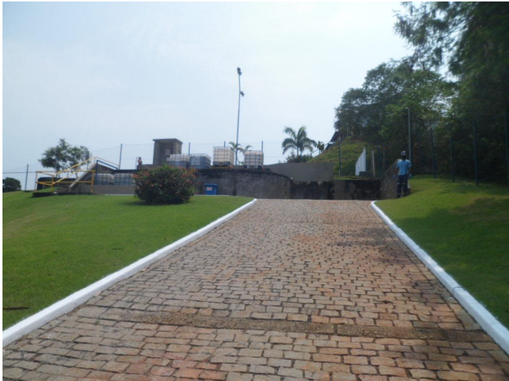
Foto 05 – Rampa de acesso a parte preliminar do processo de tratamento
