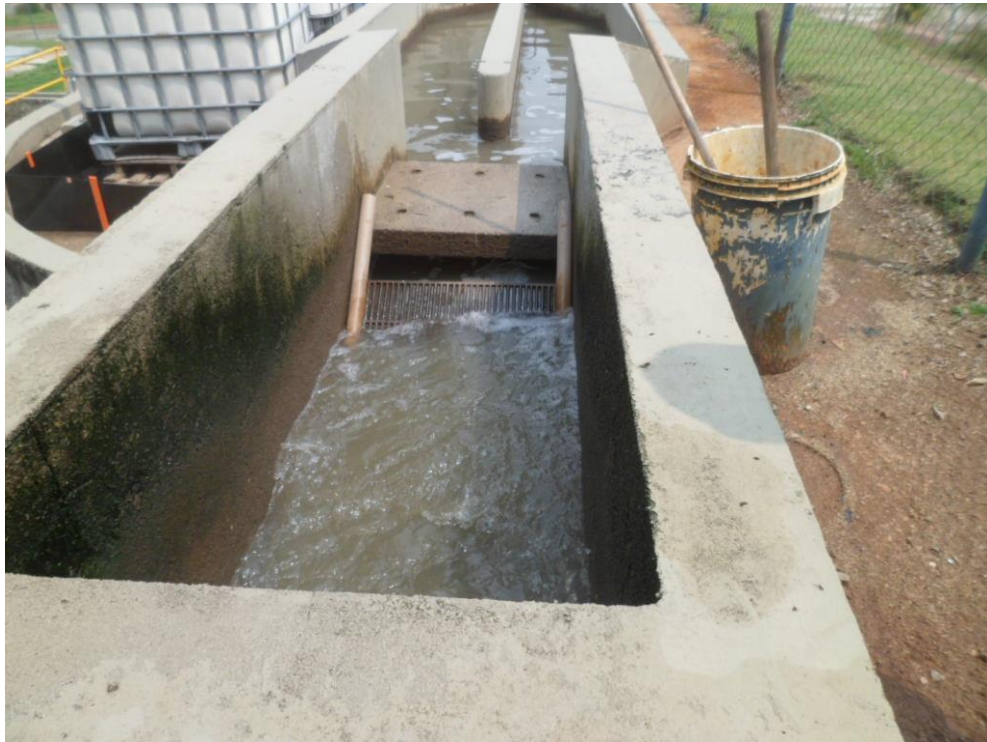
Foto 07 – Gradeamento fino para retenção de resíduos sólidos
