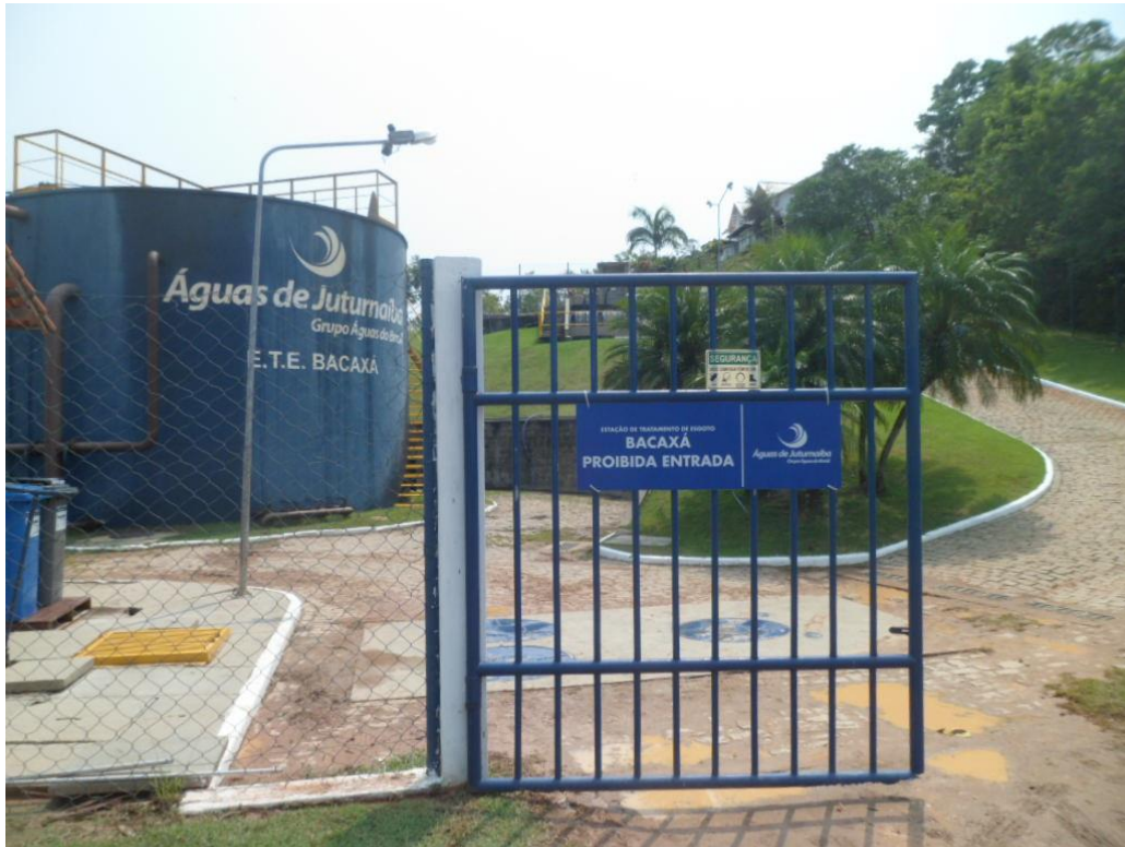
Foto 01 – Entrada da Estação de Tratamento de Esgoto (ETE) Bacaxá
