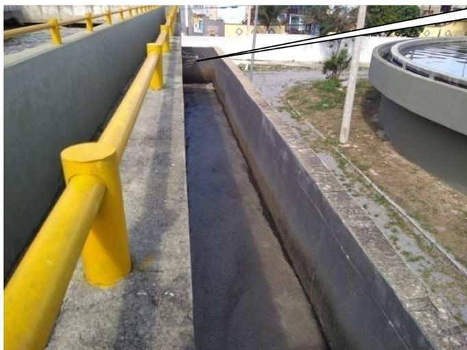
Foto 10 – Passagem do Tanque de Aeração para o Decantador
