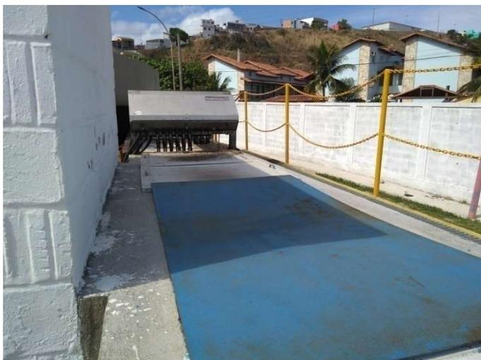
Foto 21 – Saída do Esgoto Tratado e Desinfecção com Ultravioleta
