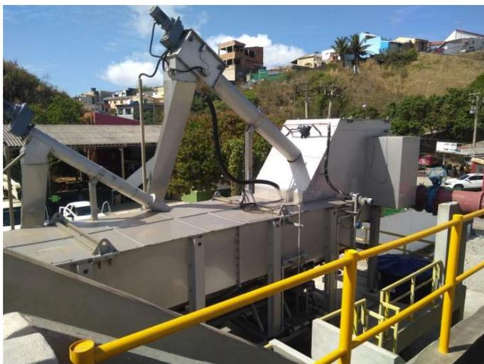
Foto 05 – Equipamento Preliminar Compacto Integrado
