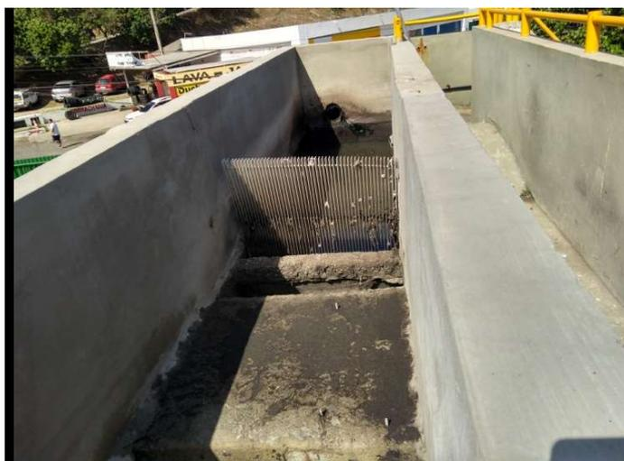
Foto 04 – Segundo Gradeamento Antes do Tanque de Aeração
