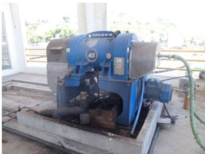
Foto 14 – Centrifuga Desidratação do Lodo
