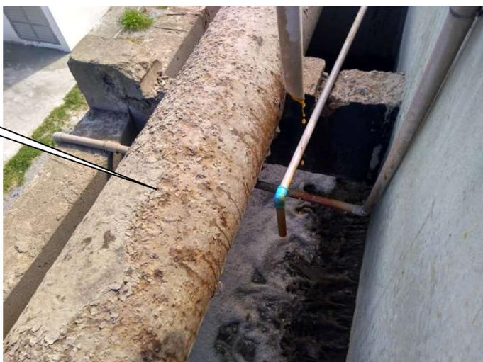
Foto 11 – Aplicação de PAC na Saída do Tanque de Aeração
