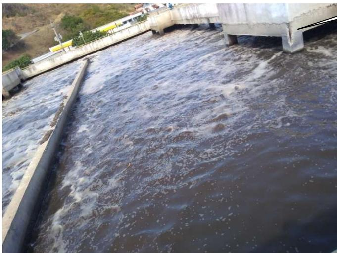
Foto 09 – Tanques com 04 (quatro) Aeradores
