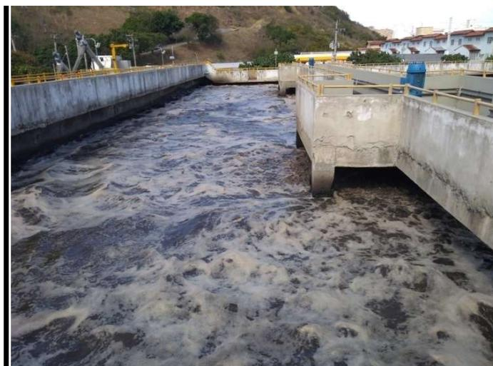
Foto 08 – Tanques com 04 (quatro) Aeradores
