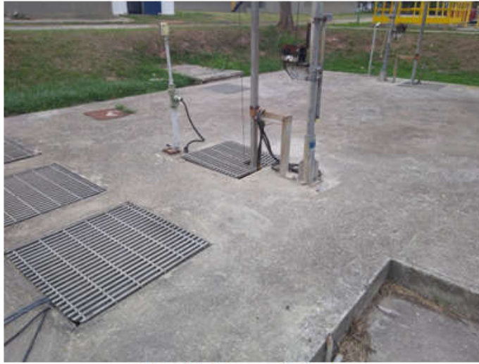
Foto 13 – Tanque de Lodo
