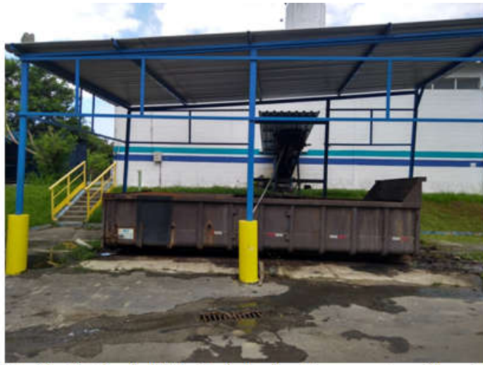
Foto 16 – Esteira de Retirada do Lodo e Lançamento na Caçamba
