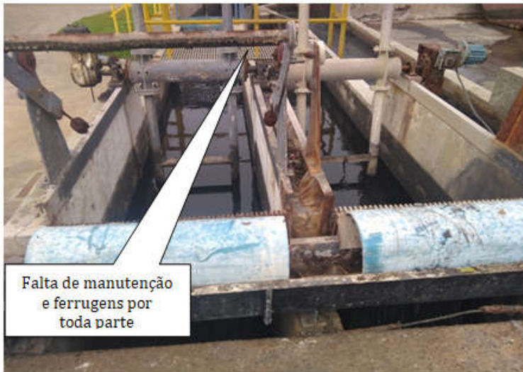
Foto 05 – Pás Mecanizadas sem Manutenção com muita ferrugem
