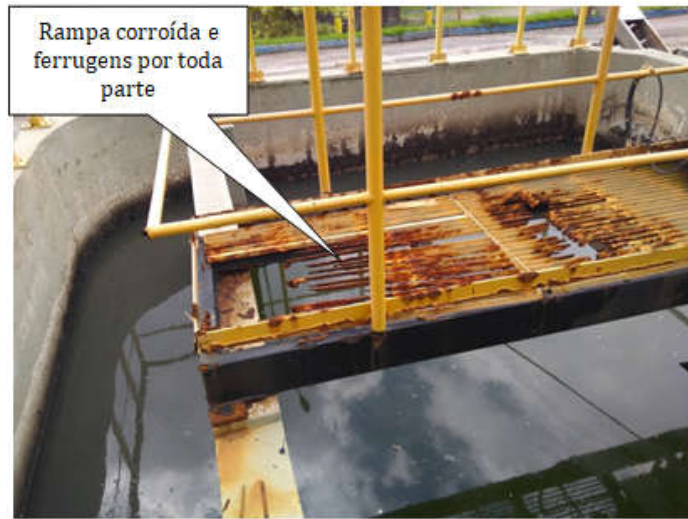
Foto 07 – Rampa acima do Desarenador completamente corroído de ferrugem
