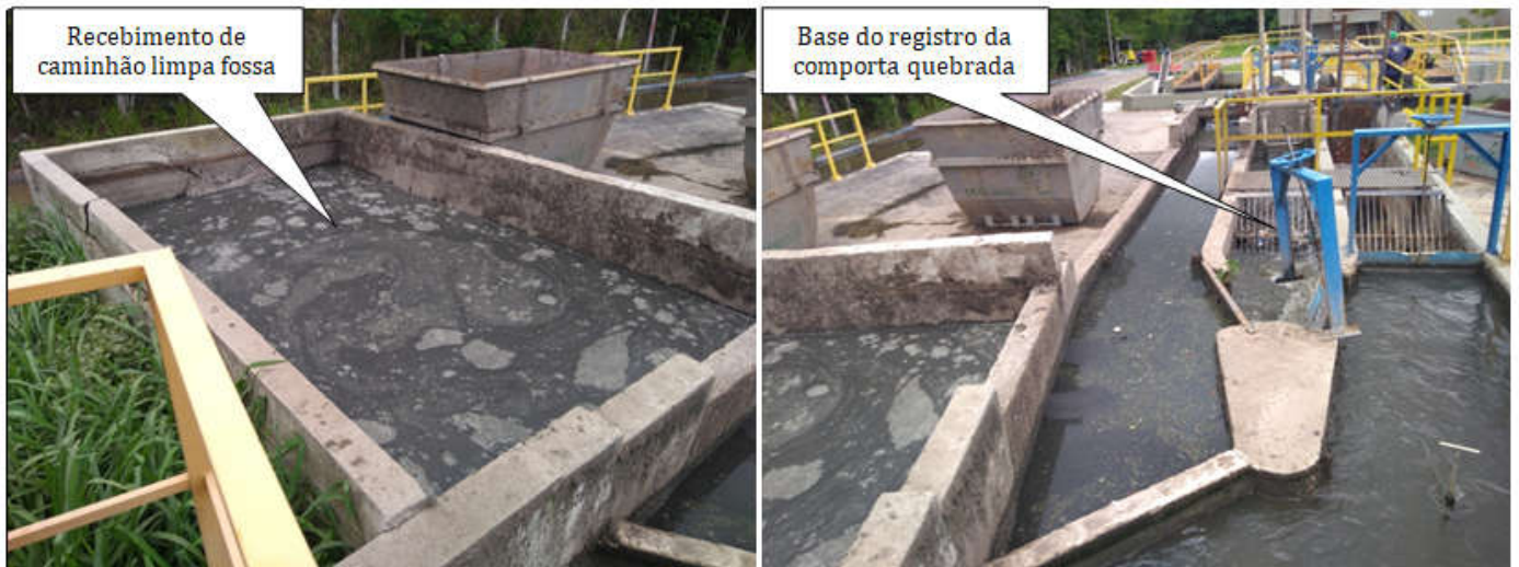
Foto 03 – Local de Recebimento do Caminhão Limpa Fossa (gradeamento e caixa de areia)
