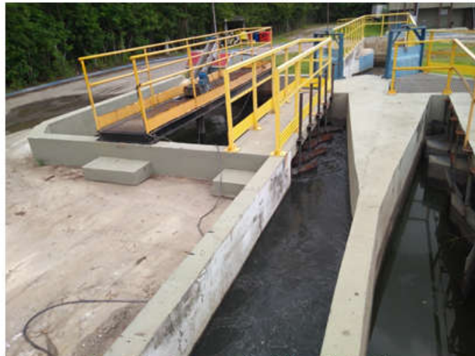
Foto 06 – Desarenador (Caixa de Areia)
