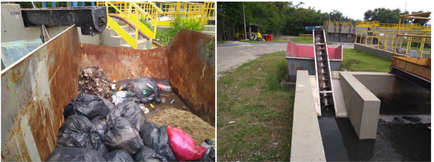
Foto 08 – Rosca Transportadora Retira a Areia do Desarenador e Direciona para a Caçamba, (sem areia dos desarenadores)
