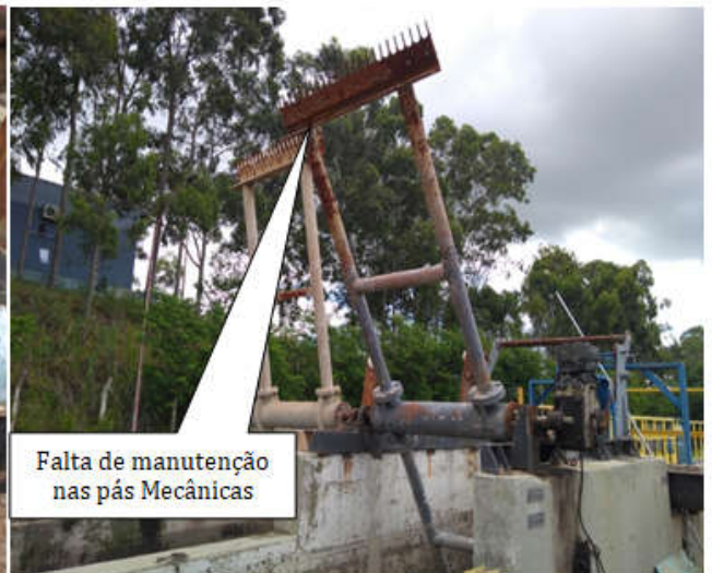
Foto 05 – Pás Mecanizadas sem Manutenção com muita ferrugem
