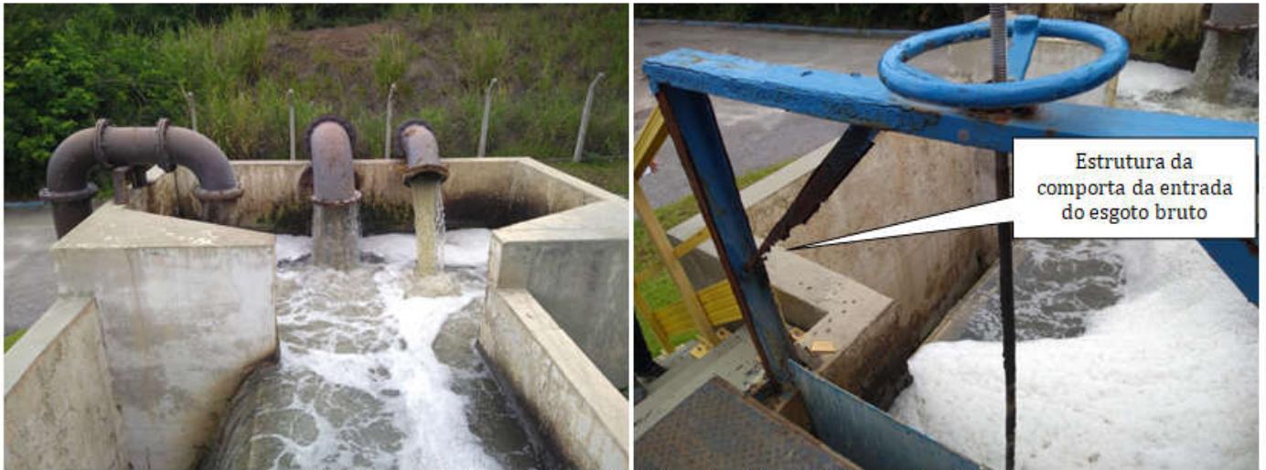
Foto 02 – Entrada do Esgoto Bruto In Natura das 03 (três) Elevatórias 120 l/s
