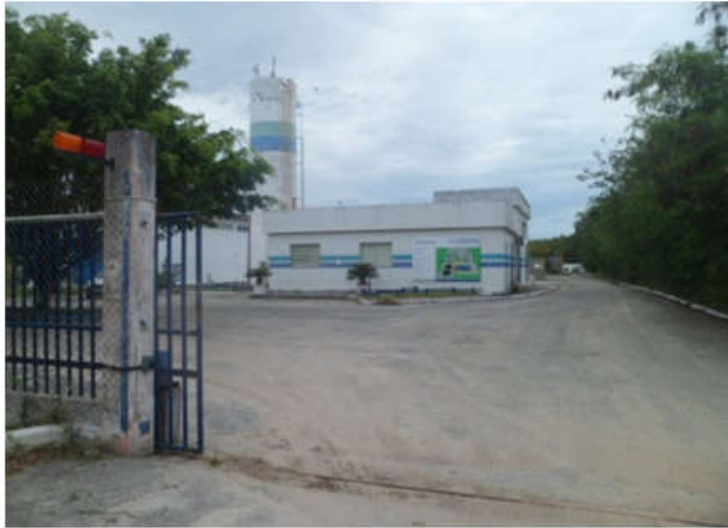
Figura 1 – Entrada da Estação de Tratamento de Esgoto.
