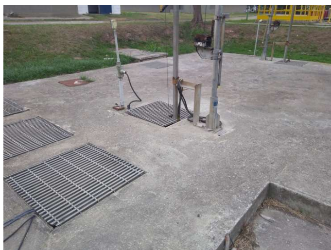
Foto 14 – Tanque de Lodo
