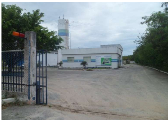
Foto 01 – Entrada da Estação de Tratamento de Esgoto
