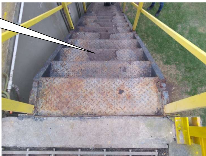
Foto 12 – Escada de Acesso ao Tanque de Aeração
