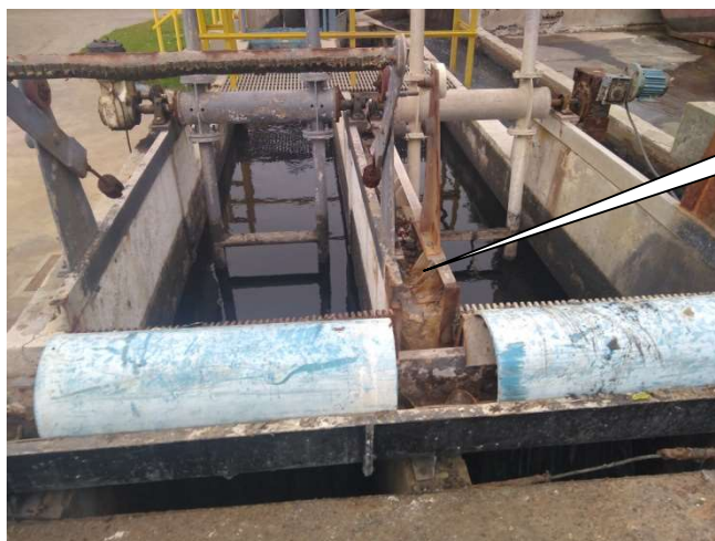
Foto 04 – Gradeamento para Retenção e Retirada dos Resíduos, Acionados por pás Mecânicas
