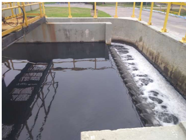
Foto 05 – Desarenador (Caixa de Areia)
