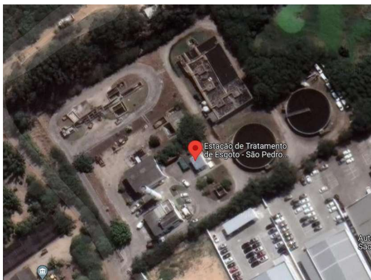
Vista Aérea (Google) ETE São Pedro da Aldeia
