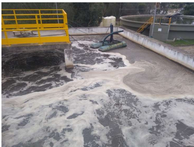
Foto 11 – Tanques com 04 (quatro) Aeradores, sendo 01 (um) aerador flutuante, que trabalham por ventura
