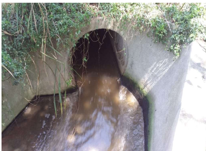
Foto 26 – Saída do Esgoto tratado e lançado no Rio Piripiri
