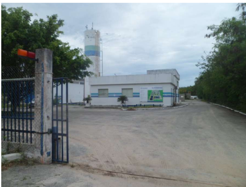
Entrada da Estação de Tratamento de Esgoto São Pedro da Aldeia
