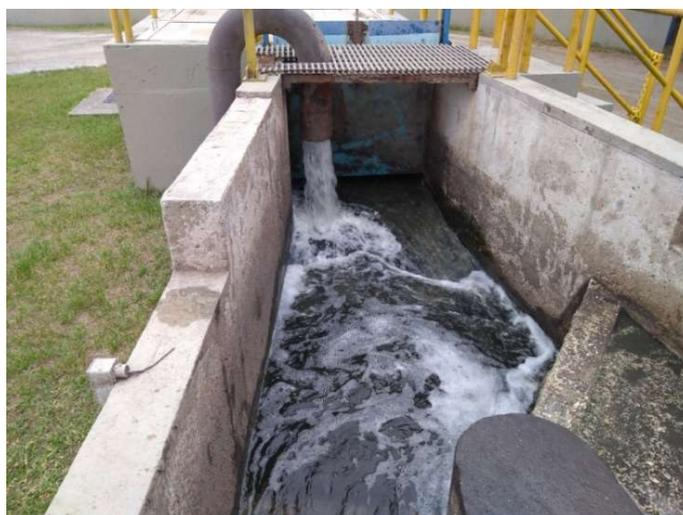
Foto 02 – Entrada do esgoto *In Natura* na Estação
