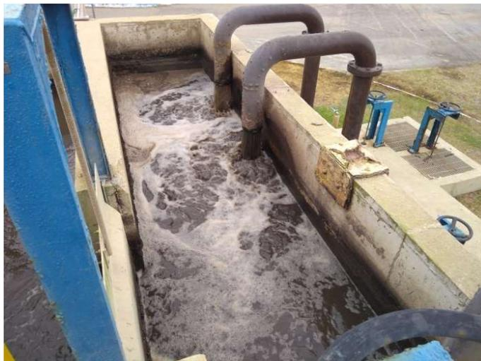
Foto 09 – Elevatória de Esgoto Bruto e Recirculado
