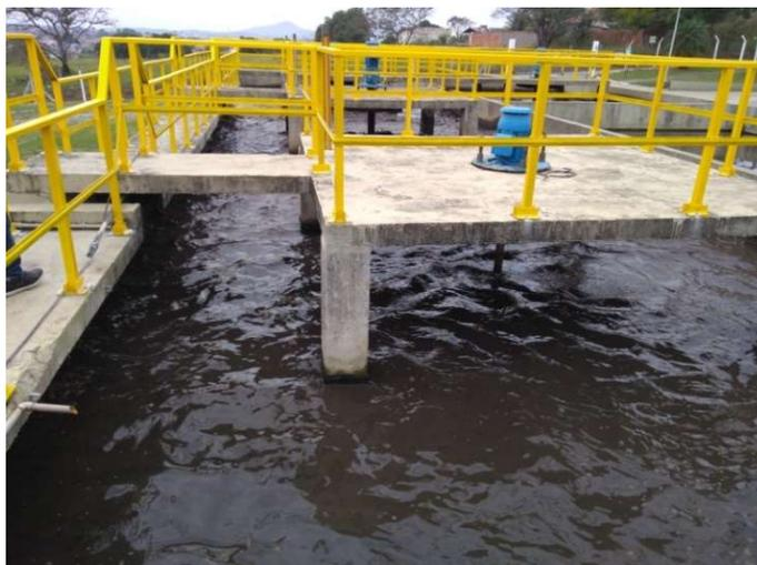
Foto 10 – Tanques com quatro aeradores
