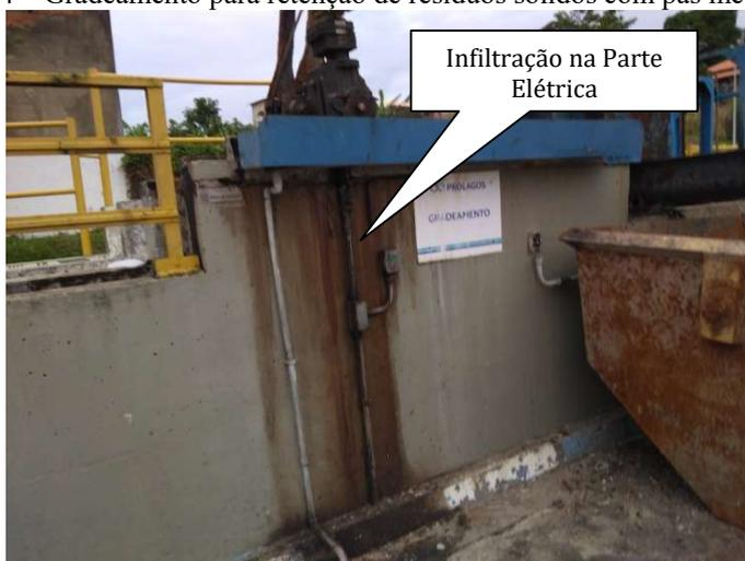
Foto 05 – Gradeamento para retenção de resíduos sólidos com pás mecânicas, com Infiltração, podendo causar um dano na parte Elétrica
