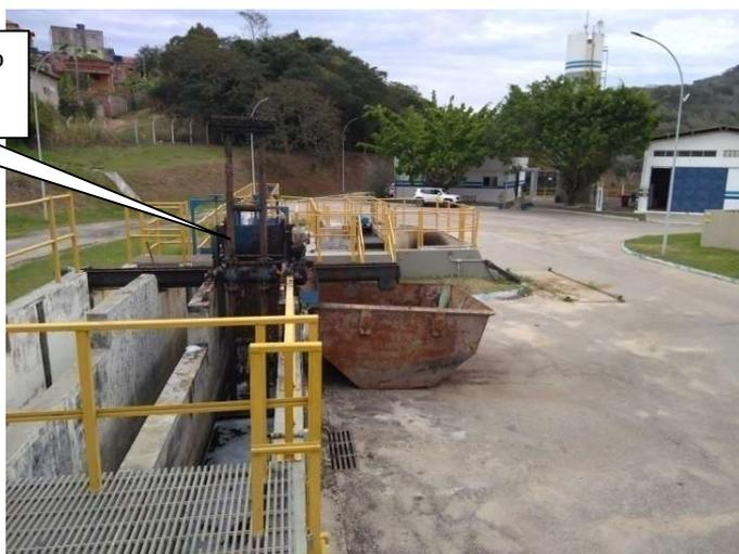
Foto 04 – Gradeamento para retenção de resíduos sólidos com pás mecânicas
