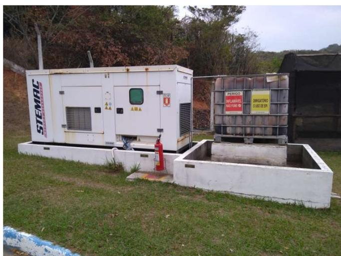
Foto 25 – Gerador e Tanque de Diesel
