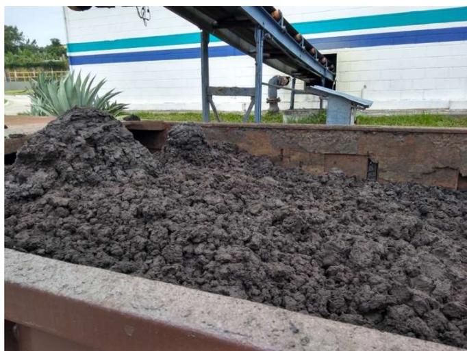
Foto 17 – Esteira de Retirada do Lodo e Lançamento na Caçamba
