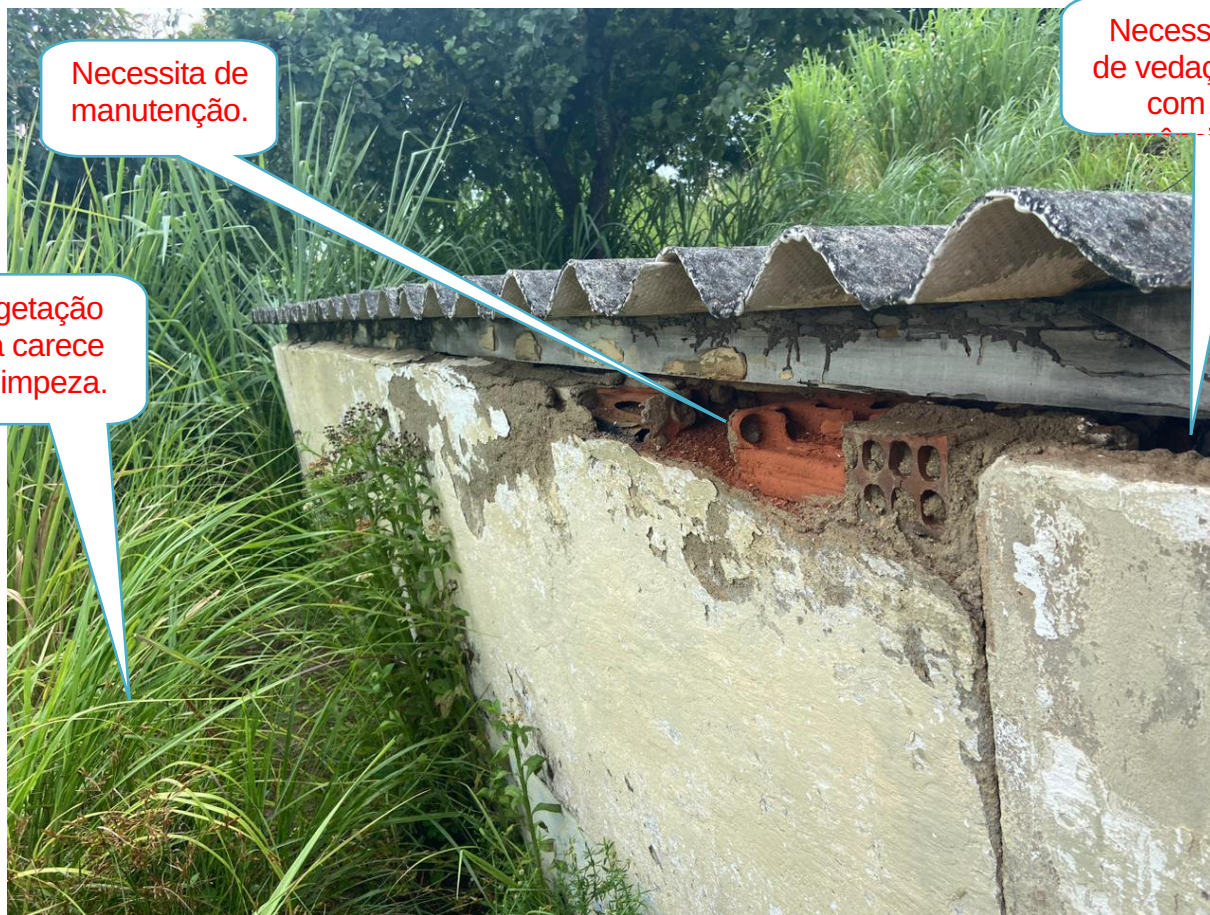
Parede externa do reservatório
