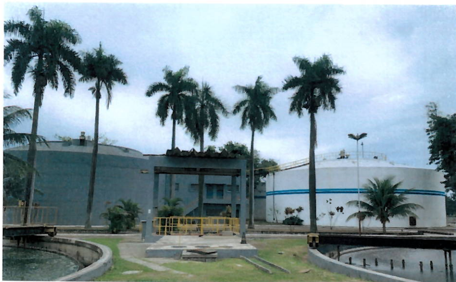
Vista frontal dos biodigestores existentes na Estação
