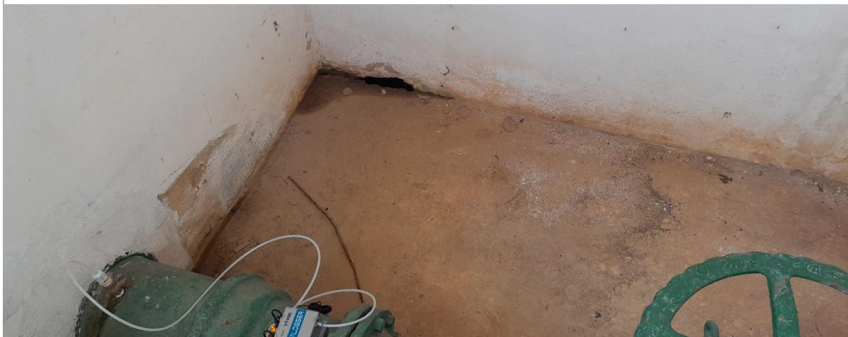
Descascamento/queda reboco Ponto de erosão subterrânea
