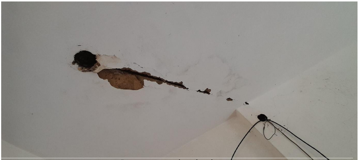
Descascamento/queda reboco Ponto de erosão subterrânea
