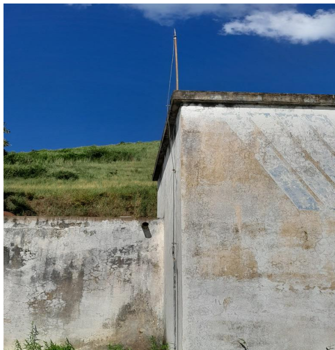
Sistema de pára-raios
