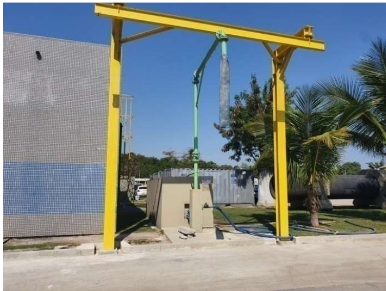
Foto 21 – Reservatório de água potável
