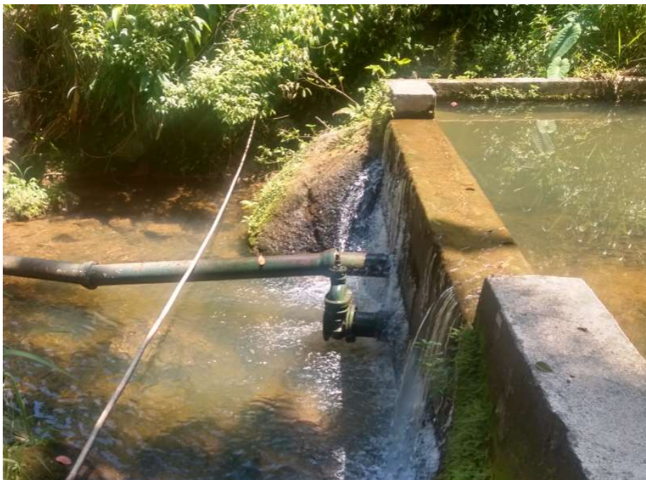
Tubulação de adução da captação Coqueiros e descarga de fundo
