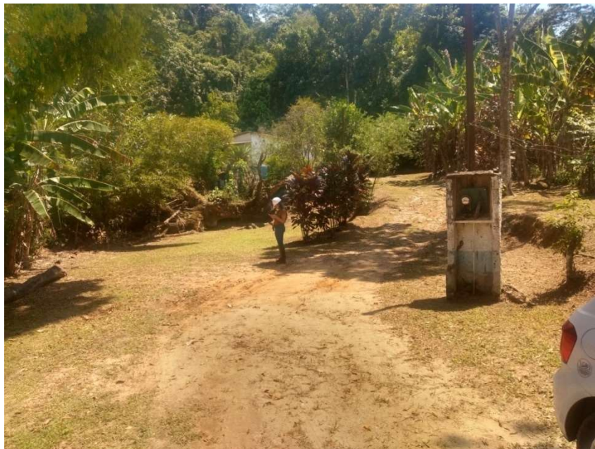
Entrada da Unidade de Tratamento (UT) de Tachas
