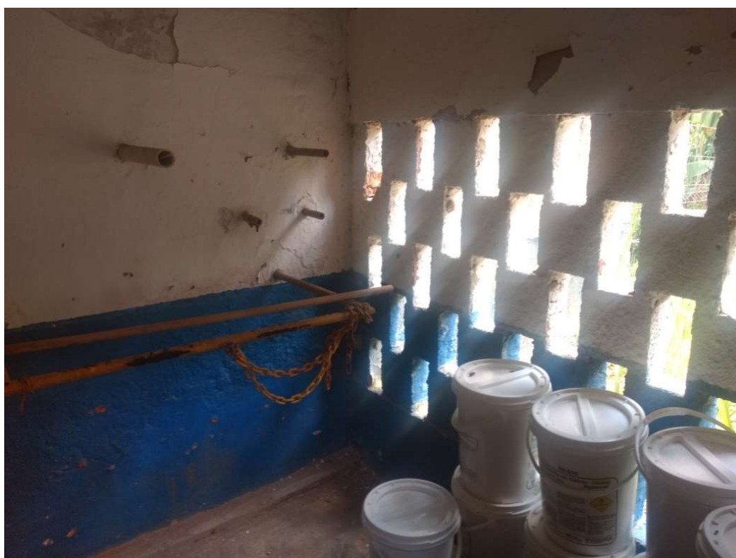
Pastilhas de hipoclorito de cálcio guardadas no depósito de produtos químicos Situado na captação Andorinhas
