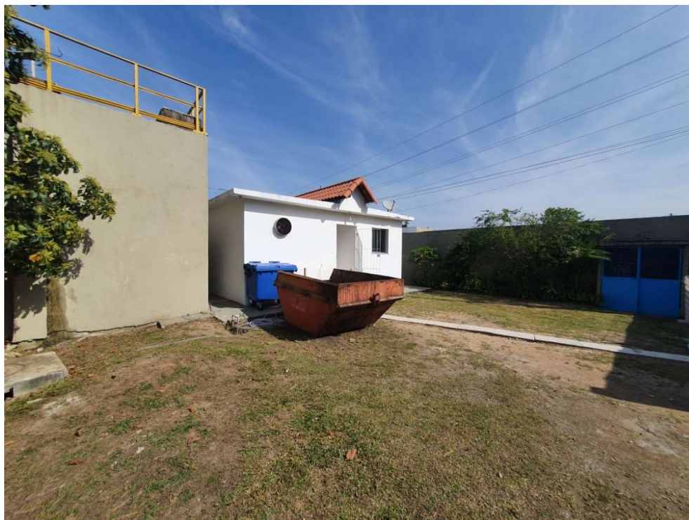
Foto 01 – Estação de Tratamento de Esgoto Vargem Grande
