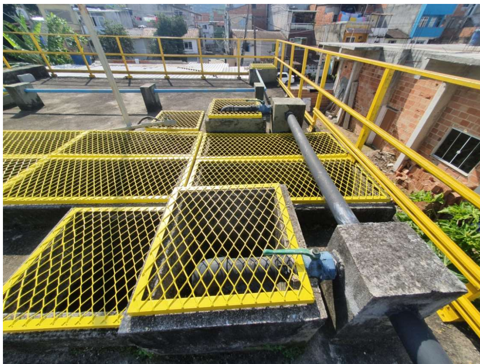
Foto 06 – Entrada no tanque de aeração
