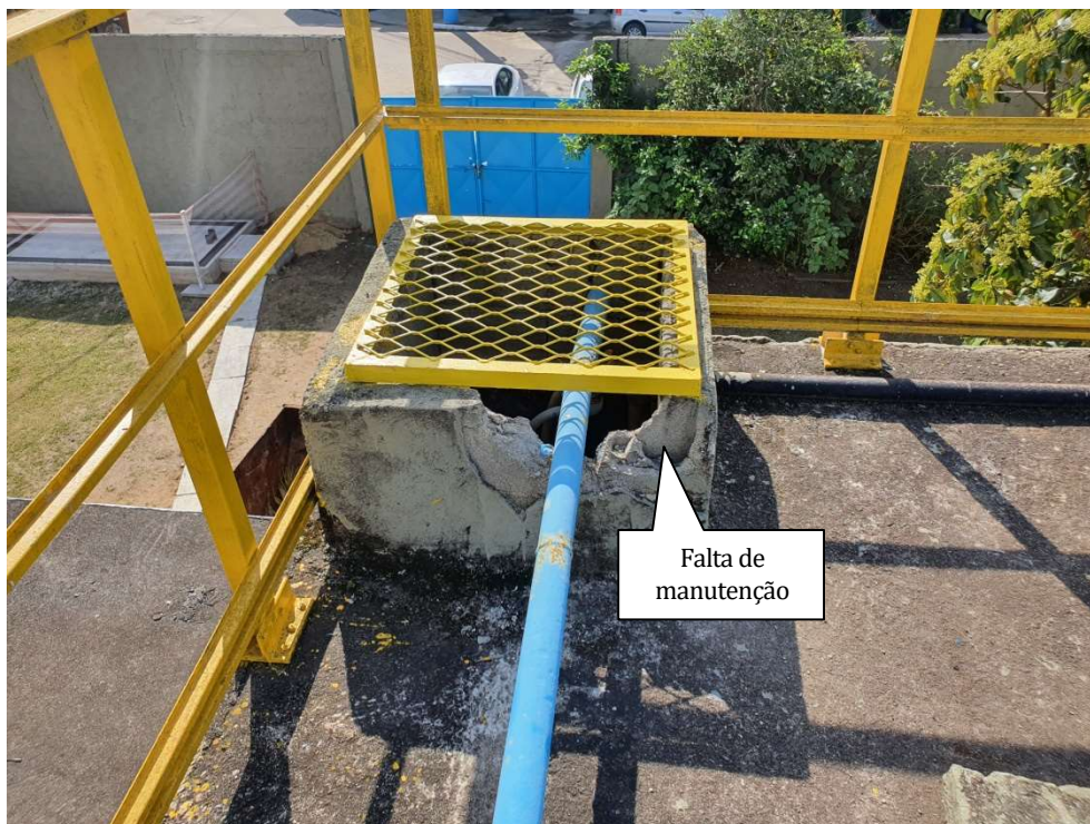
Foto 11 – Tanque de aeração
