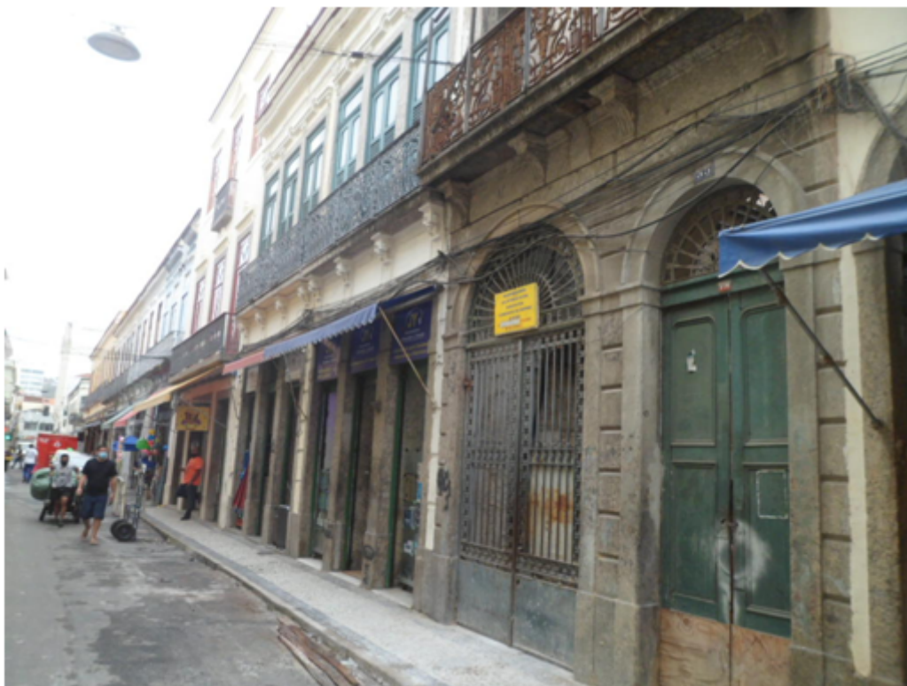
Foto 03 – Rua Regente Feijó, 53 – Centro (Sentido Oposto da Rua)
