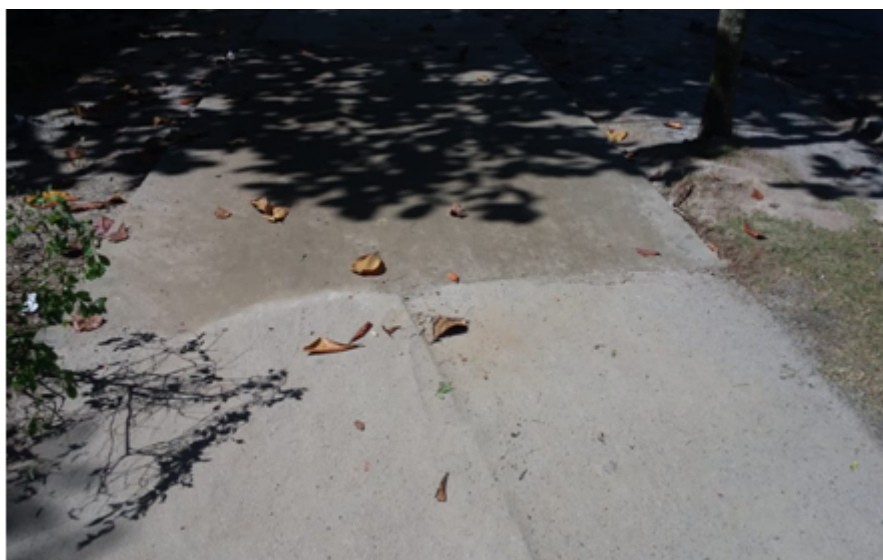
Foto 05 – Obras realizadas para implantação de Rede Separativa
