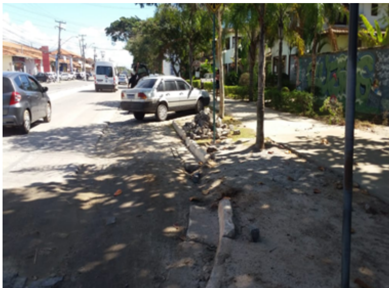
Foto 06 – Obras realizadas para implantação de Rede Separativa
