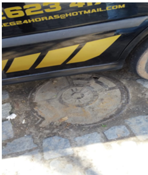
Foto 02 – (PV) Poço de Visita da Rede Pluvial em frente ao n° 5400
