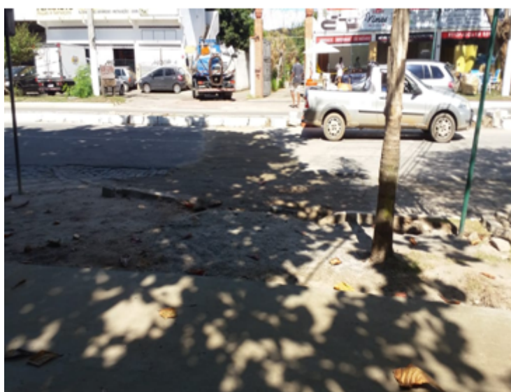
Foto 07 – Obras de implantação de Rede Separativa atravessando a Av. Principal
