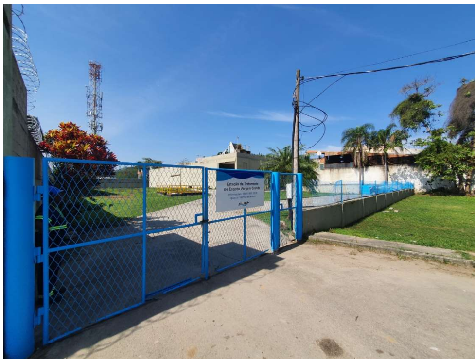
Foto 02 – Entrada da Estação de Tratamento de Esgoto Vargem Grande
