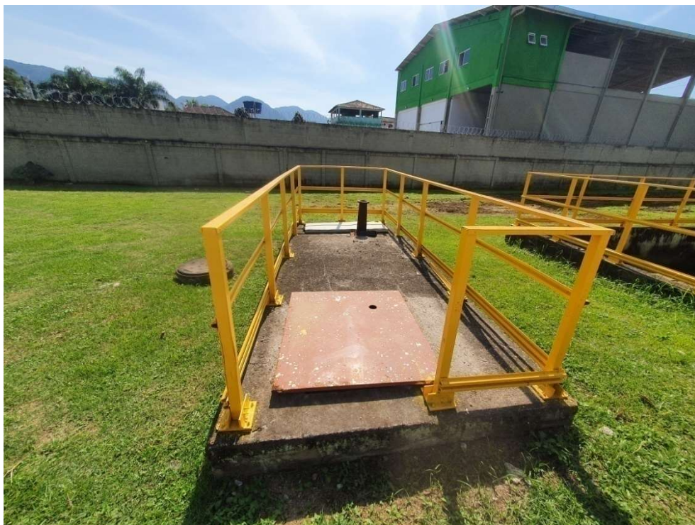
Foto 05 – Casa de bombas da elevatória
