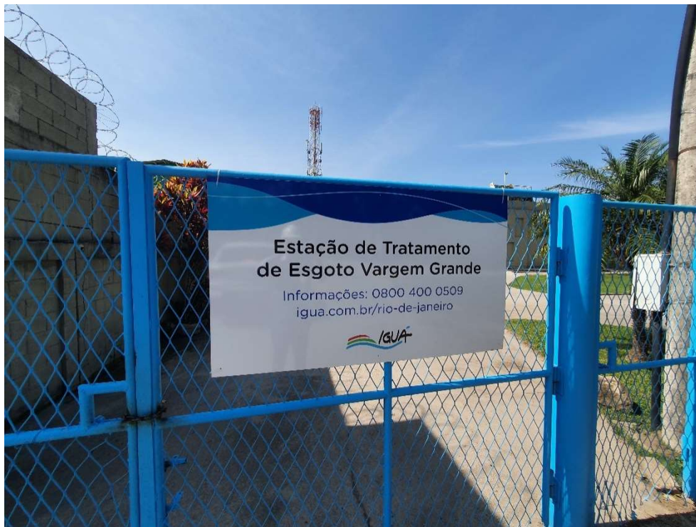
Foto 01 – Entrada da Estação de Tratamento de Esgoto Vargem Grande
