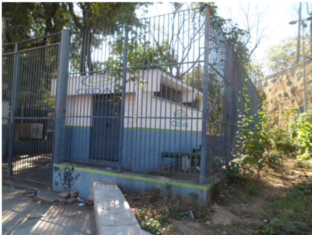
Foto 01 – Elevatória que abastece a Rua Tambaú e o Bairro de Ramos
