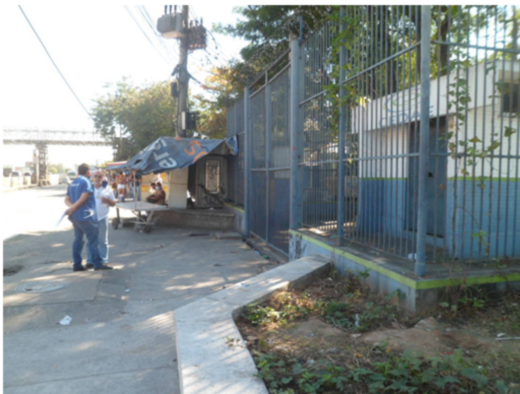
Foto 02 – Elevatória que Abastece a Rua Tambaú – Localização (Av: Brasil)
