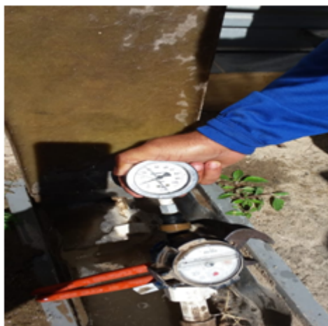
Foto 04 – Instalação do Manômetro para medir a pressão da água
