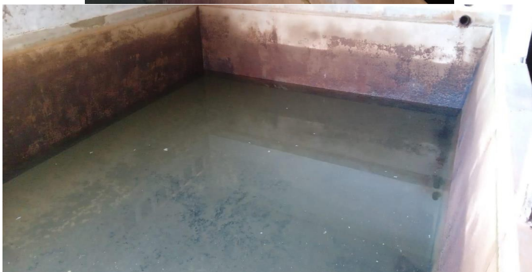
Compartimento interno do reservatório 01.
