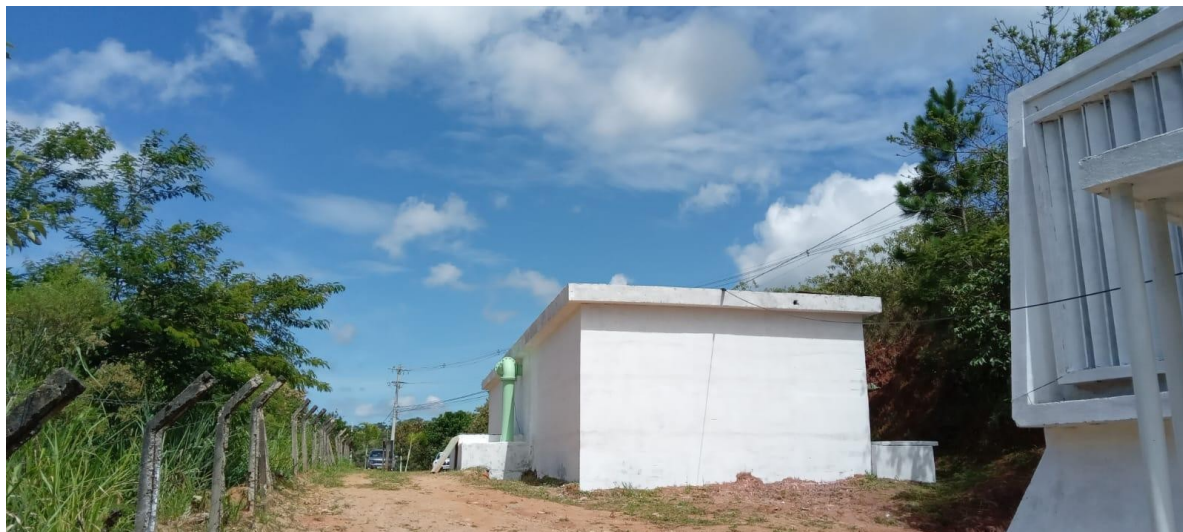
Pátio dos Reservatórios.
