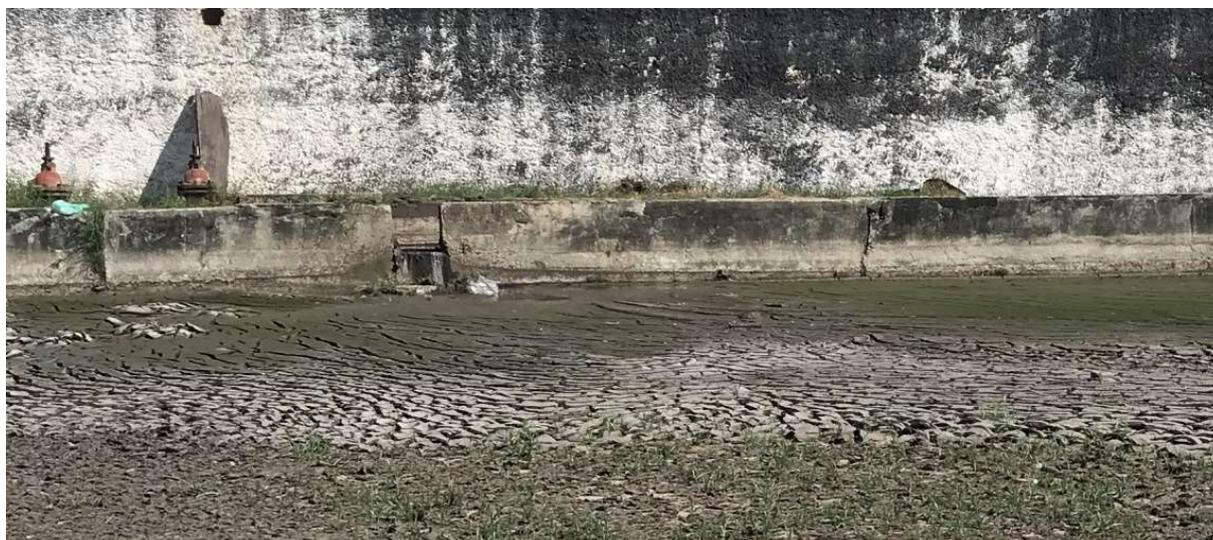
Verificamos que a remoção do lodo seco não vem sendo realizada antes de se dar nova carga de lodo digerido. Observamos tais problemas como:
