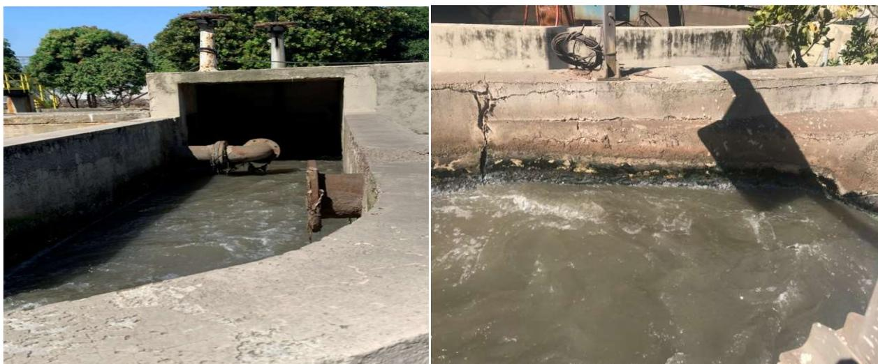
Desarenador - Falta de manutenção
