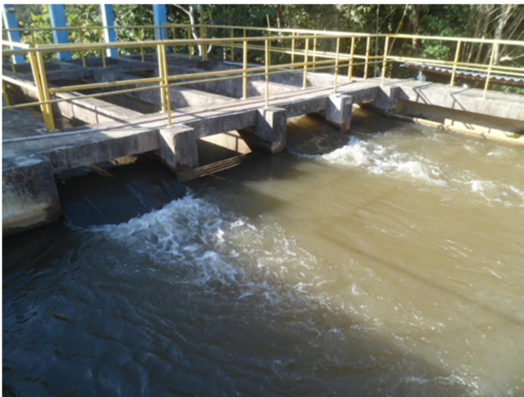
Foto 09 – Poço Alagado e Desarenadores
