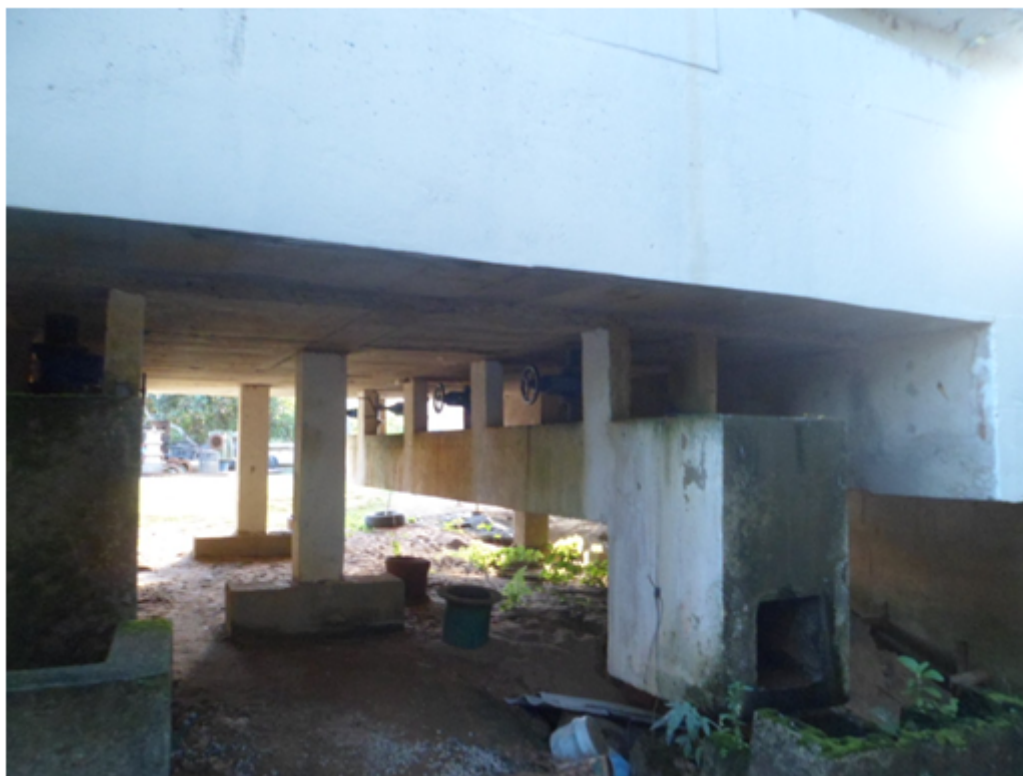
Foto 17 – Registros de Descarga dos Desarenadores
