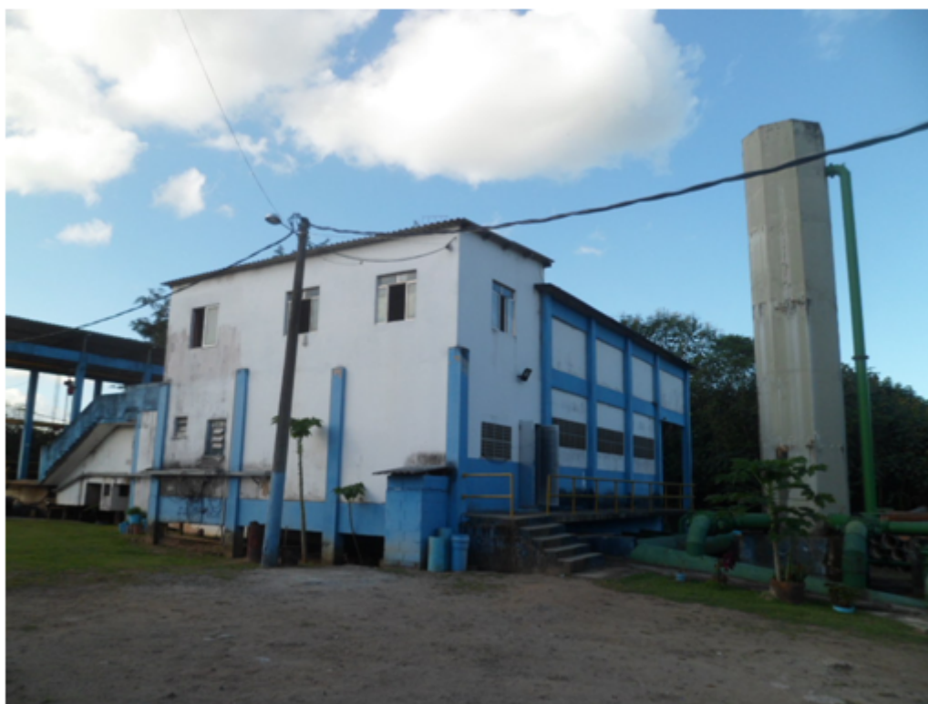
Foto 02 – Prédio Principal da (EEAB)
