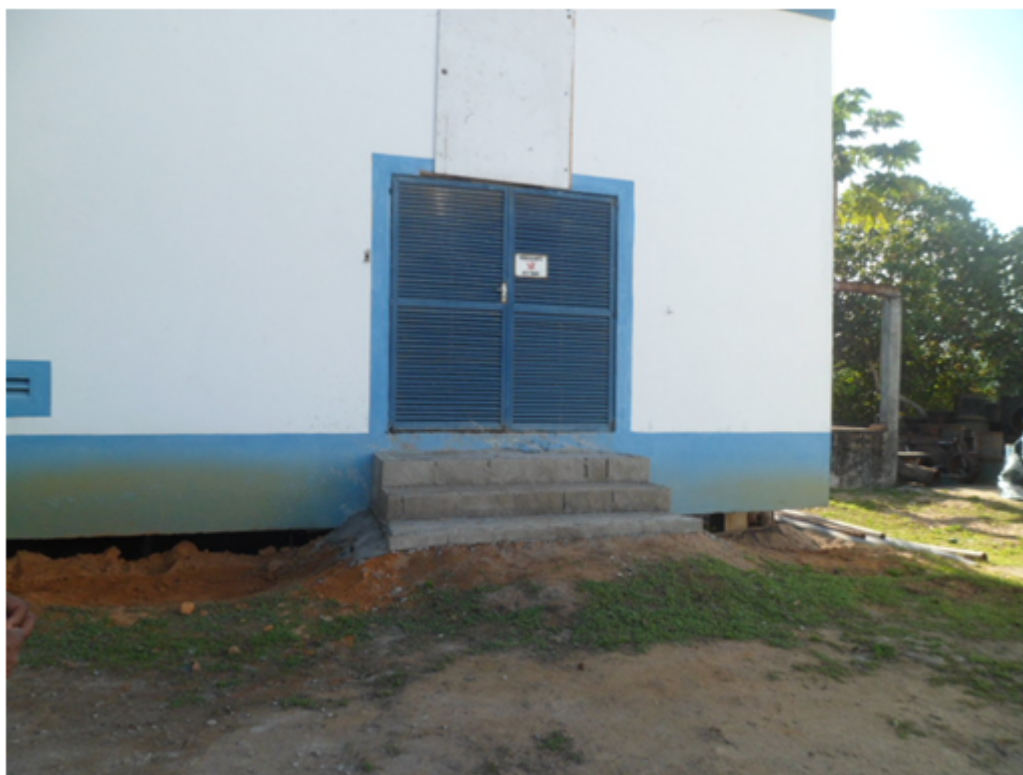
Foto 18– Casa de Energia
