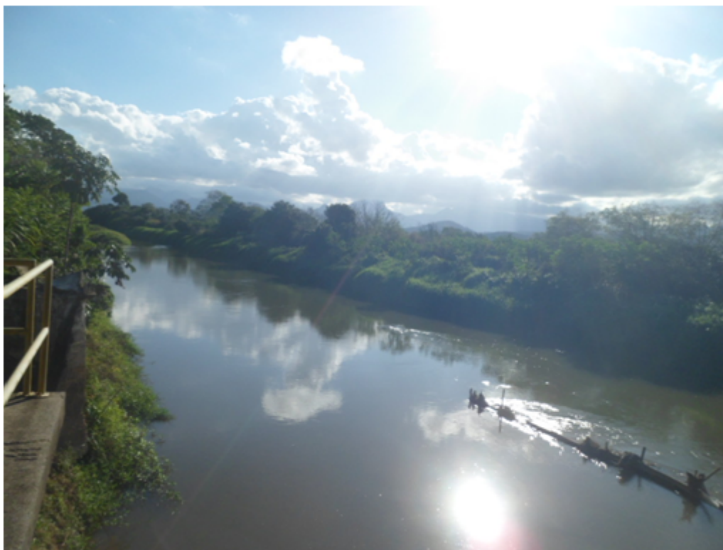
Foto 03 – Captação de Água Bruta - Rio Macaé
