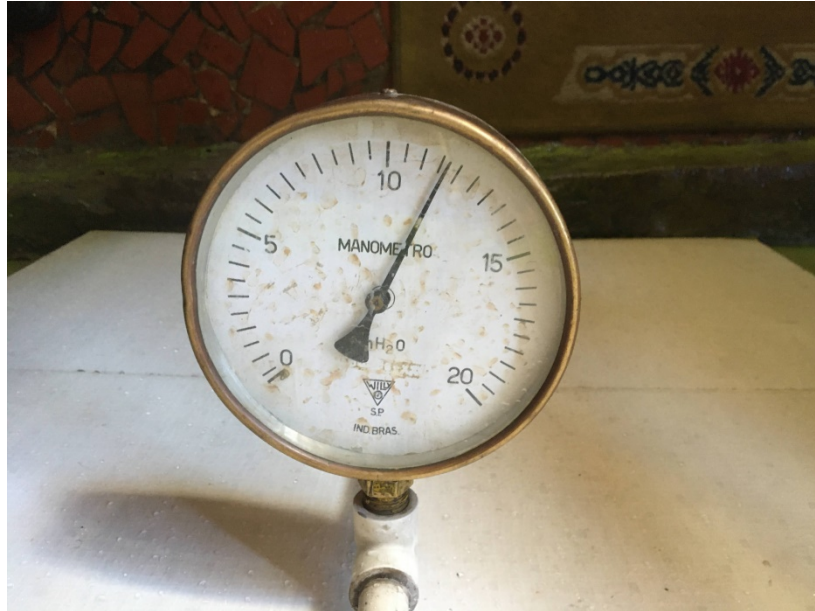
Foto 05 – Registro da pressão na ocasião da vistoria técnica
