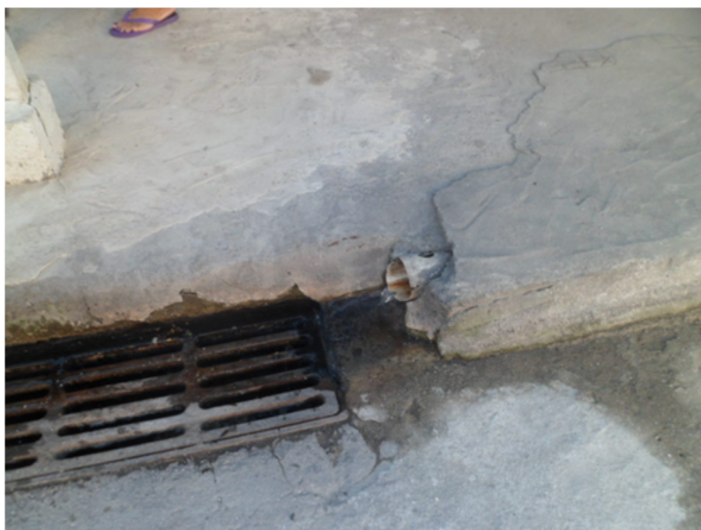
Foto 08 – Saída de Água das Casas para Rede Pluvial (lateral direita)
