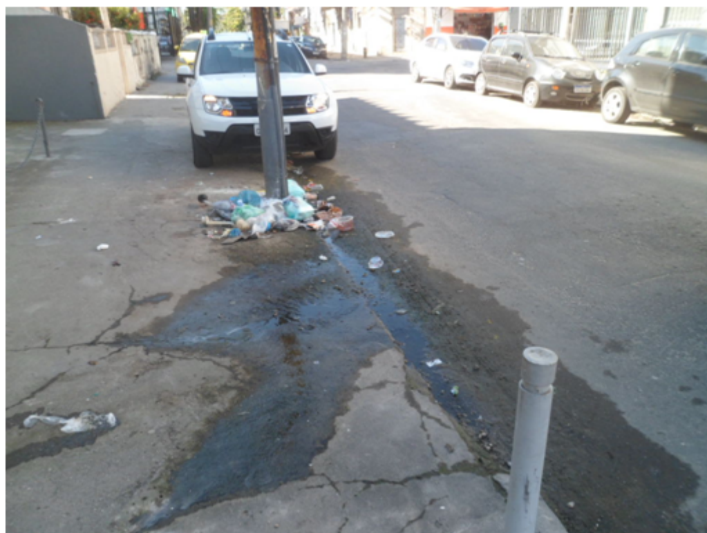
Foto 06 – Infiltração da Caixa de Passagem de Cabo de Energia
