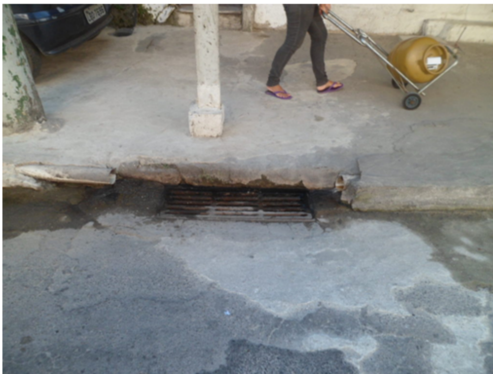
Foto 09 – Duas Saídas das Casas para Rede de Águas Pluviais
