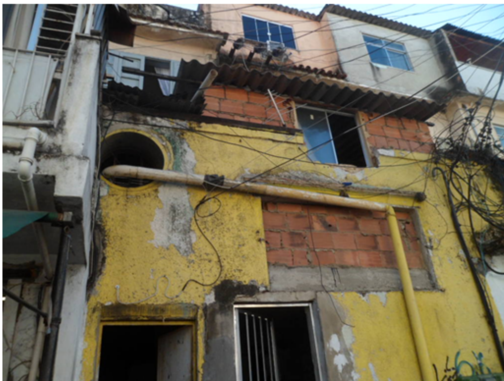
Foto 11 – Descida da Tubulação de 100 mm na Fachada de Várias Casas
