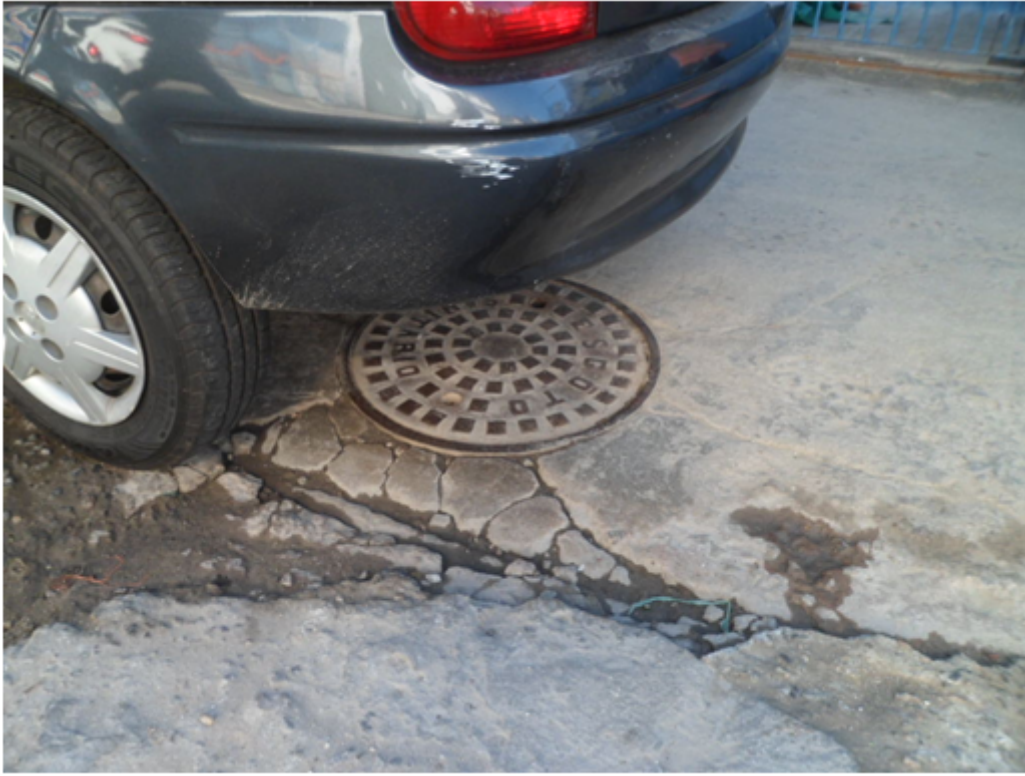
Foto 12 – Tampa de (PV) de Esgoto (Sem presença de Transbordamento)
