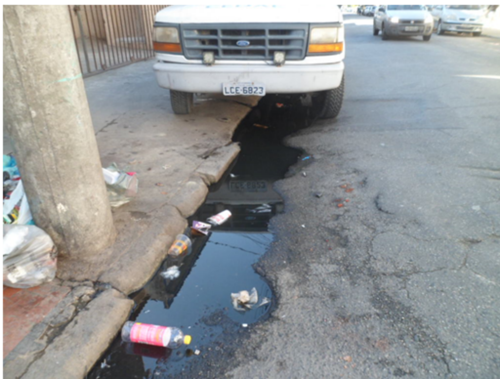
Foto 03 – Água Empoçada Próximo ao nº 890
