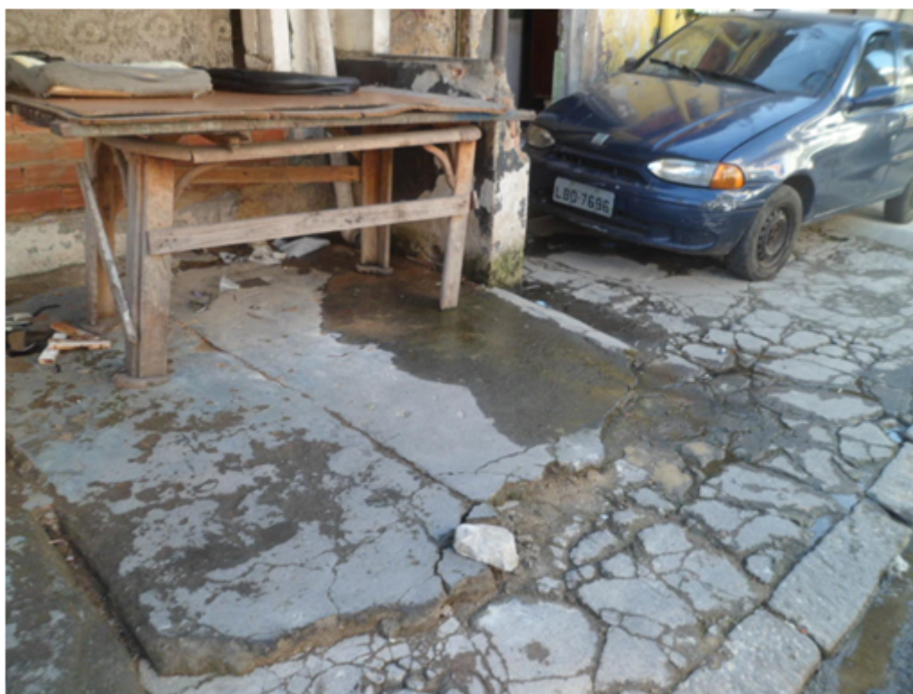
Foto 10 – Descida da Tubulação de 100 mm na Frente da Casa
