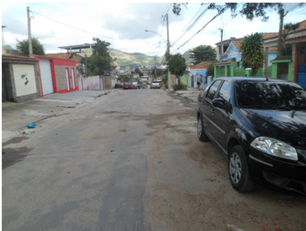
Foto 04 – Rua Souza Freitas – Marcas da obra nas duas extremidades da rua
