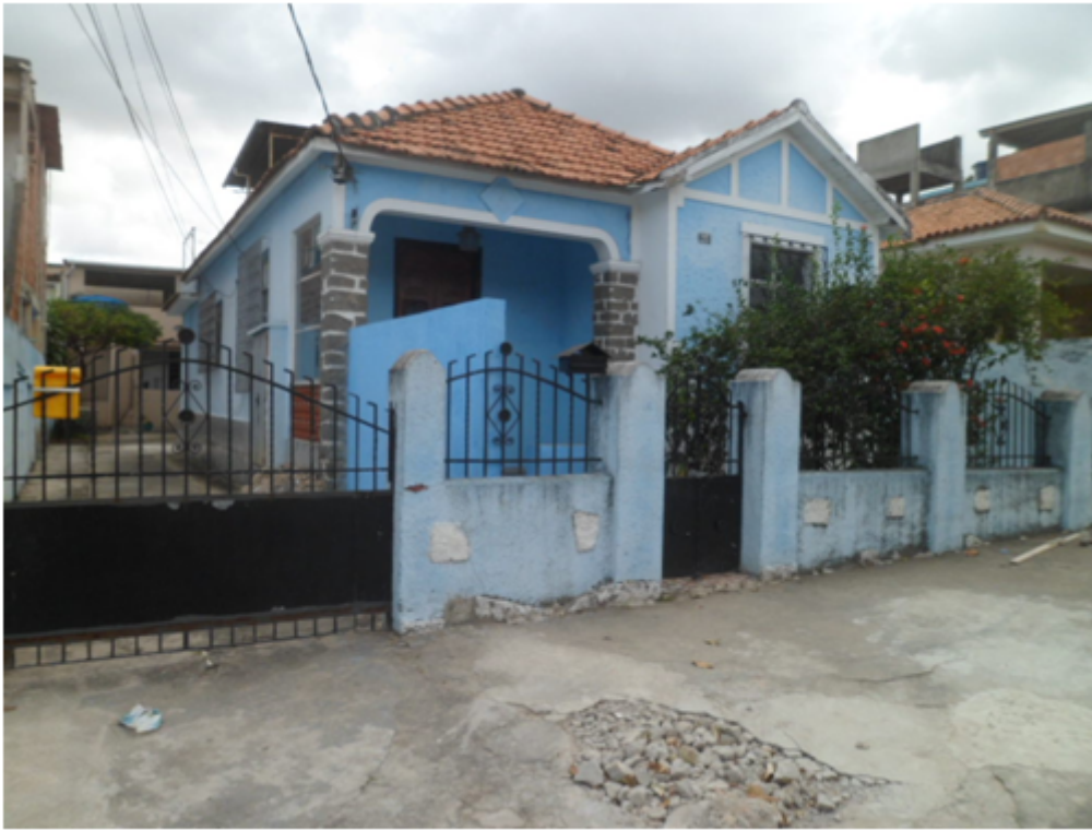
Foto 07 –Rua Souza Freitas, 215 – Calçada Danificada
