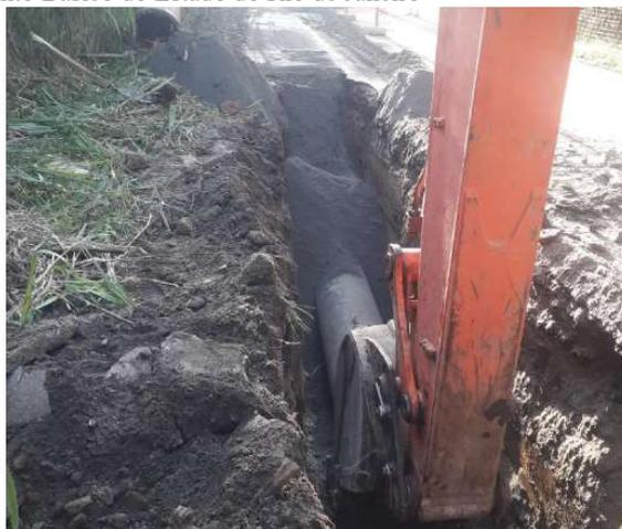
*Assentamento de tronco distribuidor, com diâmetro de 600mm na Estrada da Capoeira Grande*
