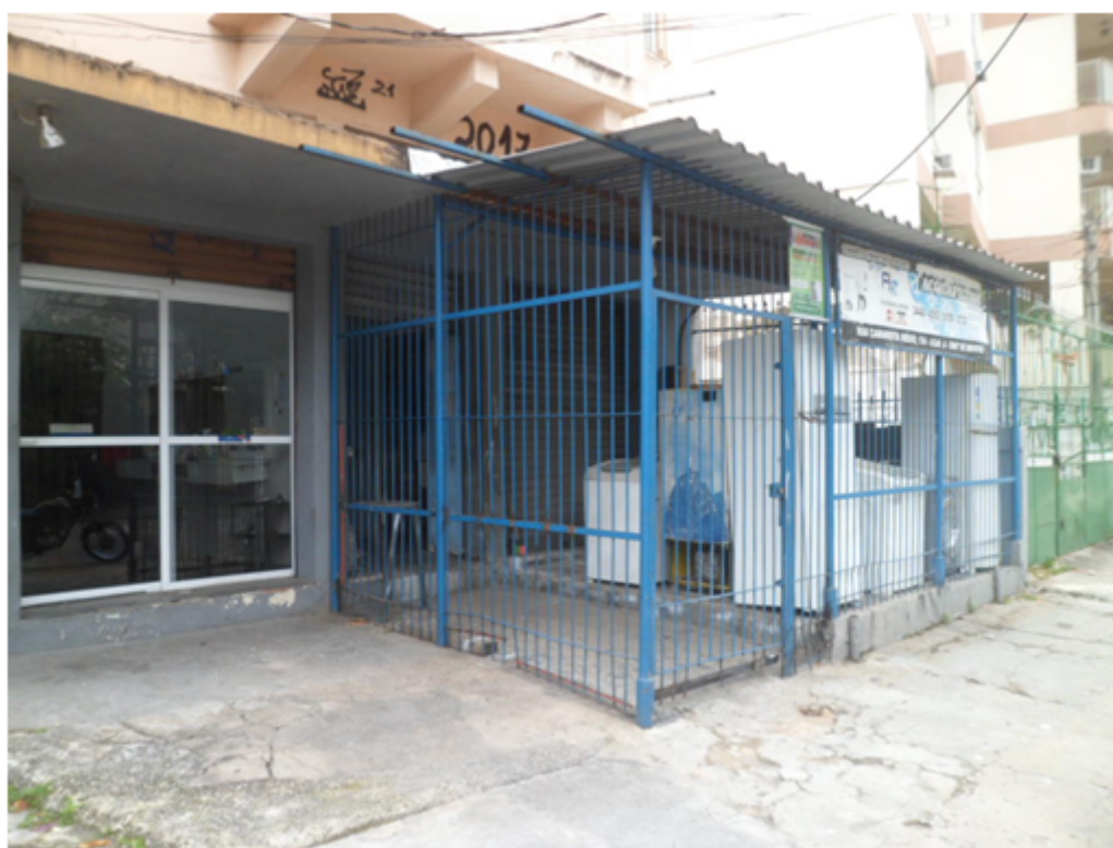
Foto 02 – Lojas A e B – Rua Camarista Meyer, 134 – Engenho de Dentro
