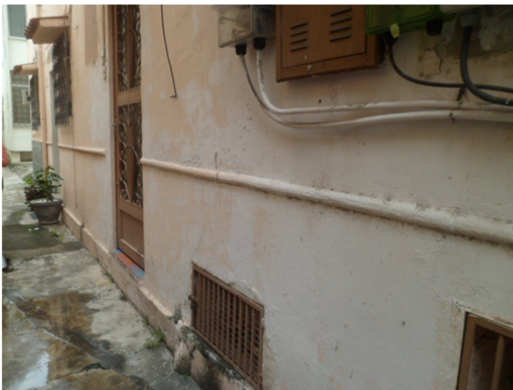
Foto 06 – Hidrômetro do Apartamento 101
