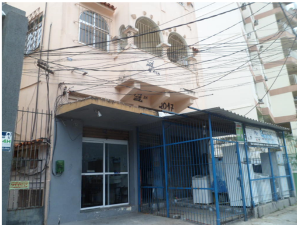
Foto 01 – Fachada do Prédio – Rua Camarista Meyer, 134 – Engenho de Dentro
