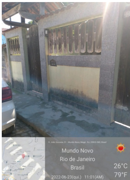
Fachada da Residência do Reclamante
