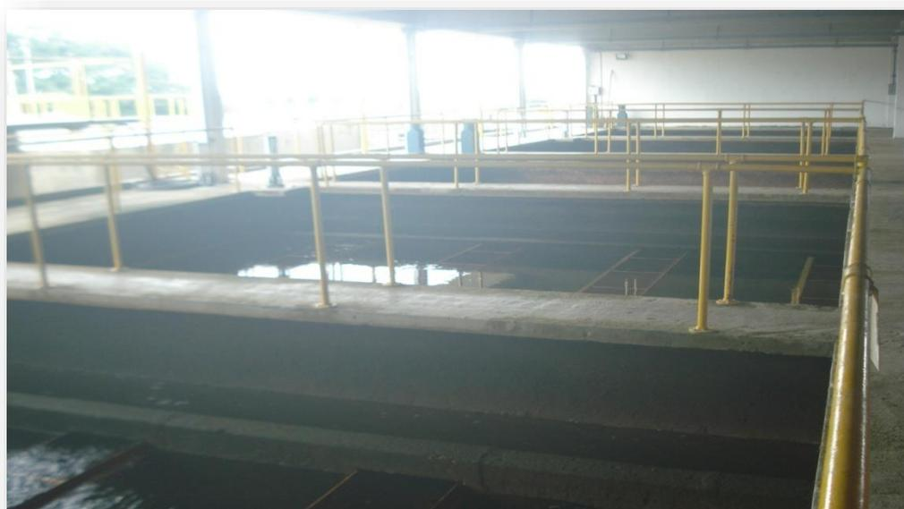
Foto 18 – Tanques de Filtros
